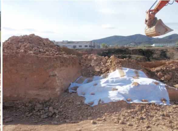
Protección de estrato fosilífero para su excavación futura.
