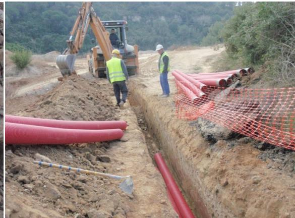
Realización de zanja para colocar tubería
