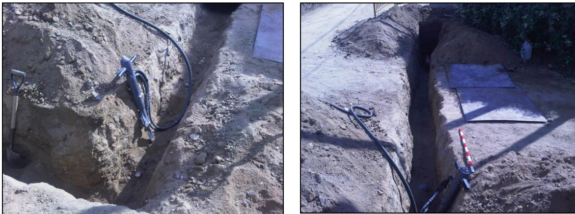
Fig.11. Vistes generals de la rasa oberta
