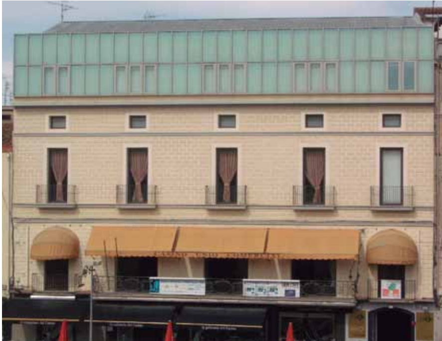
Actual façana del Casino
