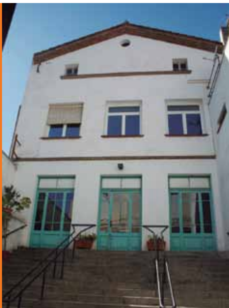
Façana d'accés al teatre del Centre Moral d'Arenys de Munt.
