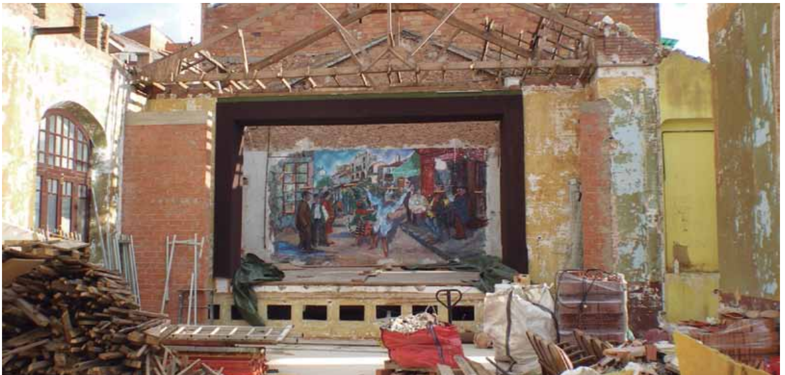
Obres del teatre de la Societat Sant Telm de Corbera de Llobregat
