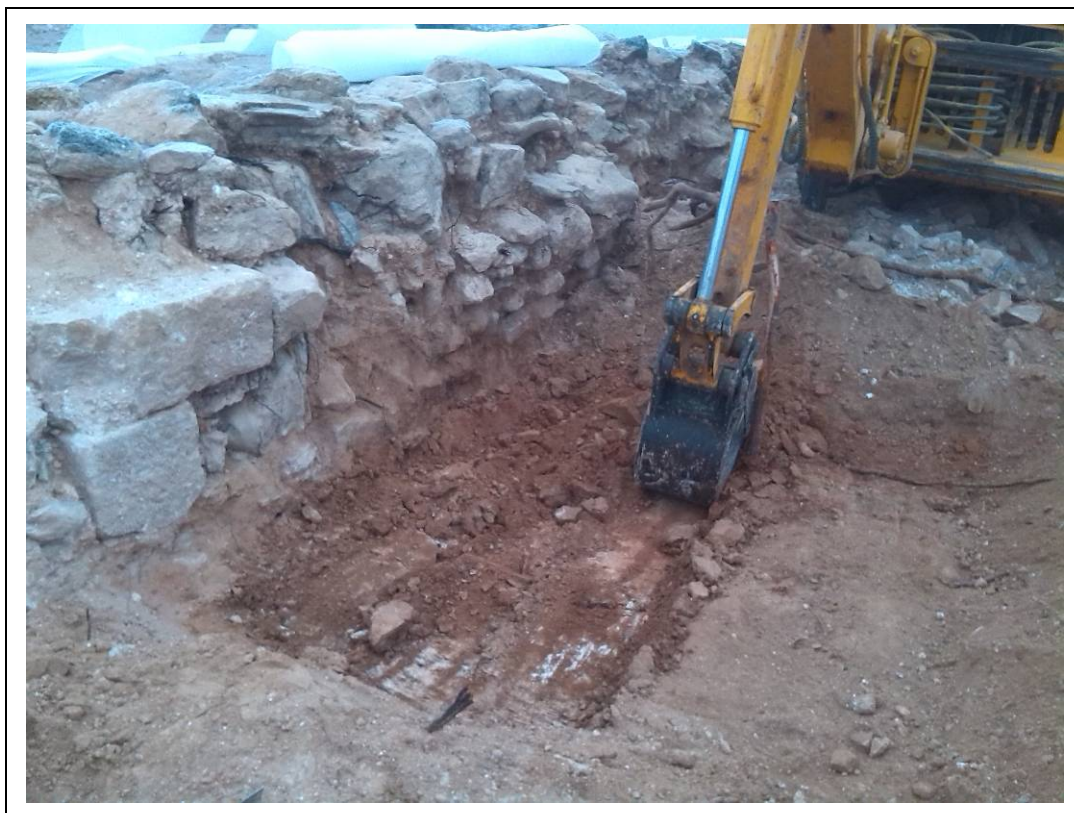
Foto 96: Sondeig 2. Inici del rebaix amb màquina.
