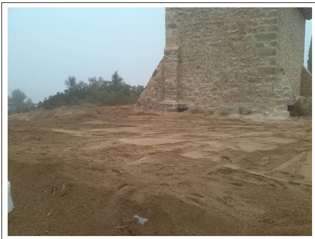
Foto: Es tapa tot amb tela geotèxtil i sorra.
