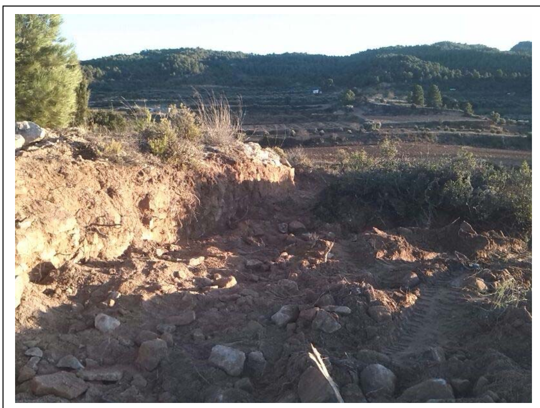
Foto 18: Vista del Mur UE: 1007 i el contrafort UE: 1008. Foto feta des del nord.
