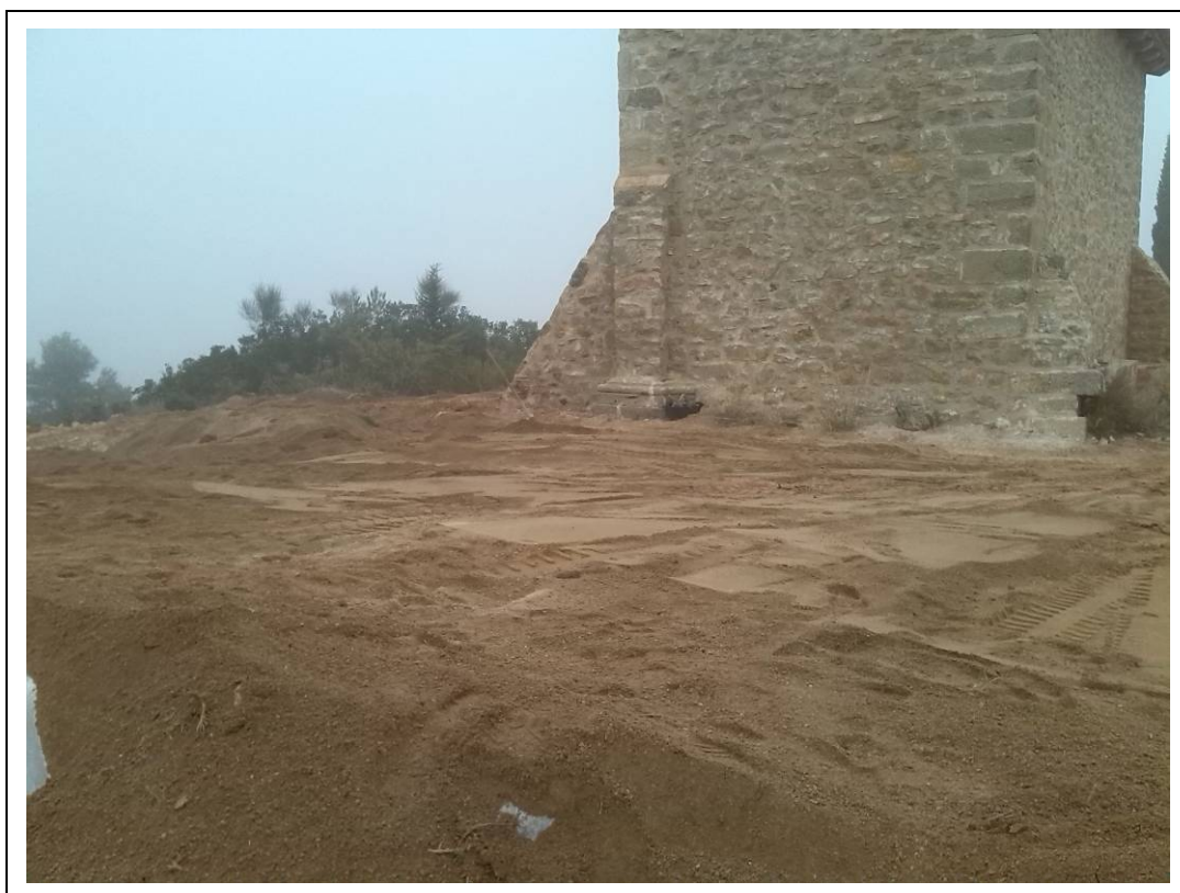
Foto 120: Es tapen les estructures amb tela geotèxtil i sorra.
