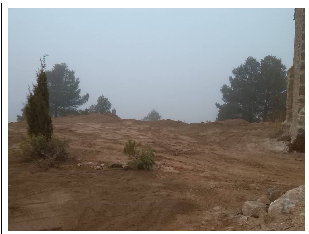
Foto 123: Es tapen les estructures amb tela geotèxtil i sorra.
