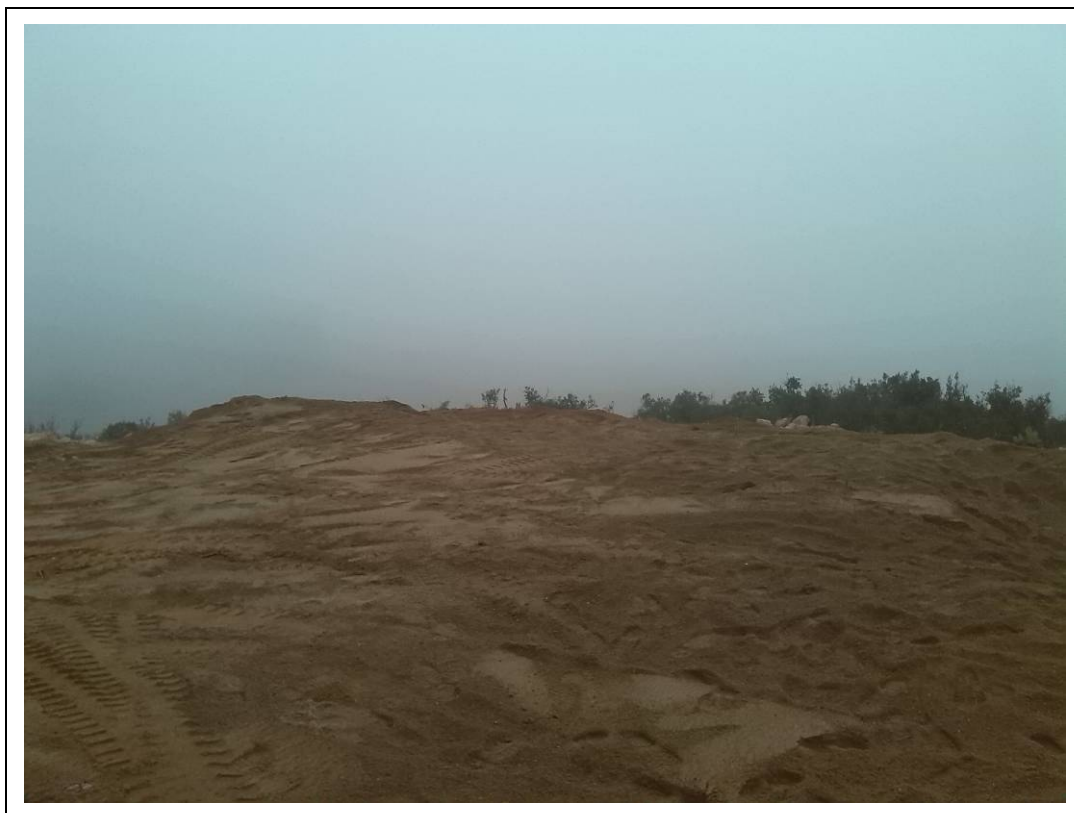
Foto 122: Es tapen les estructures amb tela geotèxtil i sorra.
