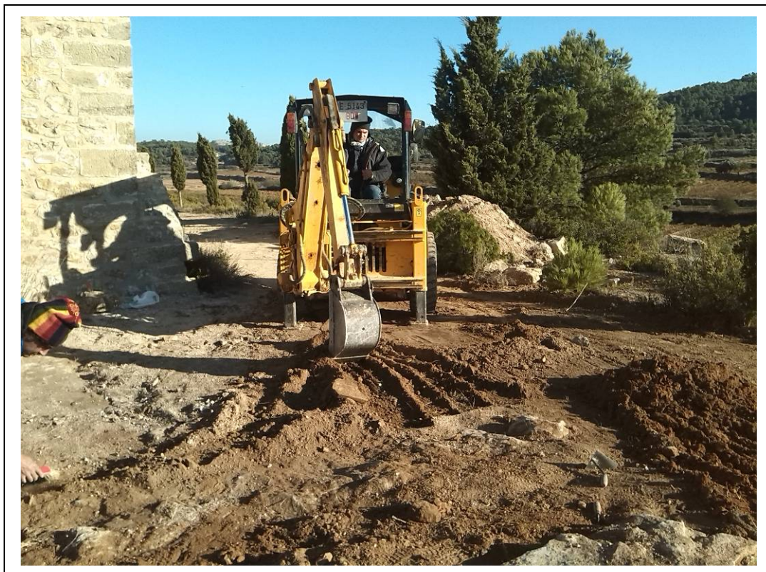
Foto 23: Procés d'excavació entre els murs UE: 1014 i 1015.
