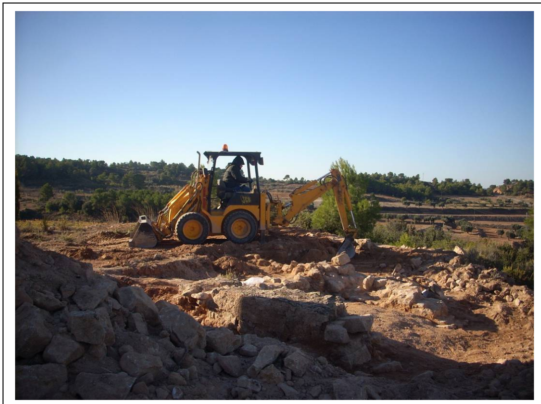
Foto 12: Vista dels treballs d'excavació.
