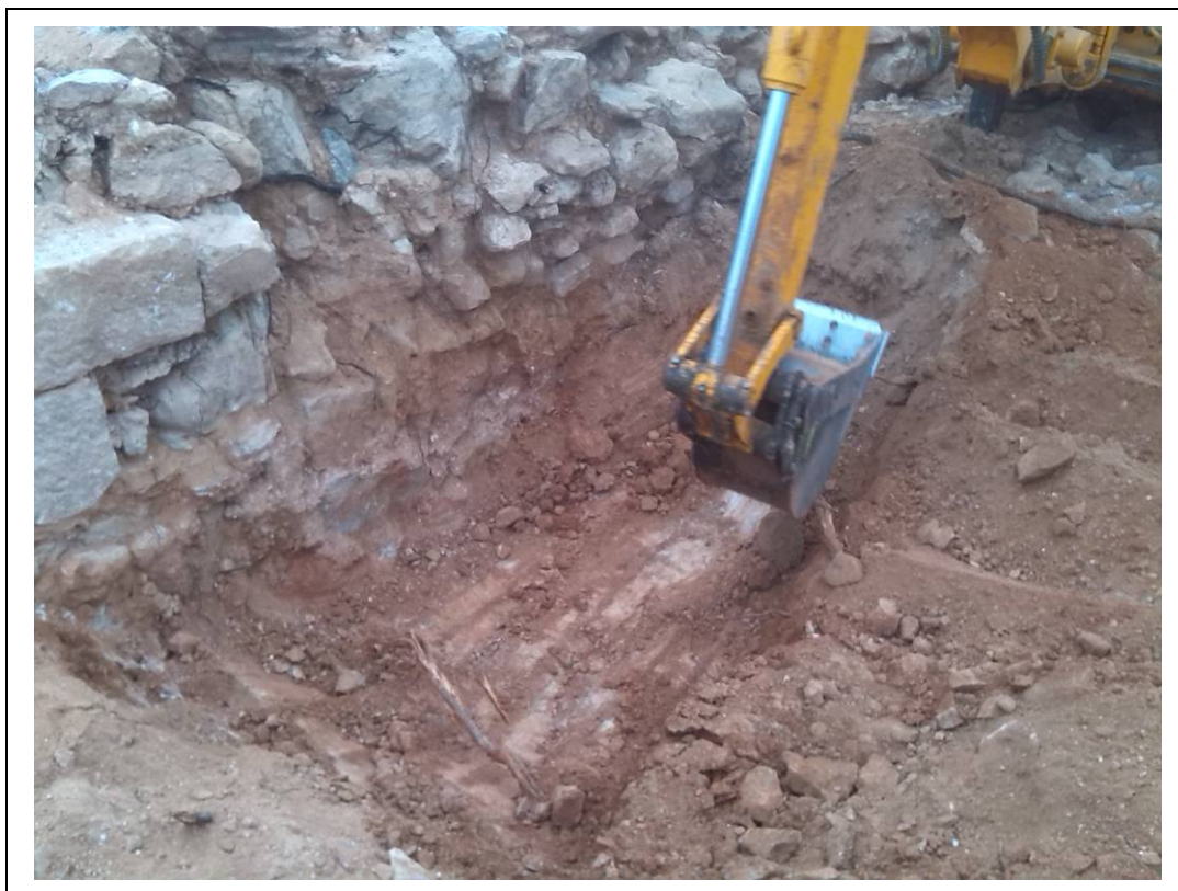
Foto 98: Sondeig 2. Procés d'excavació.
