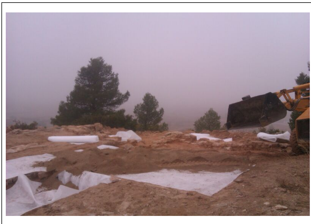
Foto 115: Es tapen les estructures amb tela geotèxtil i sorra.
