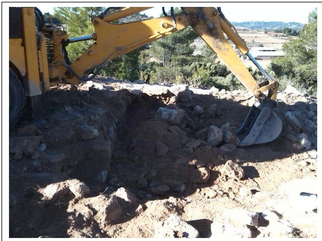
Foto 15: Procés d'excavació de l'enderroc UE: 1000. Vista del mur UE: 1007.
