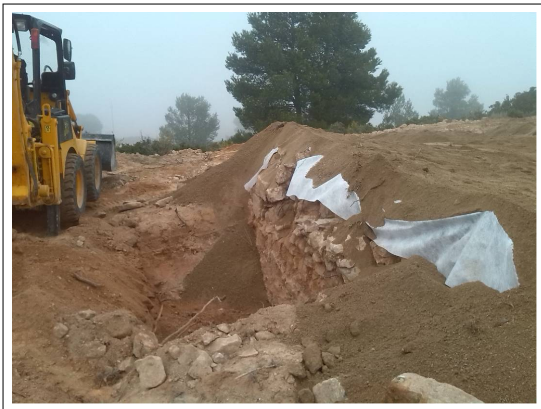
Foto 117: Es tapen les estructures amb tela geotèxtil i sorra.
