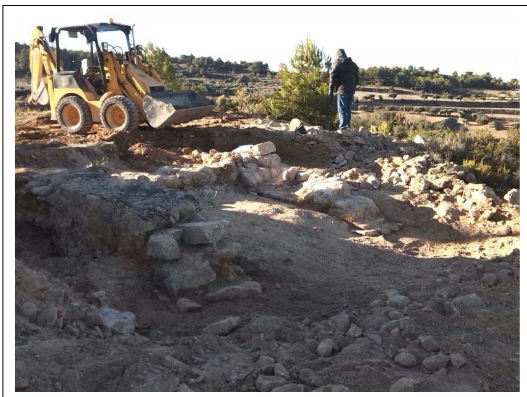
Foto 11: Vista dels contraforts UE: 1003 i 1006.
