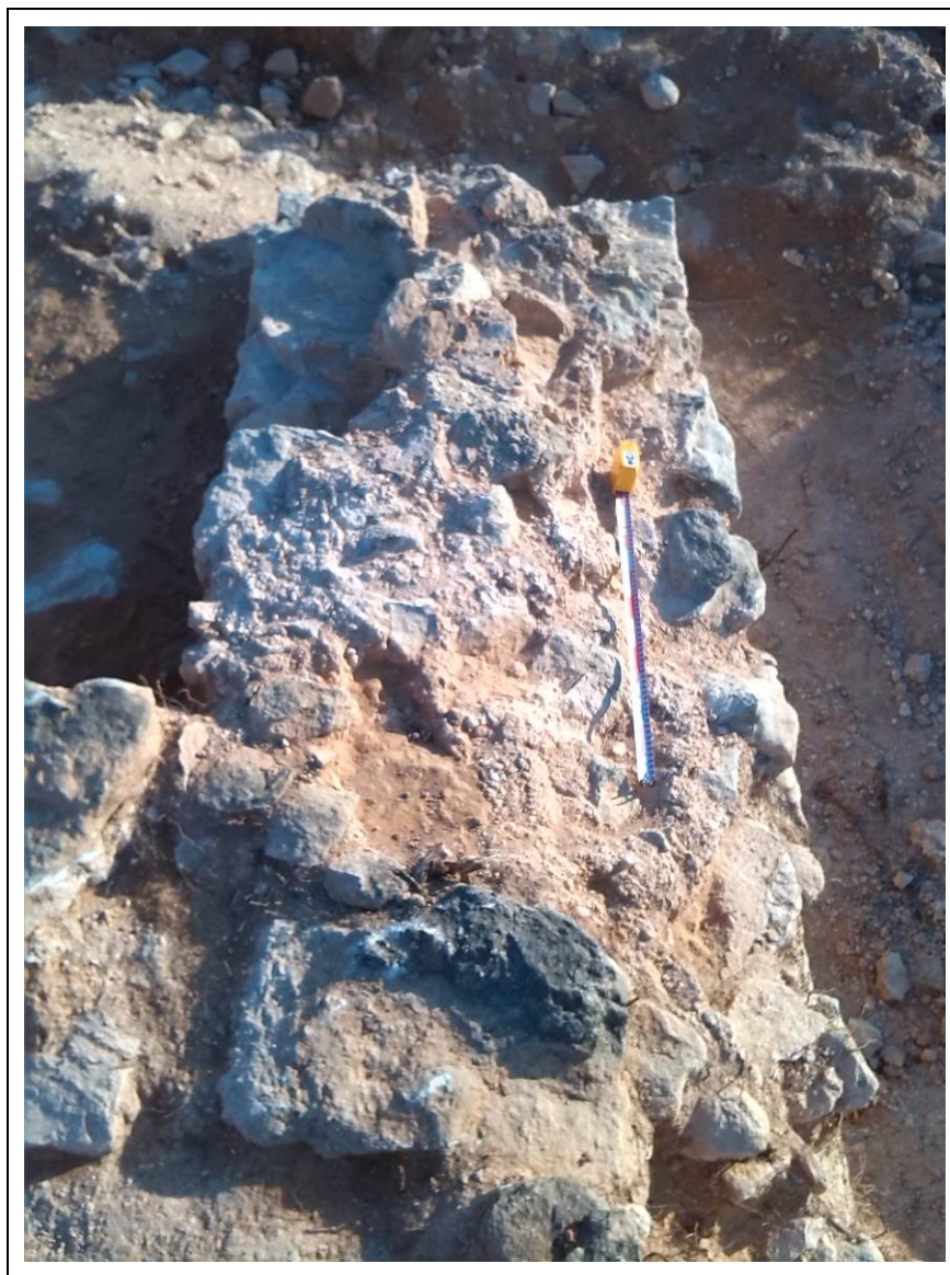
Foto 63: Contrafort UE: 1008. Foto feta des del nord.
