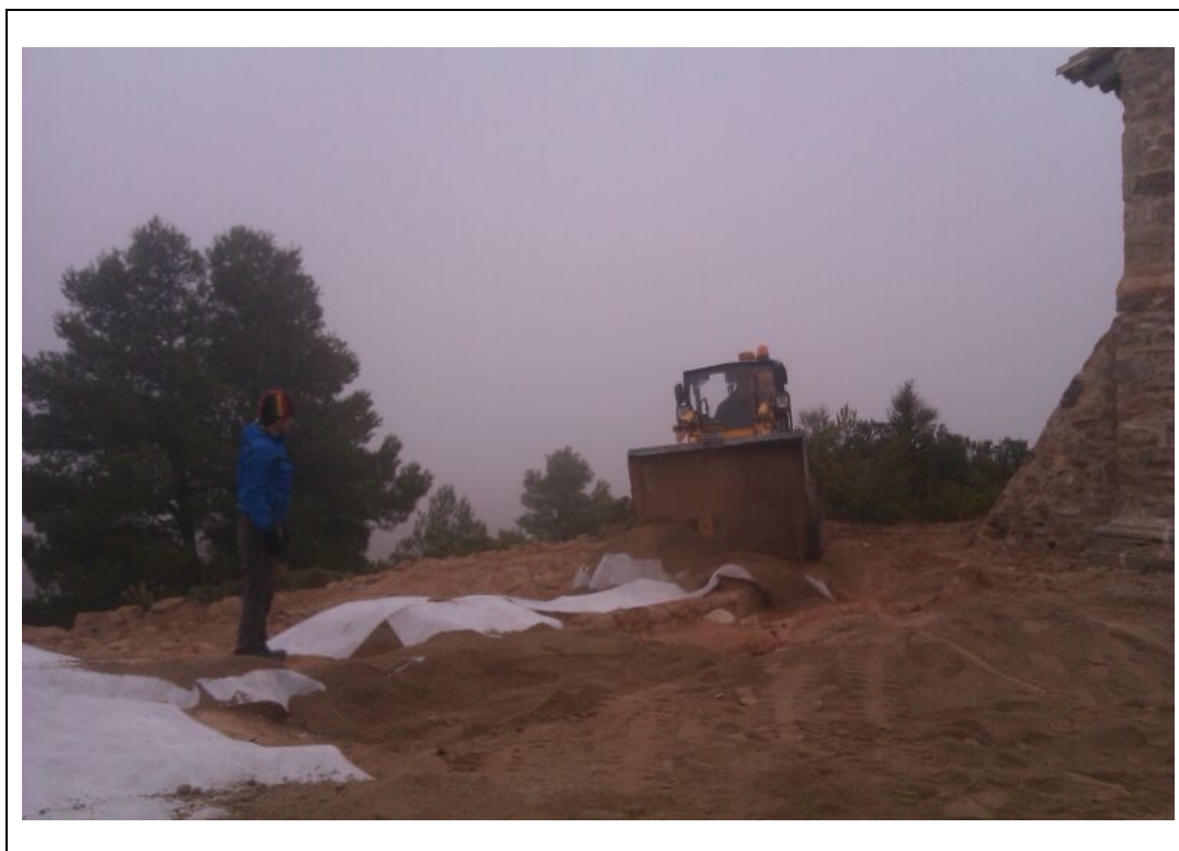
Foto 113: Es tapen les estructures amb tela geotèxtil i sorra.
