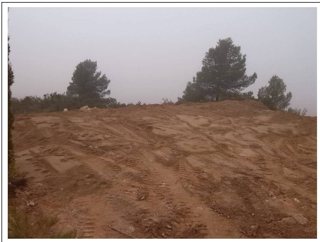
Foto 121: Es tapen les estructures amb tela geotèxtil i sorra.
