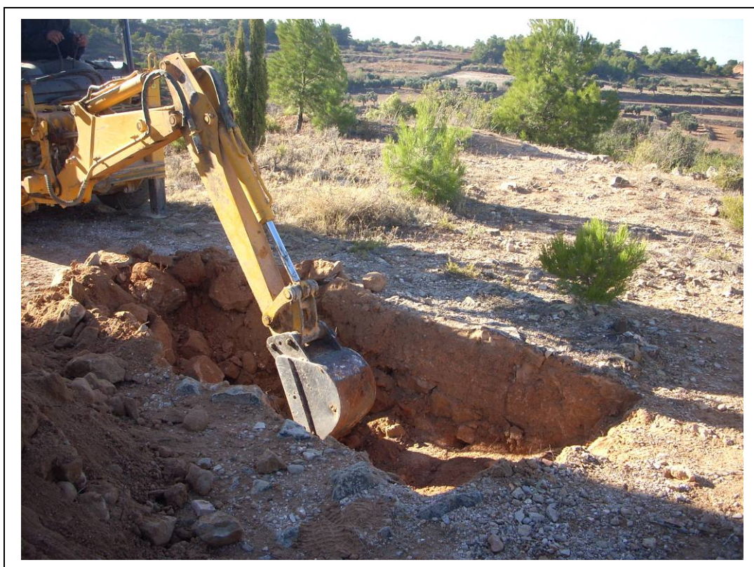
Foto 8: Inici de la intervenció resseguint el mur UE: 1001.
