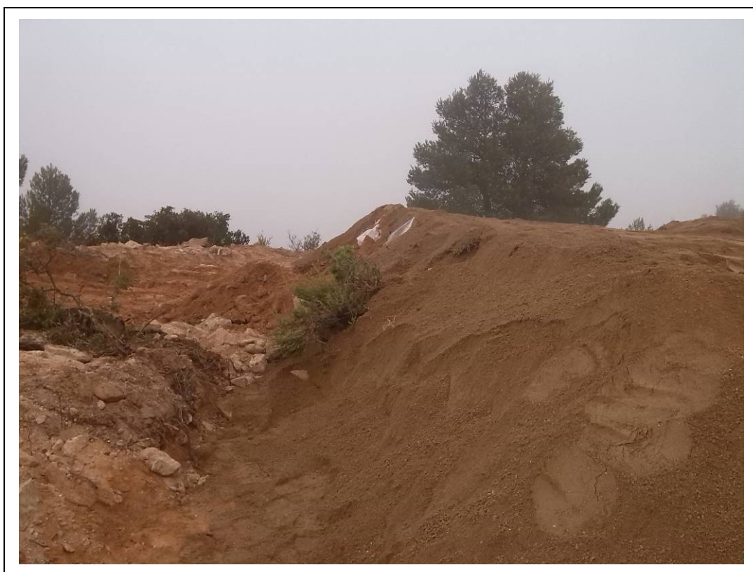
Foto 119: Es tapen les estructures amb tela geotèxtil i sorra.
