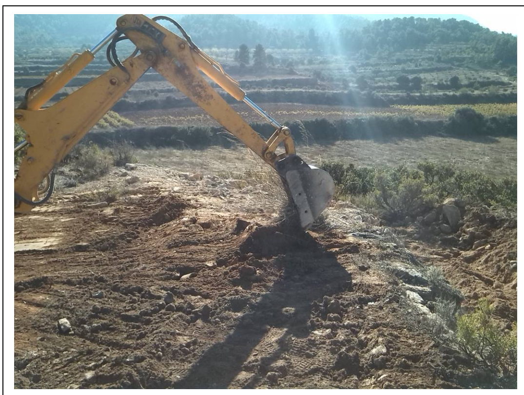
Foto 20: Procés d'excavació. Zona de la capçalera i mur UE: 1007.
