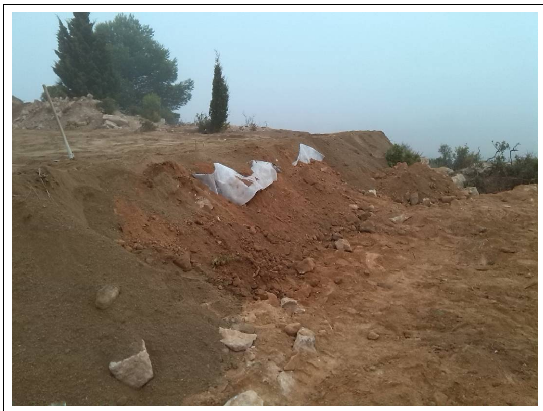
Foto 118: Es tapen les estructures amb tela geotèxtil i sorra.
