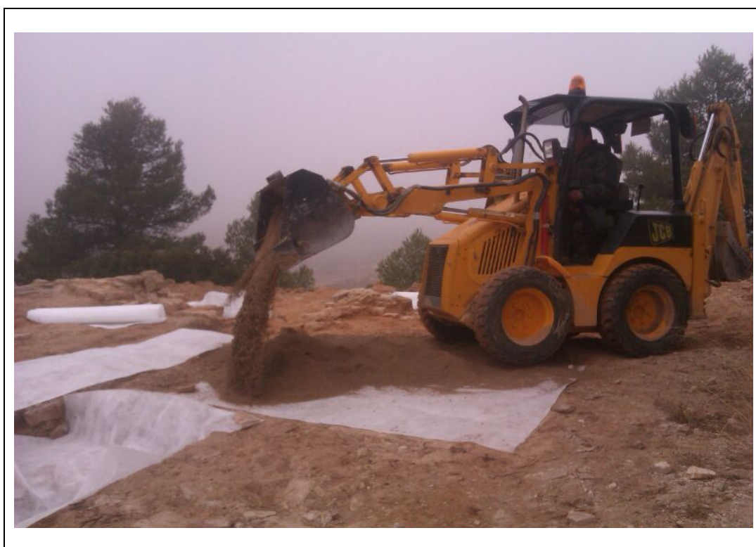
Foto 116: Es tapen les estructures amb tela geotèxtil i sorra.
