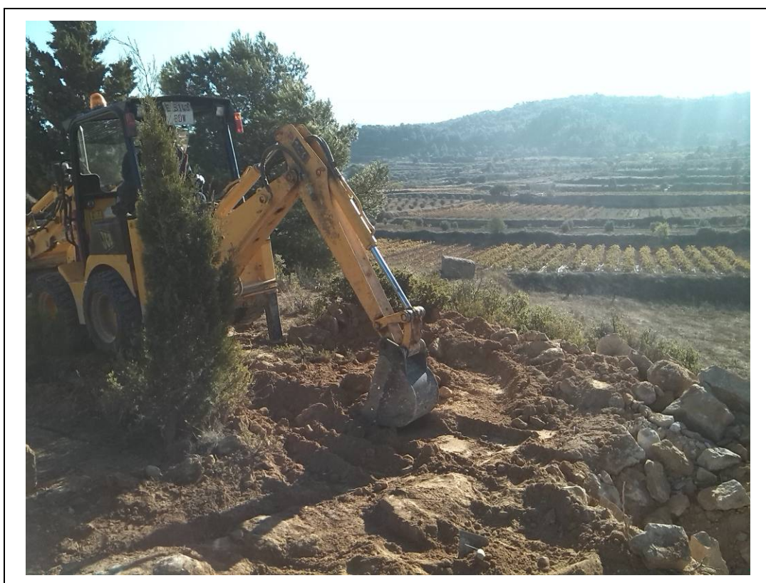
Foto 28: Descobrint el contrafort UE: 1011.
