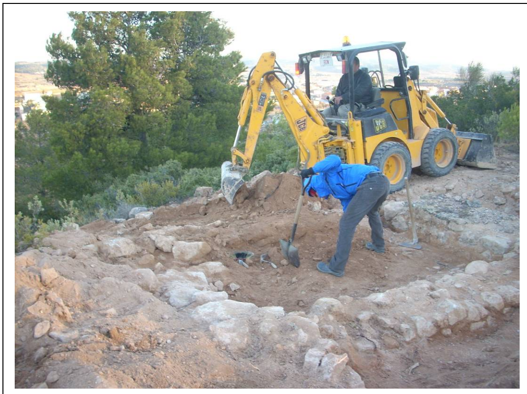
Foto 9: Vista del murs UE: 1001 i 1002 durant l'excavació i extracció de l'estrat d'enderroc.
