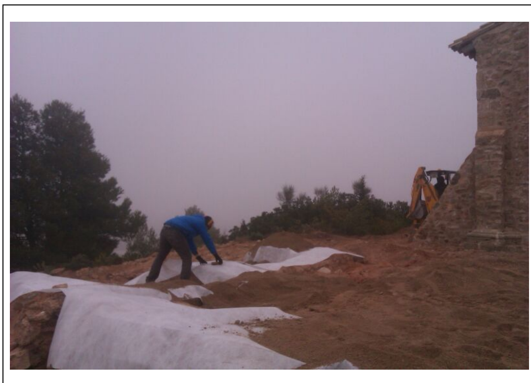
Foto 114: Es tapen les estructures amb tela geotèxtil i sorra.
