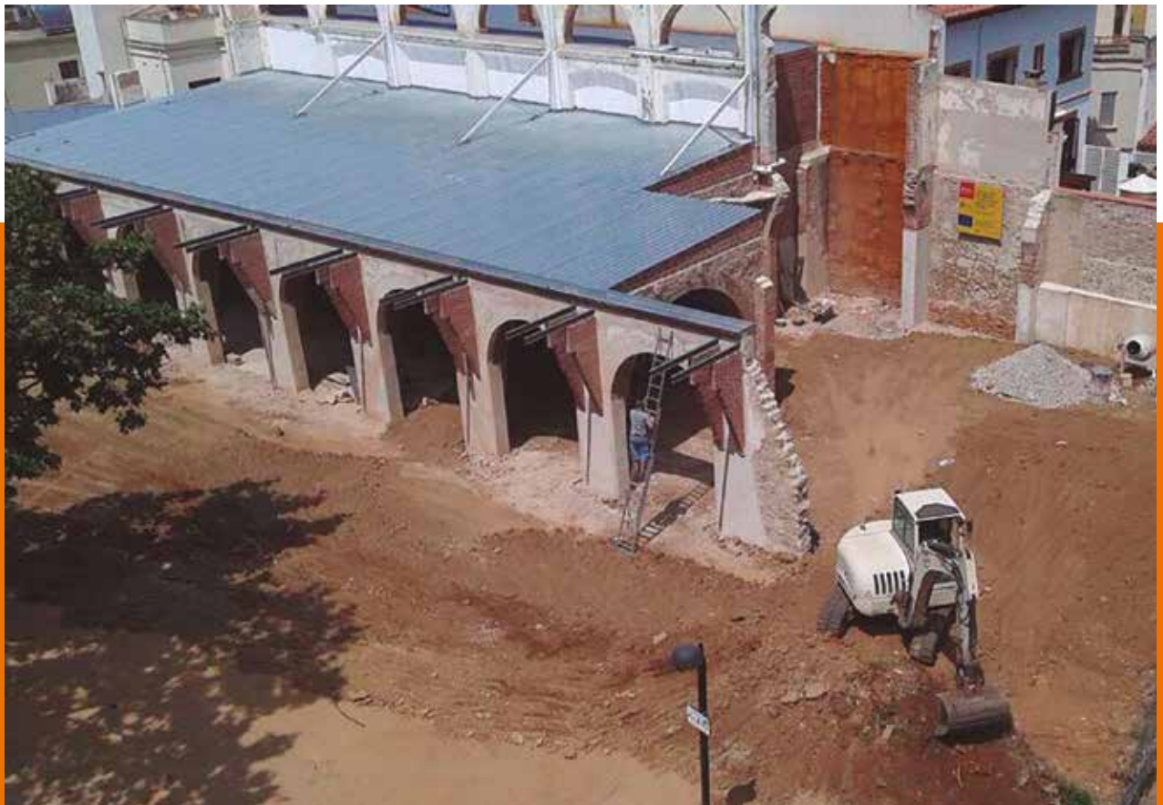
Obres a l'Odèon durant l'any 2015
