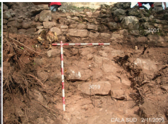
Contrafort UE 3019 a la Cala Sud
