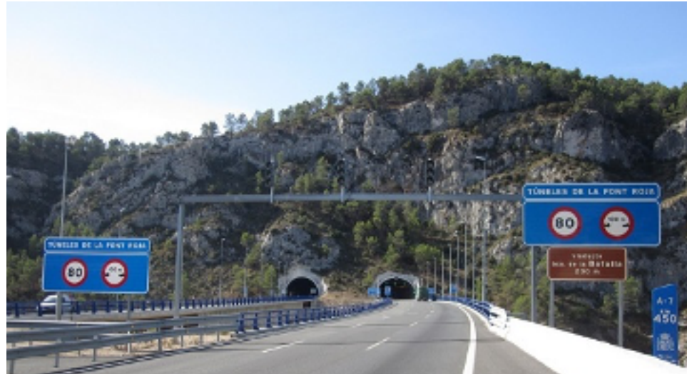
Figura 5. Els túnels dits, situats en l'A-7, en l'eixida d'Alcoi direcció a Ibi
