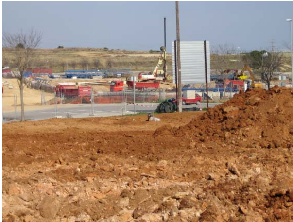
FOTO 3. Situació general de la fossa UE 05
