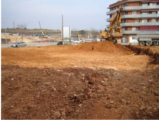
FOTO 1. Realització dels treballs de rebaixament del sòl
