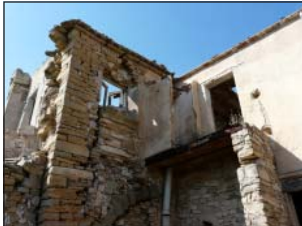
Vista del petit lavabo construït contemporàniament adossat a la part alta de MR-1
