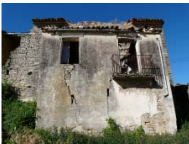
Vista general de la façana des del carrer Major. S'observa en primer terme el cos adossat el segle XIX. AL darrera el cos principal de l'edifici.
