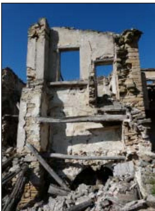
Vista de la paret que connectava el cos occidental amb el central. S'observen les diferents obertures que comunicaven els dos edificis
