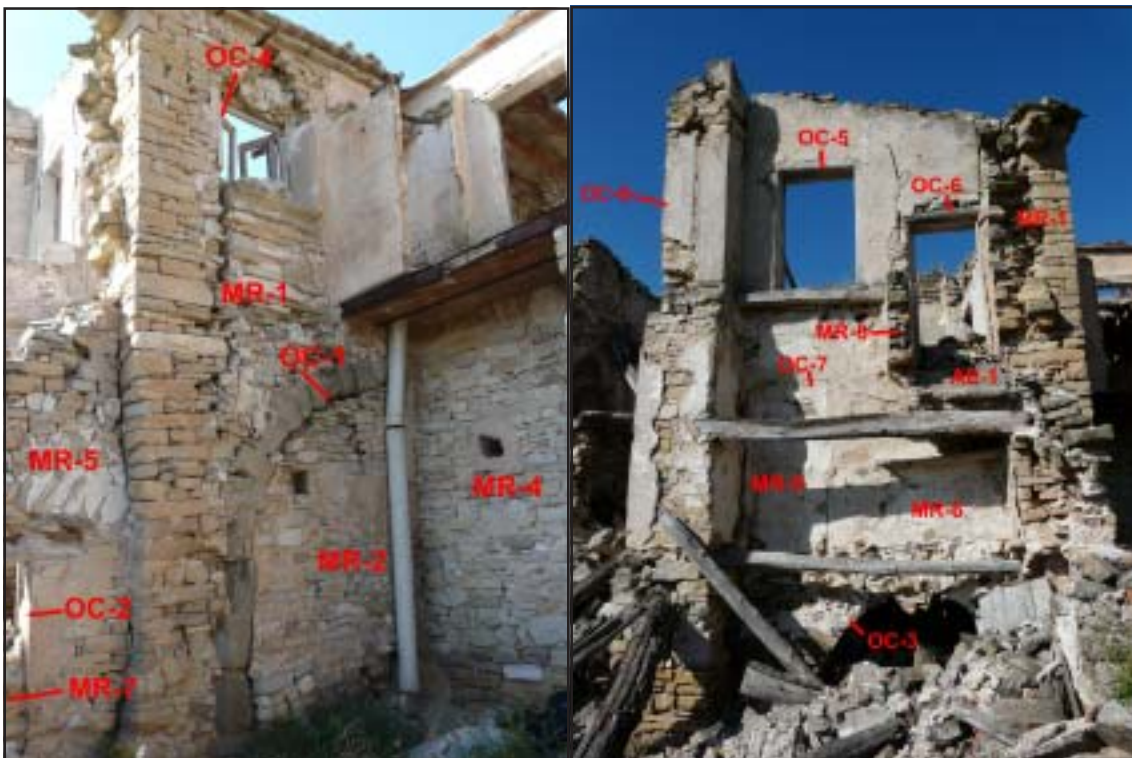
Vistes dels murs de la zona estudiada amb indicació de les diferents unitats constructives
