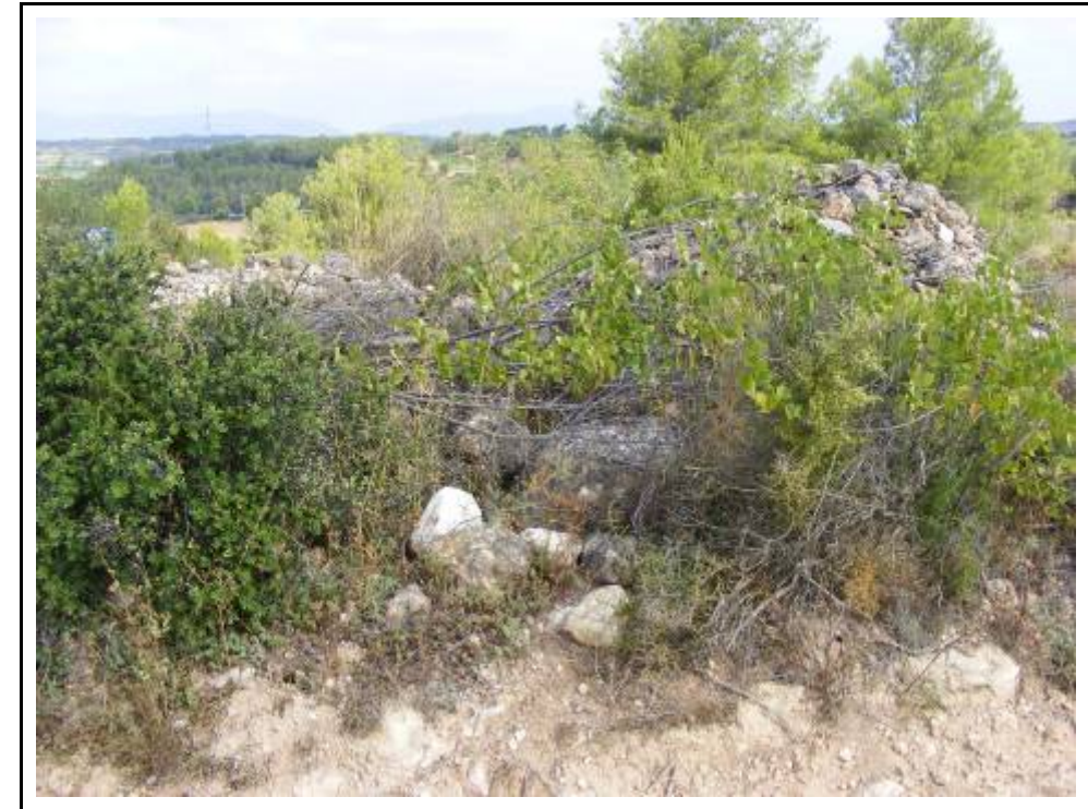
Foto 48: E.D. 2, barraca enderrocada de pedra seca..
