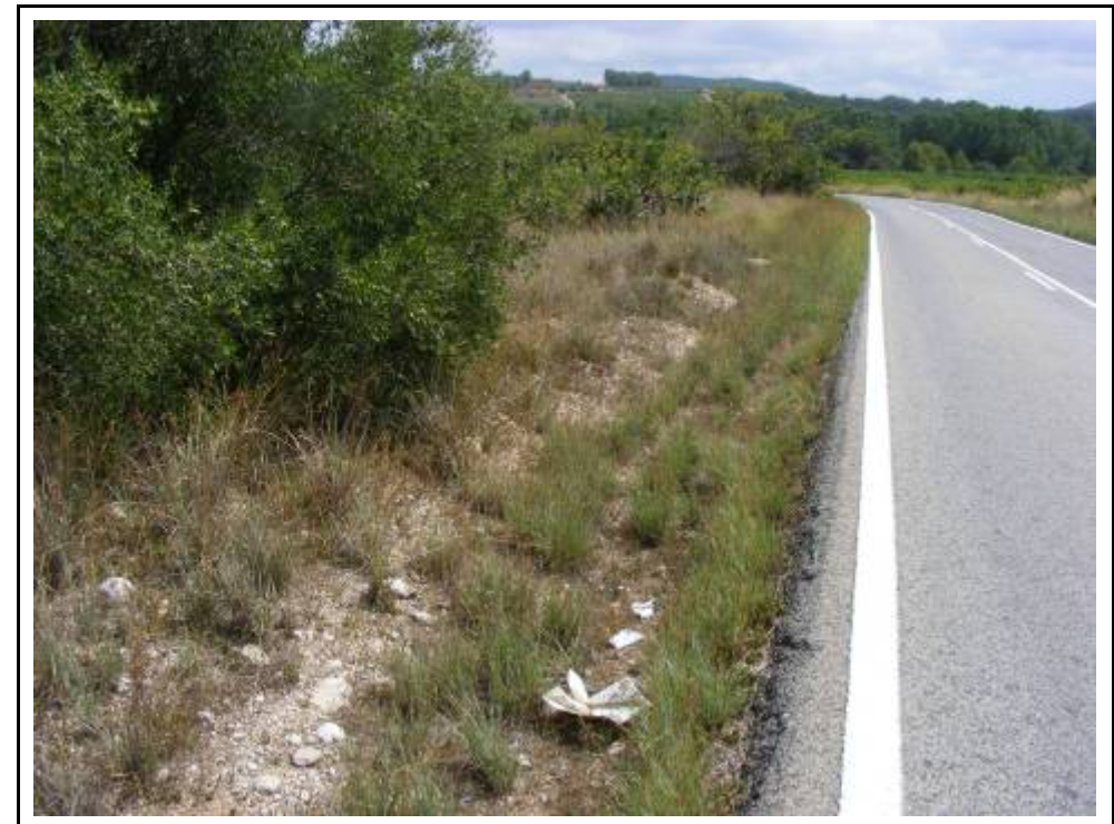
Foto 30: A.P. 6. marges de la carretera. Zona erma.
