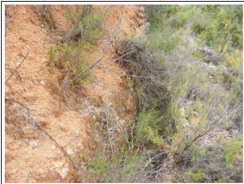
Foto 57: E.H. 1, Canalització excavada a la roca.
