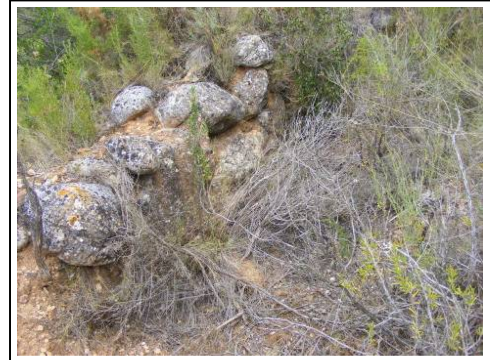
Foto 58: E.H. 1, Restes d'un mur que tanca la canalització.
