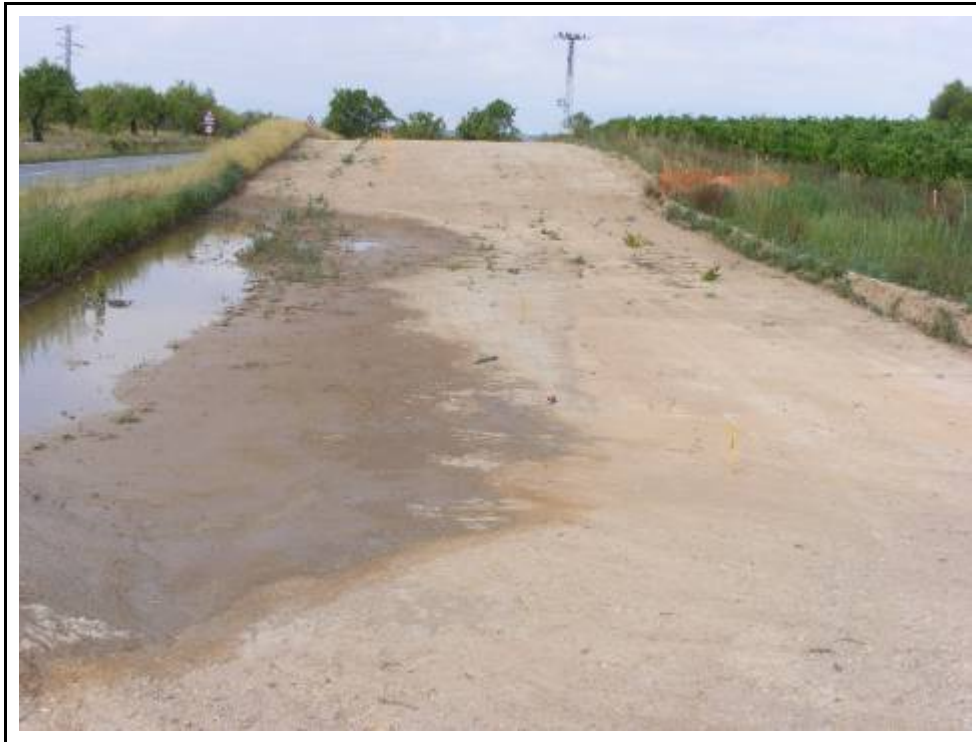
Foto 7: A.P. 1, zona en fase d'obra.
