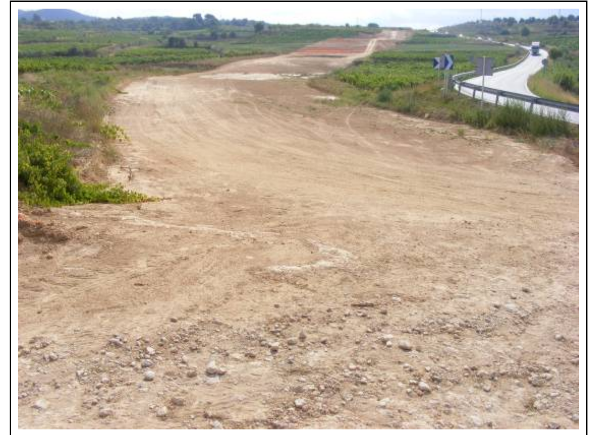
Foto 6: A.P. 1, zona en fase d'obra.
