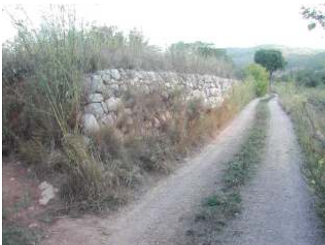
Foto 5. Imatge dels marges de pedra seca, a la vora del camí oriental que voreja els terrenys afectats.
