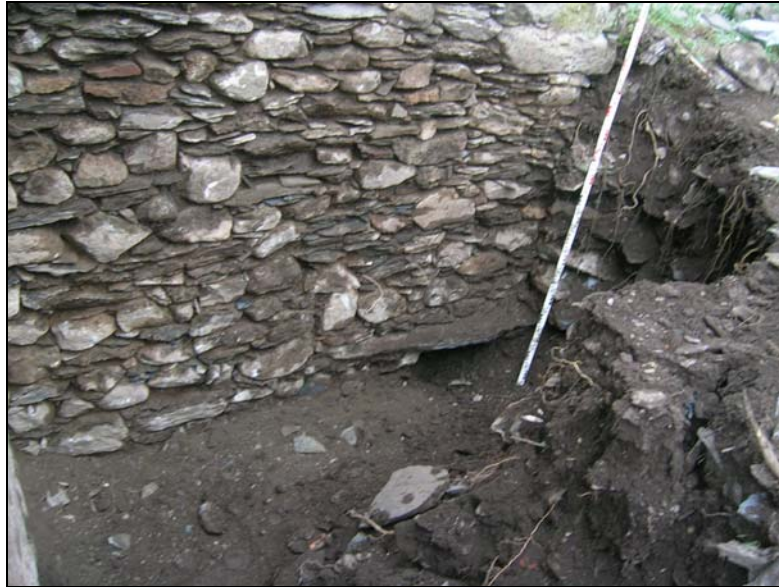
Obertura realitzada al mur nord del porxo, per facilitar el desguàs de l'aigua (cara nord).
