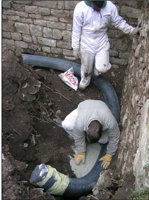
Procés d'instal·lació d'un tub per filtrar les humitats.
