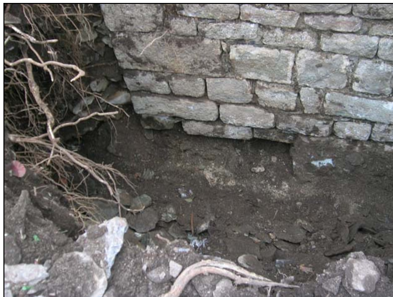
Obertura realitzada al mur nord de tancament del cementiri de l'església, per facilitar el desguàs de l'aigua (cara sud).
