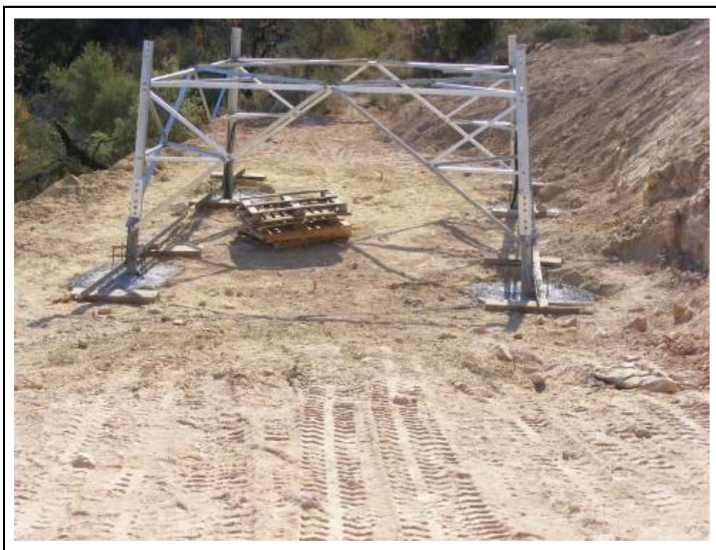
Foto 32: Suport 15 (SET Sant Antoni-Set Auliver), Suport 16 (SET Monclues-SET Sant Antoni), rebaixos per la confecció de la plataforma.
