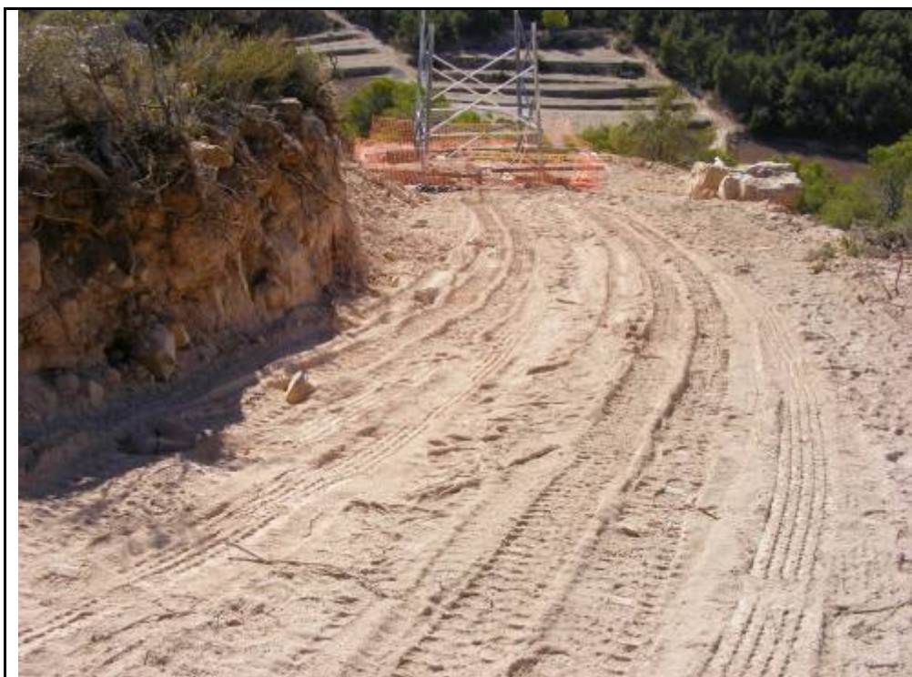
Foto 62: Suport 2, zona amb rebaixos i terraplens per la confecció de la plataforma.
