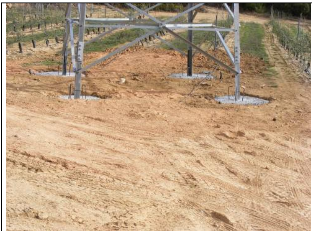
Foto 117: Suport 12, zona talada i aplanada amb l'excavació dels quatre pilars.
