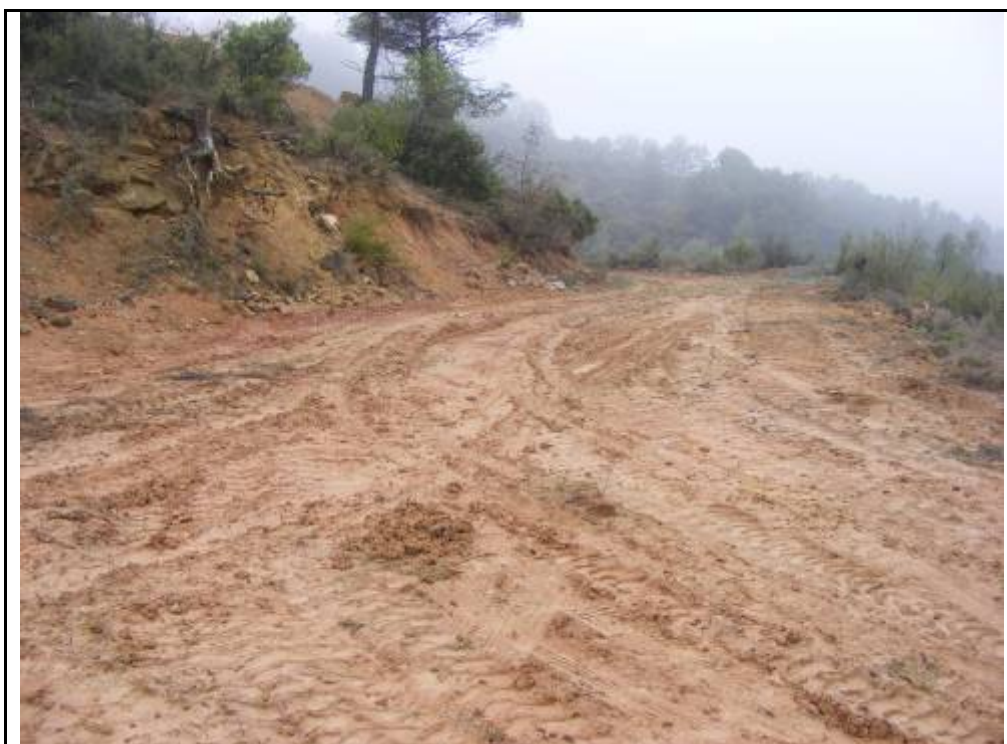
Foto 51: Suport 7, zona rebaixada per la confecció de l'accés a la plataforma.
