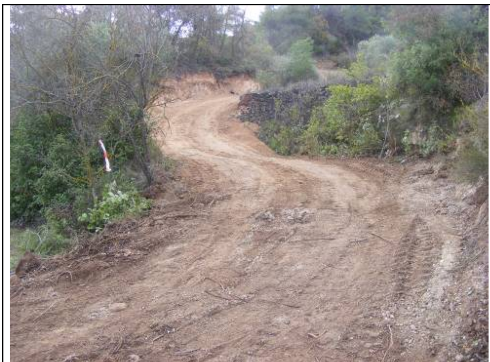
Foto 91: Suport 22, zona talada, desbrossada i amb rebaixos per la confecció del camí d'accés a la plataforma.
