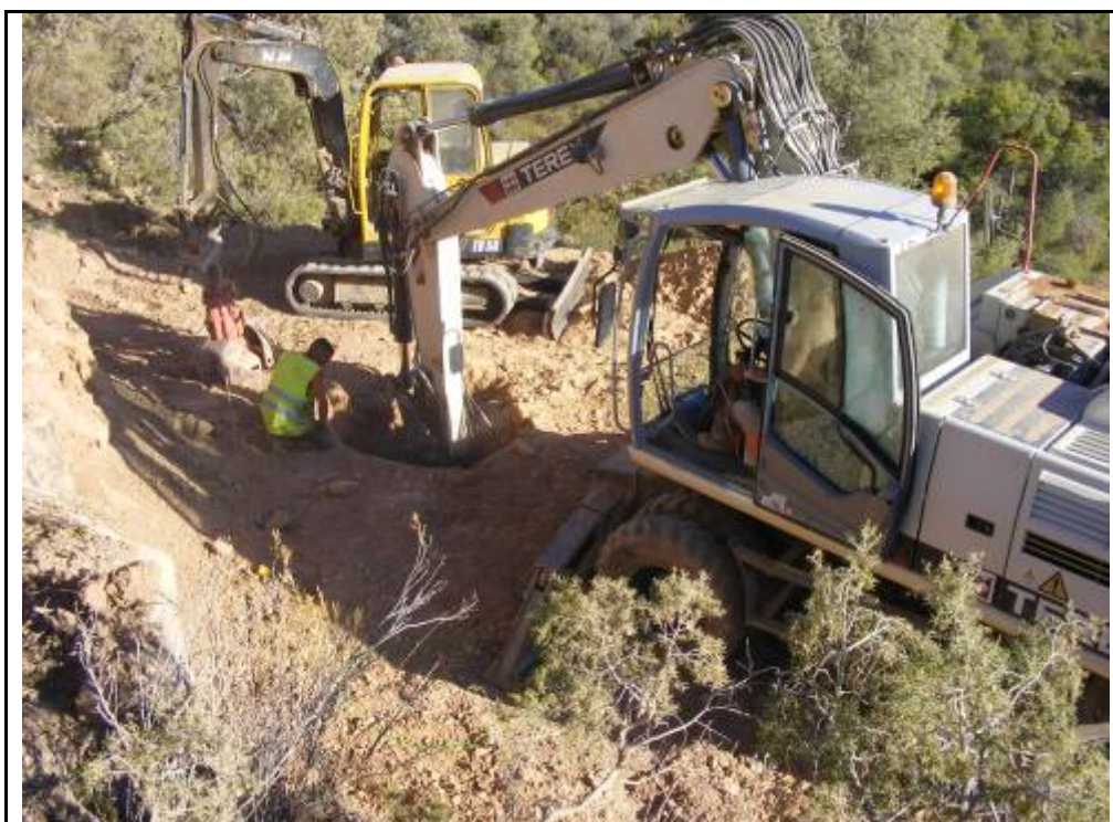
Foto 59: Suport 3, zona amb rebaixos per la confecció de la plataforma.
