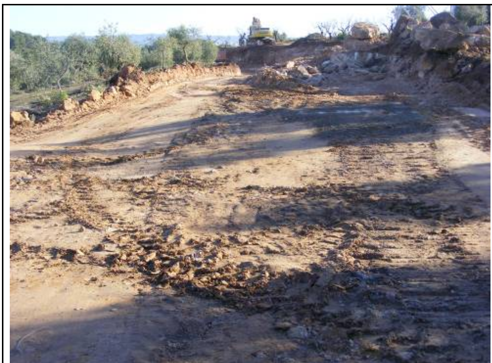
Foto 113: Suport 14: obres dels accessos al aerogeneradors 1, 2 i 3 del PE de les Rotes (camí de les Bàssies)
