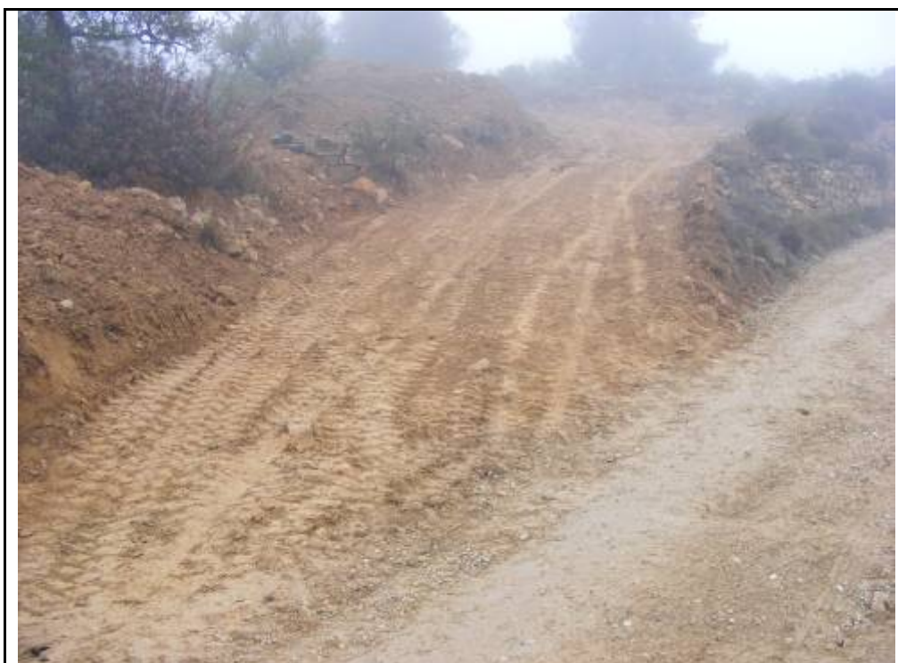
Foto 7: Accés al suport 5, zona de terrasses ermes/abandonades.
