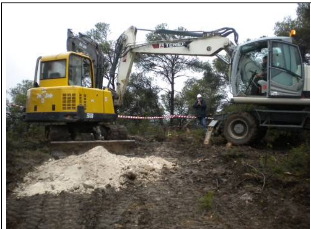
Foto 16: suport 8, excavació dels pilars.
