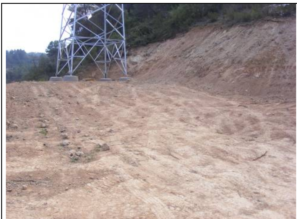
Foto 86: Suport 23, zona amb rebaixos per la confecció de la plataforma.
