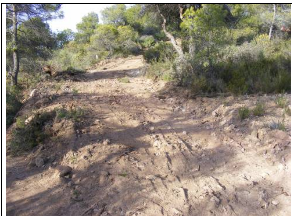
Foto 128: Suport 8, zona talada i desbrossada amb rebaixos per la confecció del camí d'accés a la plataforma.
