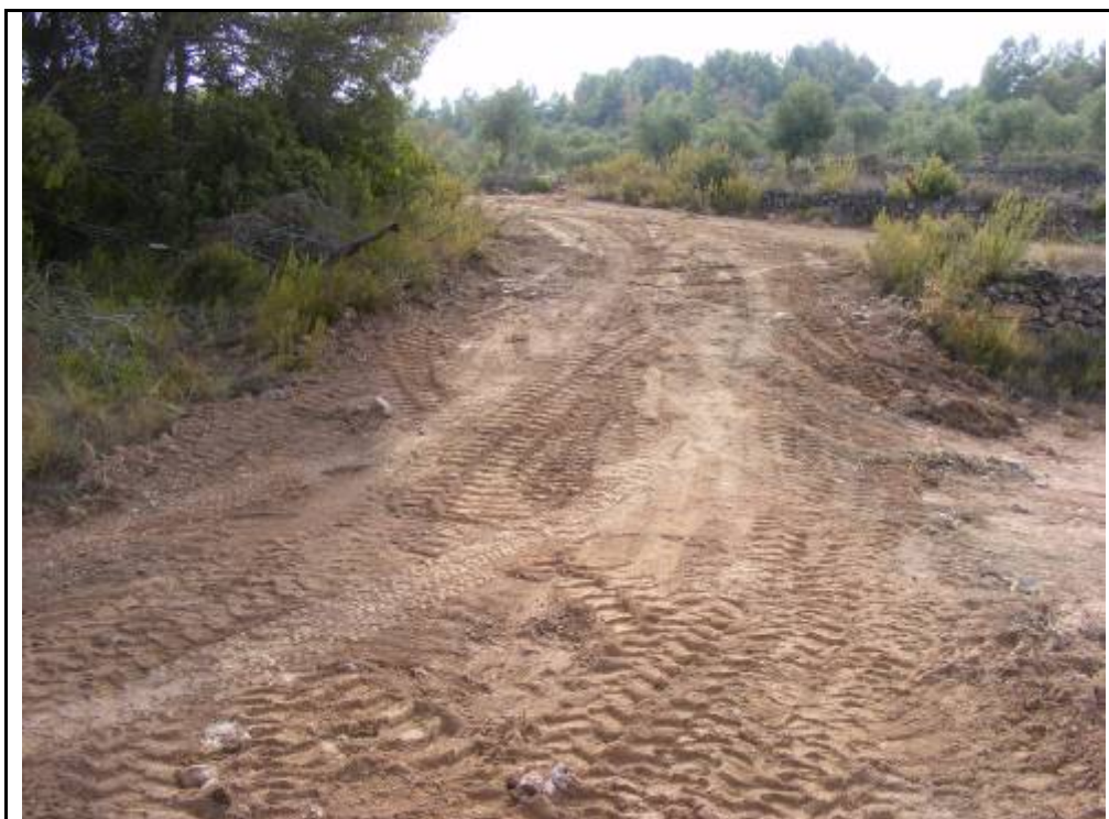
Foto 103: Suport 18, zona talada i desbrossada per la confecció del camí d'accés a la plataforma.
