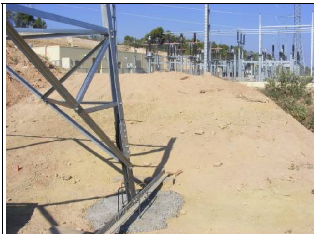
Foto 31: Suport 16 (SET Monclues-SET Sant Antoni), Suport 15 (SET Sant Antoni-Set Auliver), rebaixos per la confecció de la plataforma.
