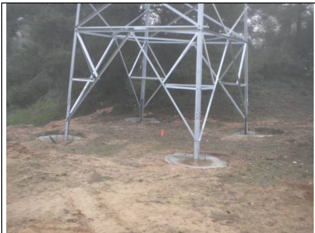
Foto 131: Suport 6, zona talada i aplanada per la confecció dels quatre pilars.
