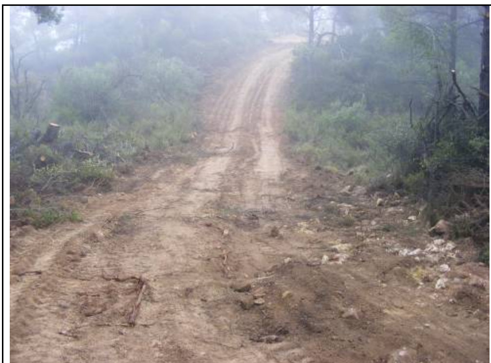
Foto 47: Suport 9, zona talada i desbrossada per la confecció de l'accés a la plataforma.
