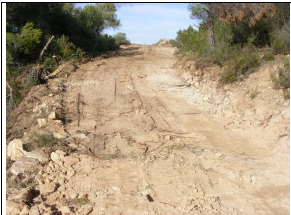
Foto 125: Suport 9, zona talada i desbrossada amb rebaixos per la confecció del camí d'accés a la plataforma.
