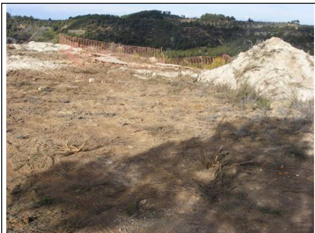
Foto 124: Suport 9, zona talada i desbrossada per la confecció dels quatre pilars. Afloraments de roca.
