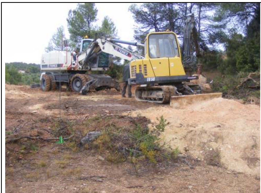
Foto 111: Suport 15, excavació dels quatre pilars.
