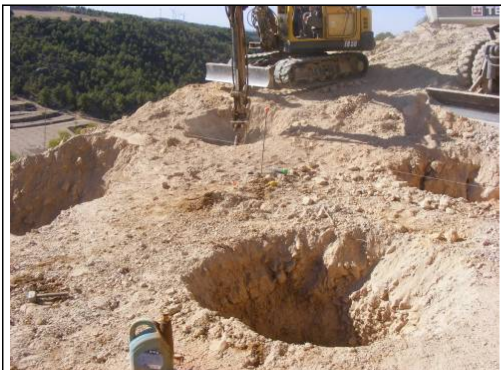
Foto 65: Suport 1 (SET Sant Antoni-SET l'Auliver), suport 31 (SET l'Auliver - SET les Rotes), zona amb rebaixos i terraplens per la confecció de la plataforma.
