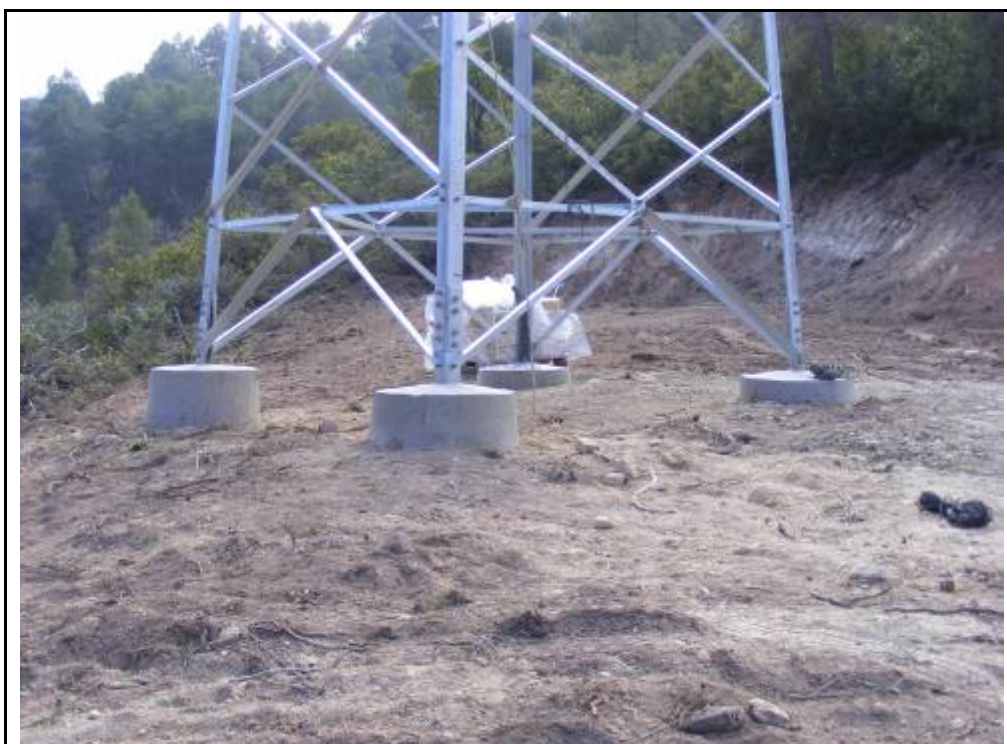
Foto 90: Suport 22, zona amb rebaixos per la confecció de la plataforma.
