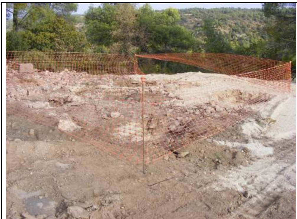
Foto 105: Suport 17, zona talada i terraplenada per la confecció de la plataforma.
