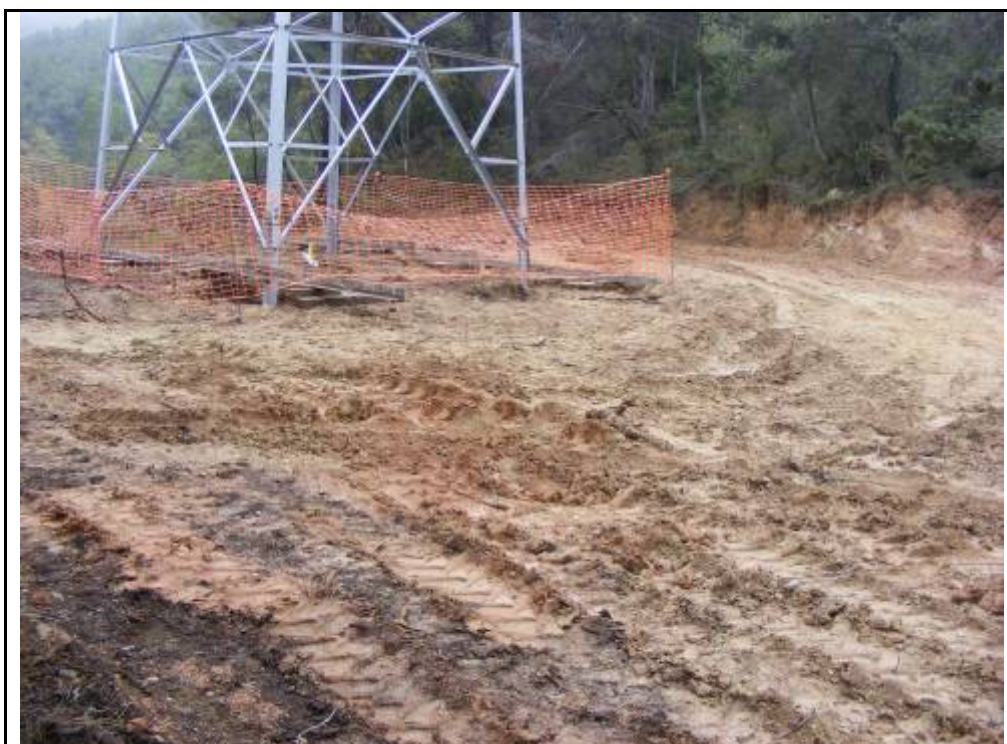
Foto 53: Suport 6, zona rebaixada per la confecció de la plataforma.
