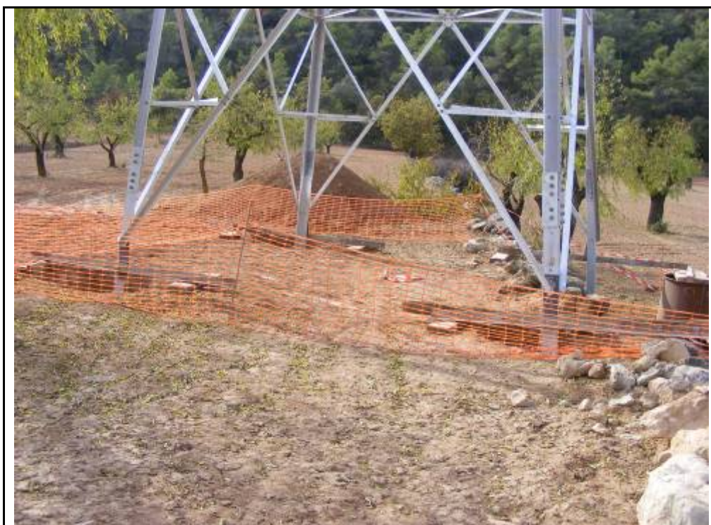
Foto 78: Suport 26, zona amb rebaixos per la confecció dels quatre pilars.
