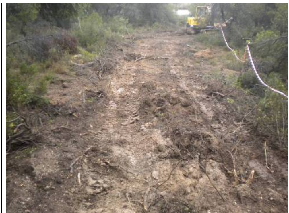
Foto 15: suport 8, desbrossament de l'accés.
