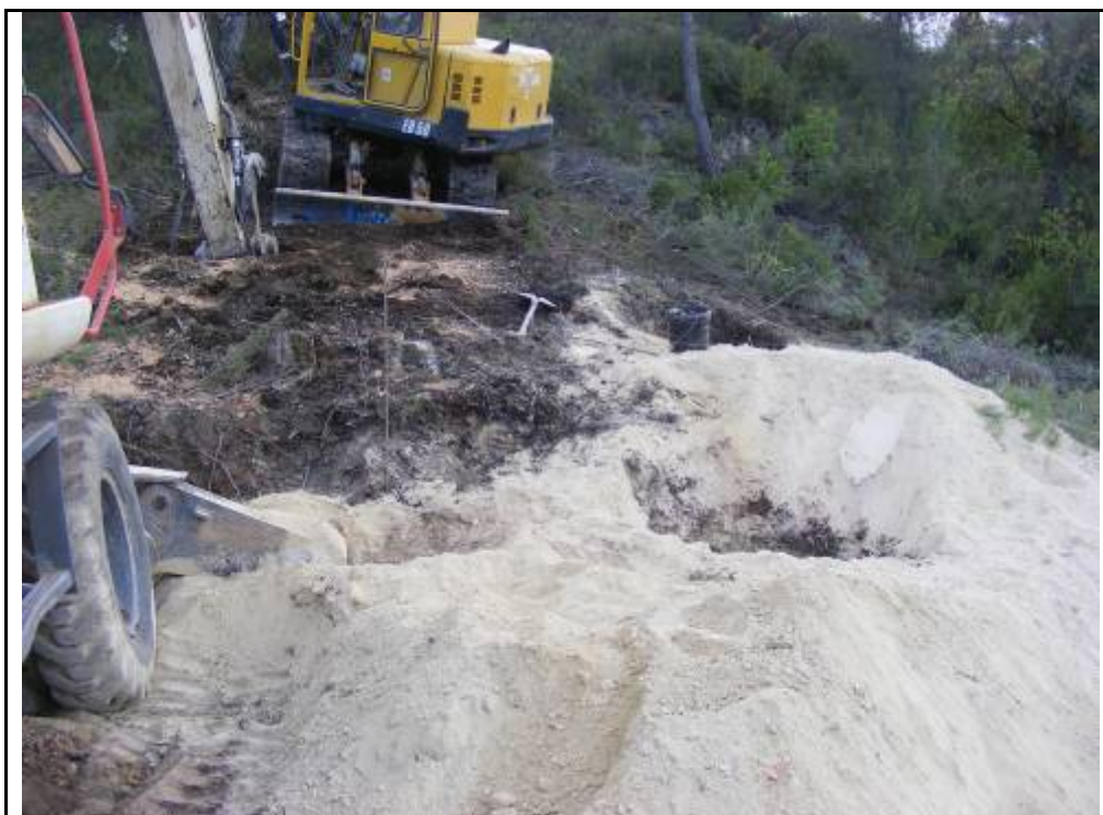
Foto 121: Suport 10, zona talada i desbrossada per la confecció dels quatre pilars.
