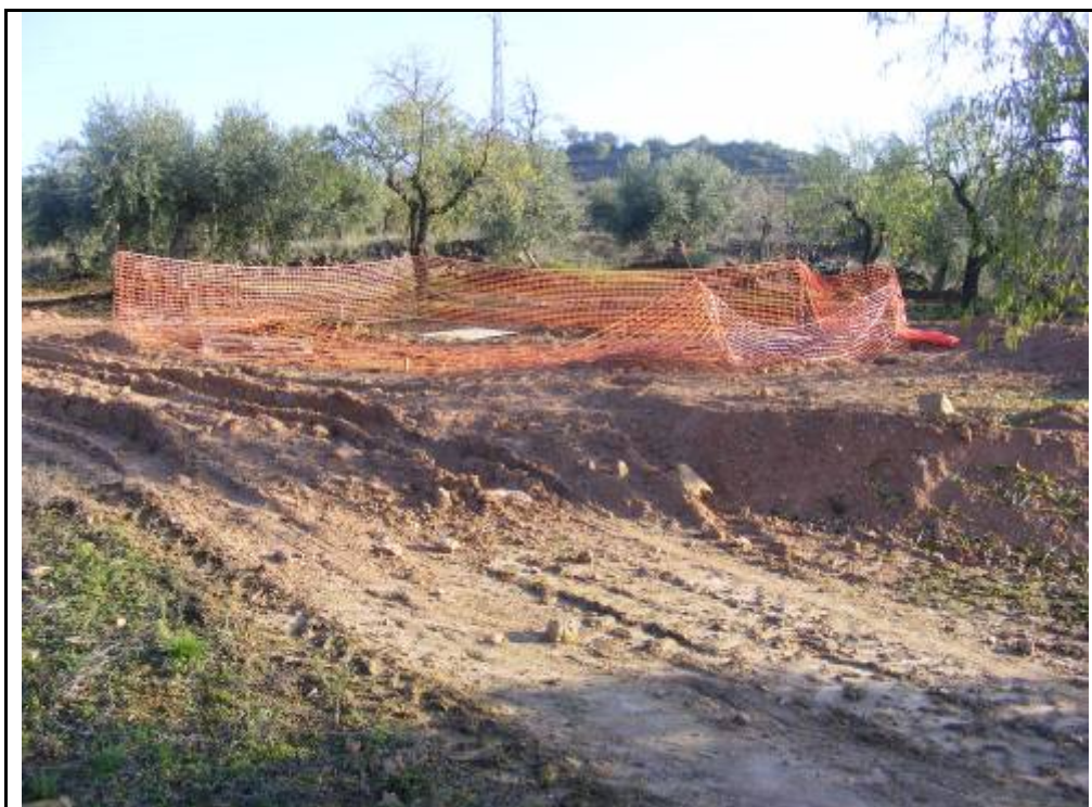
Foto 139: Suport 2, zona talada i aplanada per la confecció dels quatre pilars.
