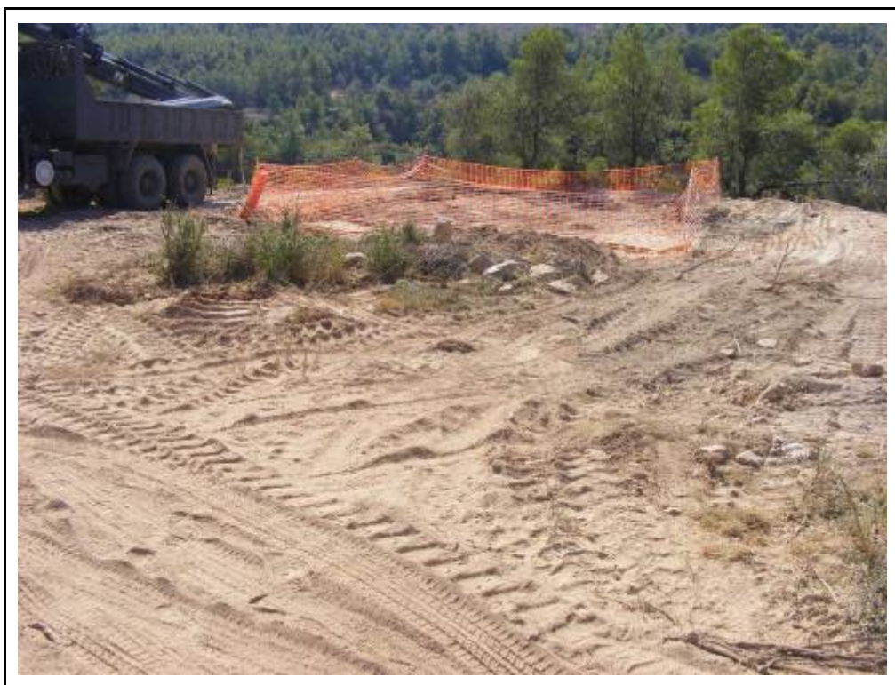
Foto 40: Suport 12, zona desbrossada per la confecció de la plataforma.
