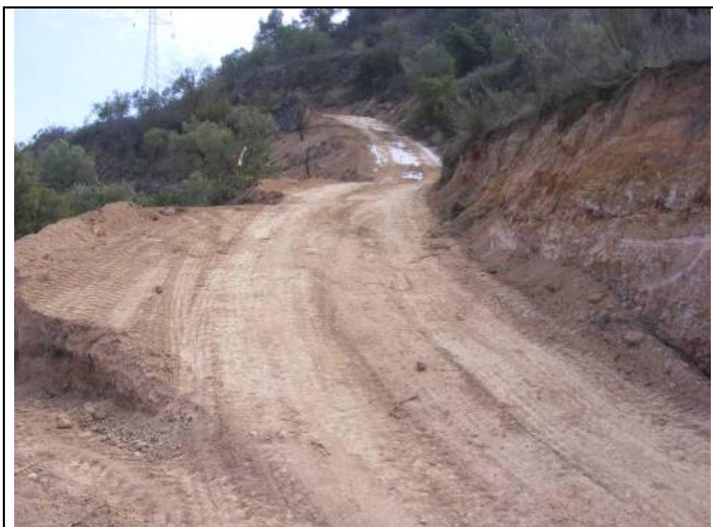
Foto 88: Suport 23, zona talada, desbrossada i amb rebaixos per la confecció del camí d'accés a la plataforma.
