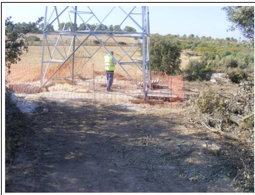
Foto 28: Suport 14, rebaixos per la confecció dels quatre pilars.
