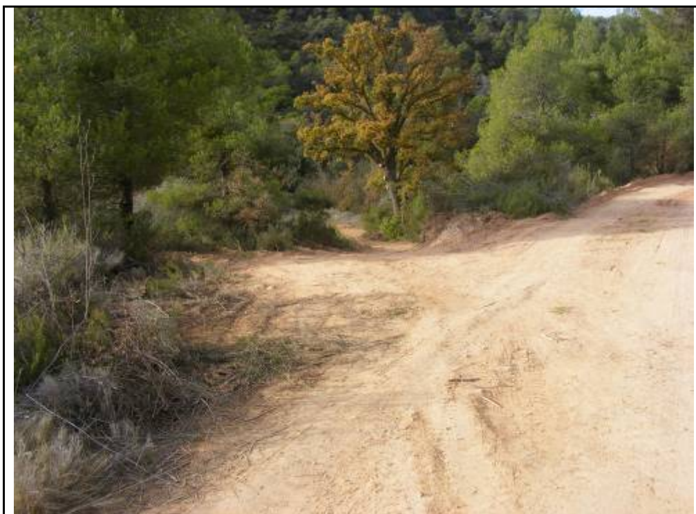
Foto 81: Suport 25, zona talada i desbrossada per l'ampliació i confecció del camí d'accés a la plataforma.
