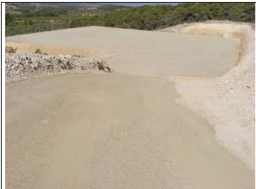
Foto 1: Zona SET Monclues, zona ja construïda.
