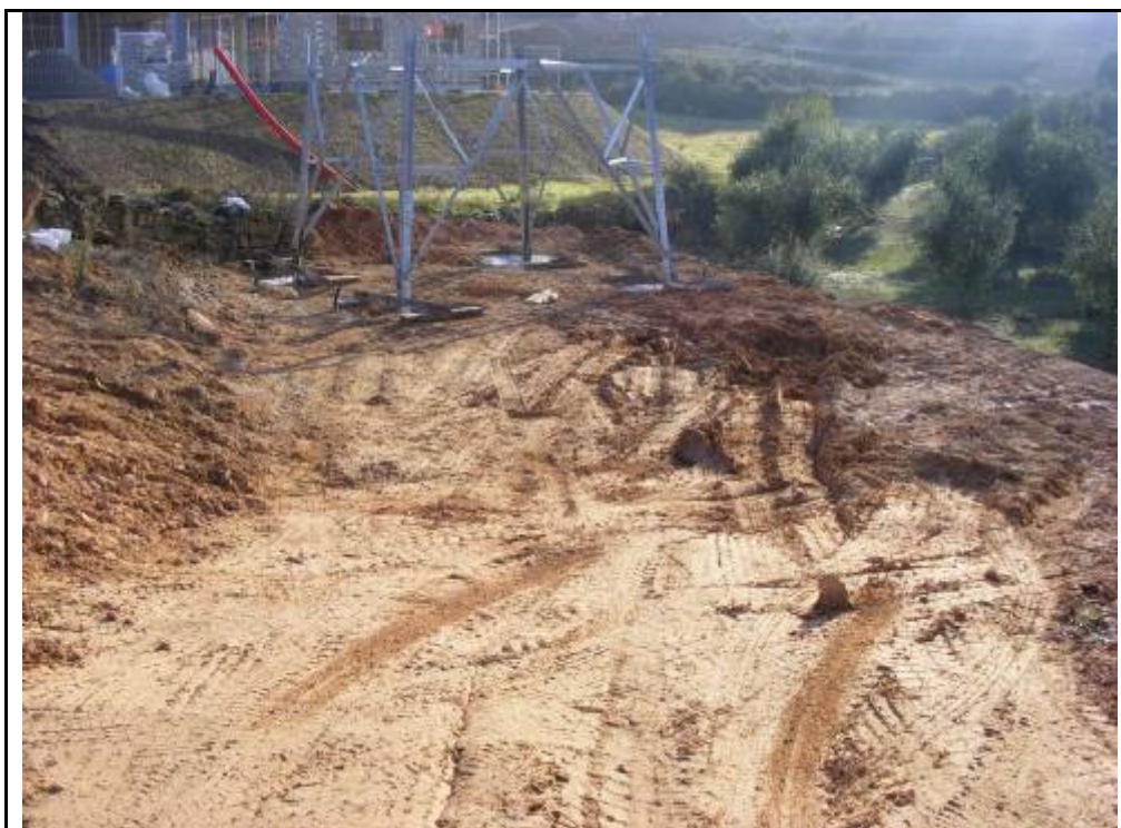
Foto 141: Suport 1, zona talada i terraplenada per la confecció dels quatre pilars.
