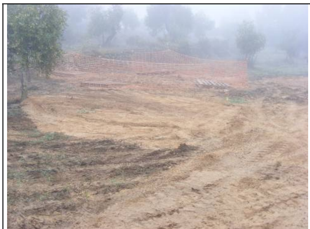
Foto 43: Suport 10, zona desbrossada per la confecció de la plataforma.
