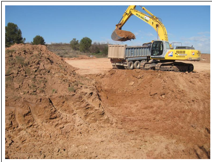
Foto núm.6, treballs d'excavació de terres.
