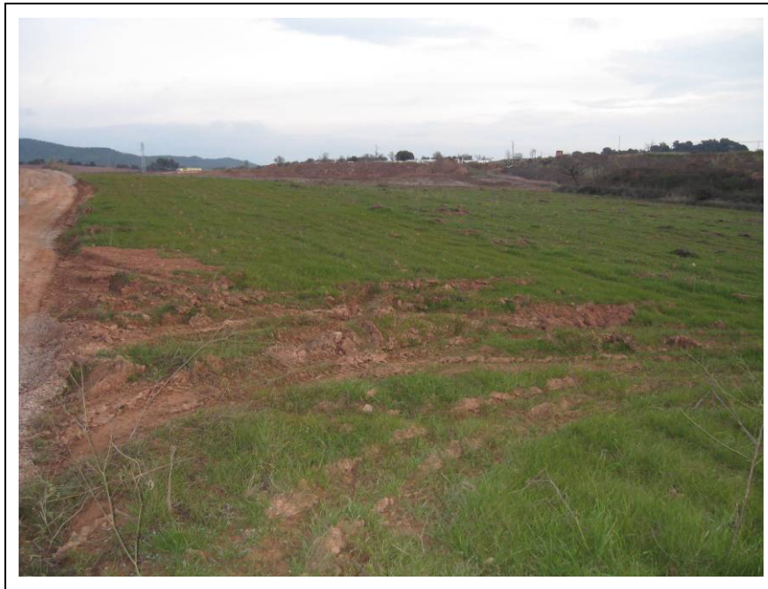
Foto núm.1, vista general cap al norddest del camp abans de realitzar-se els rebaixos de la capa vegetal.
