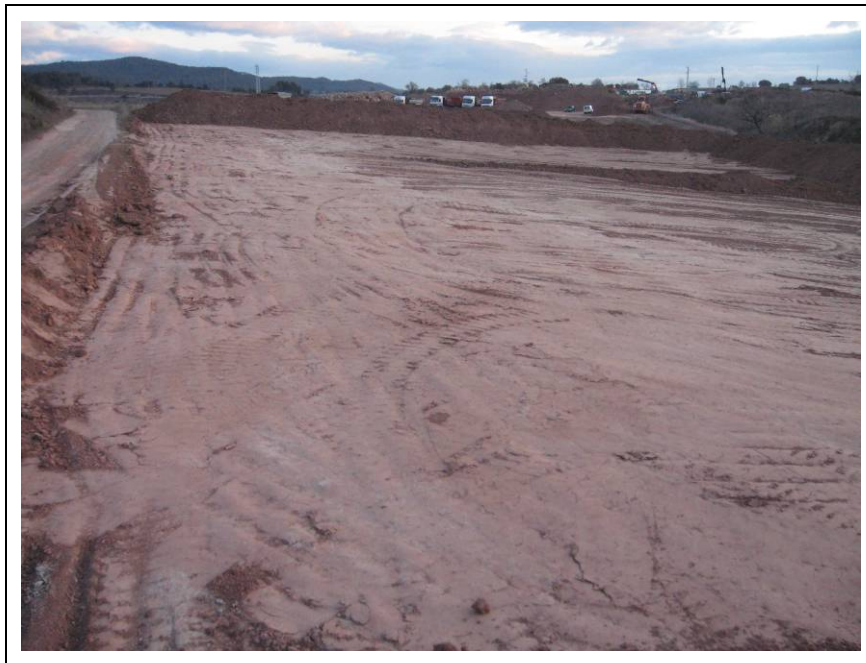
Foto núm.2, vista general cap al norddest del camp després de realitzar-se els rebaixos de la capa vegetal.
