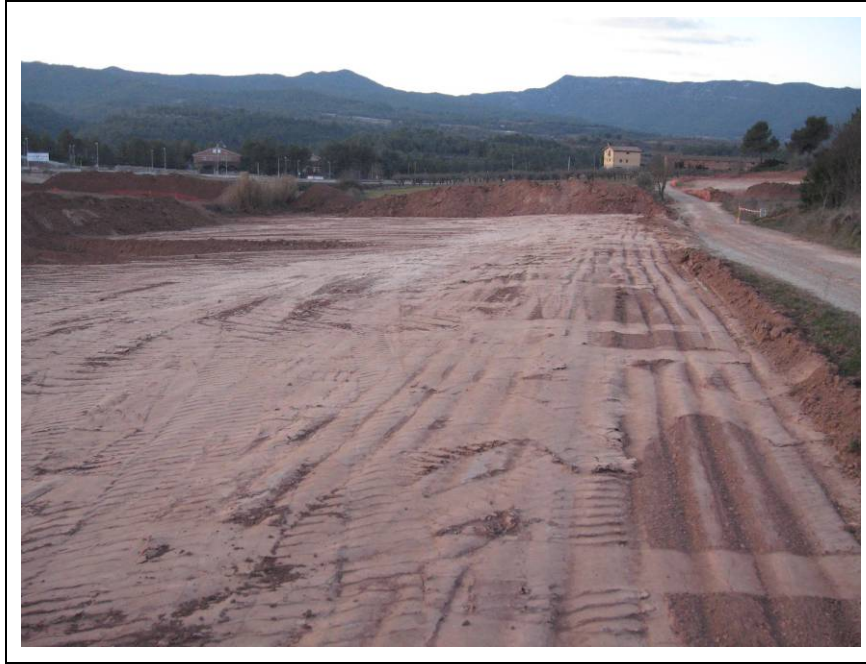
Foto núm.3 , vista cap al sud del camp, després de realitzar-se els rebaixos de la capa vegetal.
