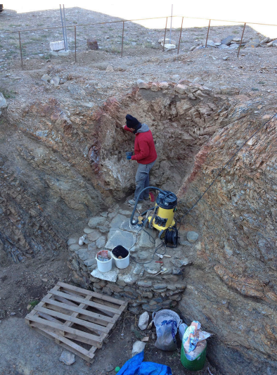
Reintegració d'esquerdes i fissures de la roca mare.
