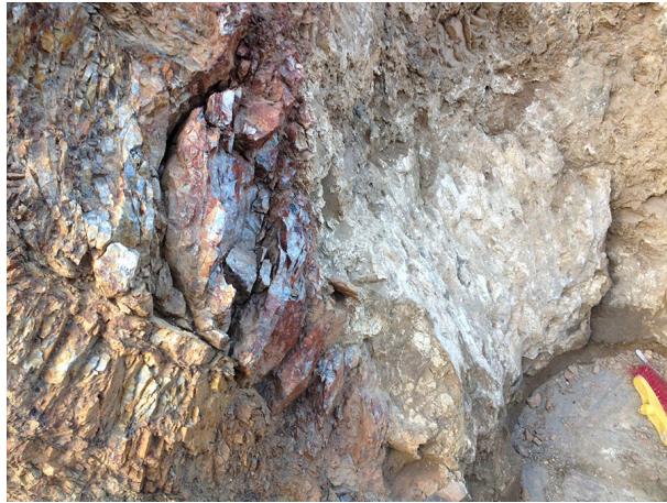
Injecció de morters líquids a les fissures de la roca mare.
