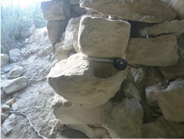
1. Vista de l'emplaçament del carreu amb un forat practicat, al costat de la porta.
