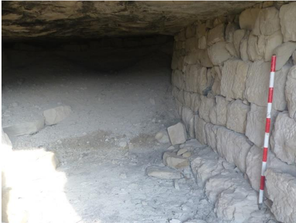
1. Mur de blocs escairats situat a la dreta de l'entrada de la cavitat.
