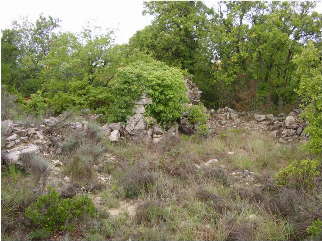
Element núm 3. Edifici. Casot de les monges. Conjunt en ruïnes.
