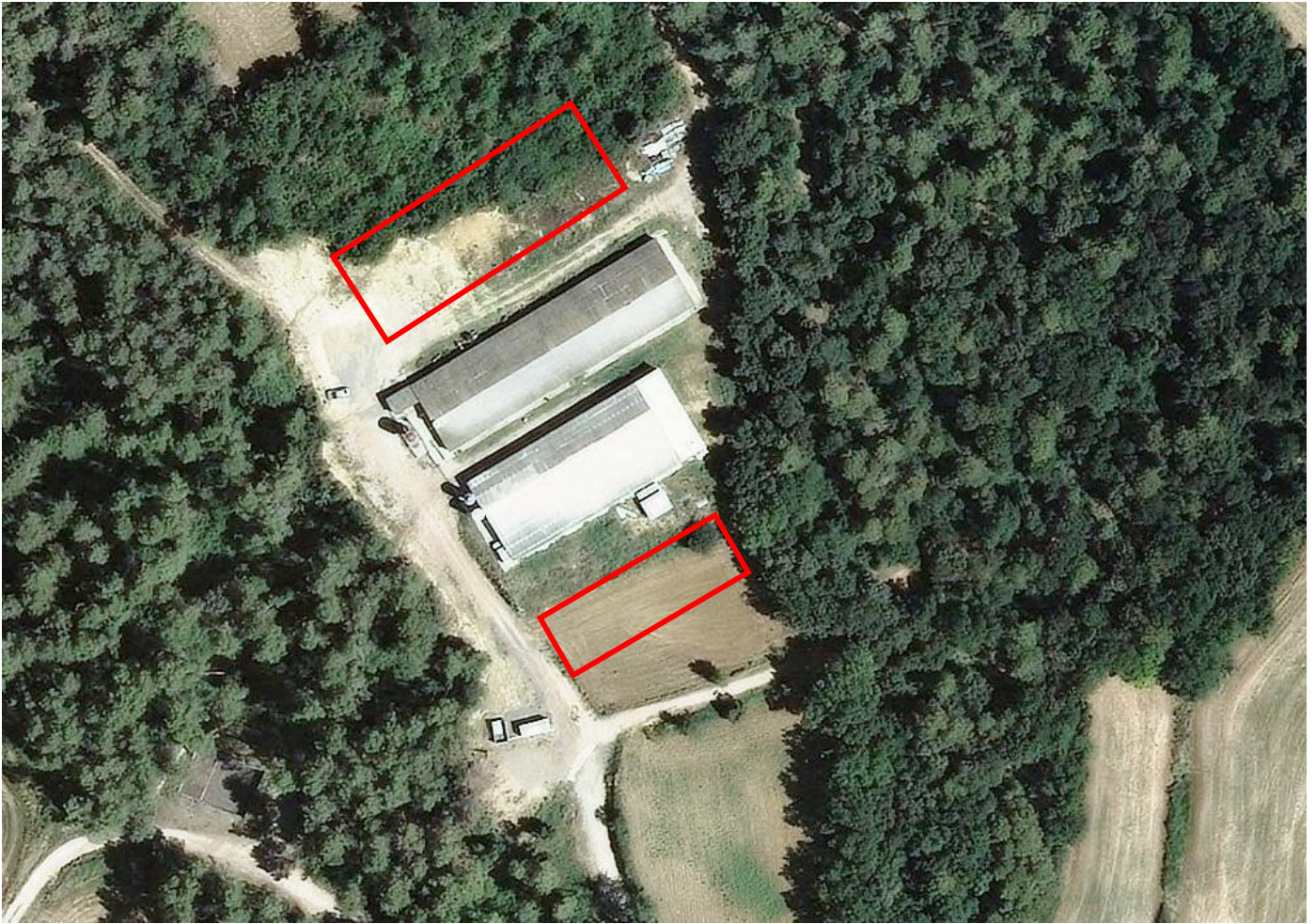
Fig. 2. Ortofoto de detall de la Vinya de Can Geldeus. Els requadres vermells assenyalen les dues zones on es preveu construir dos nous mòduls de granges.
