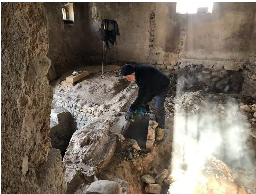
FOTOGRAFIA 20 -21 → Treballs de desmuntatge de les estructures afectades.
