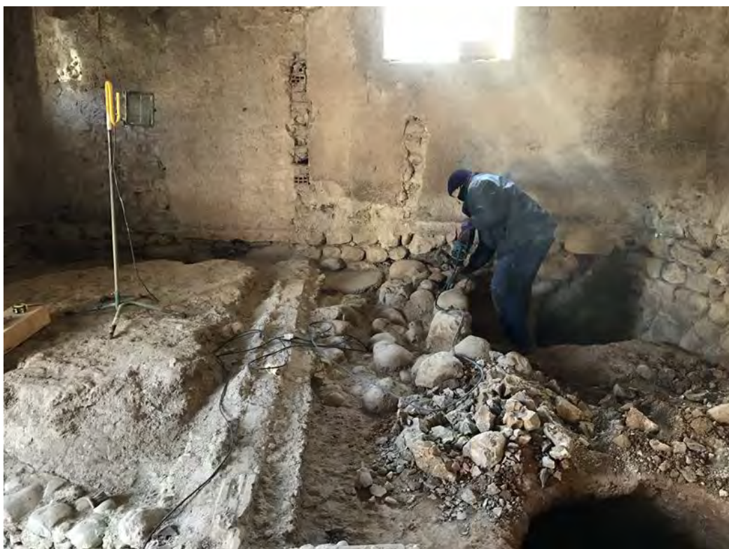
FOTOGRAFIA 18 -19 → Treballs de desmuntatge de les estructures afectades.
