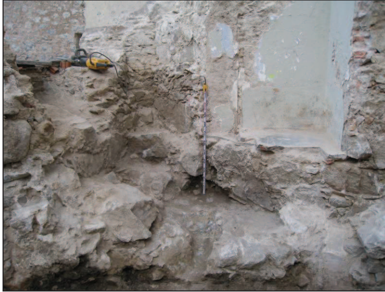
Foto 5. Foto feta des de l'est. S'aprecia el baixant (U.E. 51) davant del jaló en línea recta i l'altre baixant (U.E. 52) a la dreta de la fotografia.
