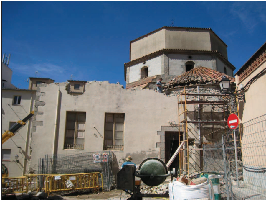
Foto 3. Vista general des de l'est del campanar de torre octogonal, d'una de les parets de l'escorxador i de com aquesta s'adossa a l'absis semicircular (on hi ha la bastida).
