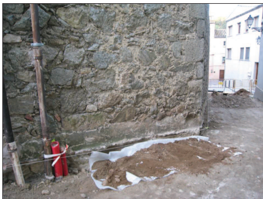
Foto 13. Vista general de les tasques de cobriment de les estructures U.E. 10 i 20. Foto feta des de l'est.
