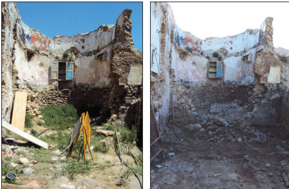
Foto 1: Vista general de l'interior de la torre abans d'iniciar els treballs d'excavació.
