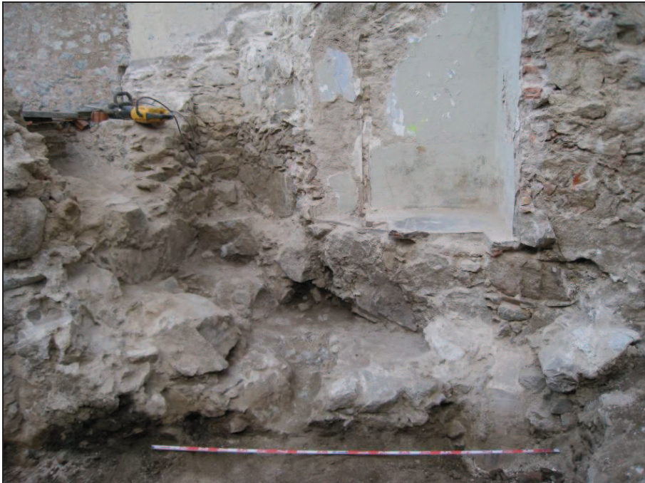
Foto 4. Vista des de l'est de l'estructura U.E. 41 i de part de l'absis malmès per a fer-hi les escales d'accés a la planta segona de l'escorxador.
