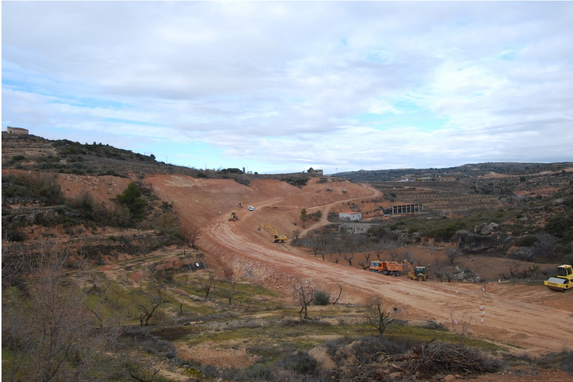
Vista de l'obra de construcció del camí de l'Albagés a Cervià, Vall de la Sisquella, febrer 2011
