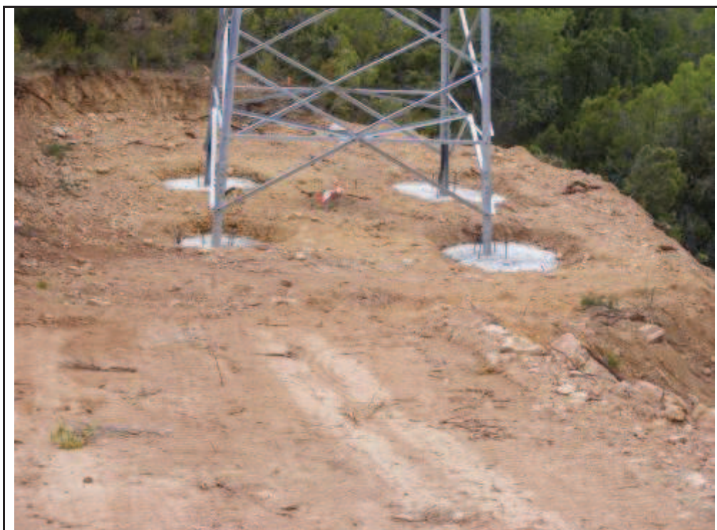
Foto 75: Suport 27, zona amb rebaixos i terraplens per la confecció de la plataforma.
