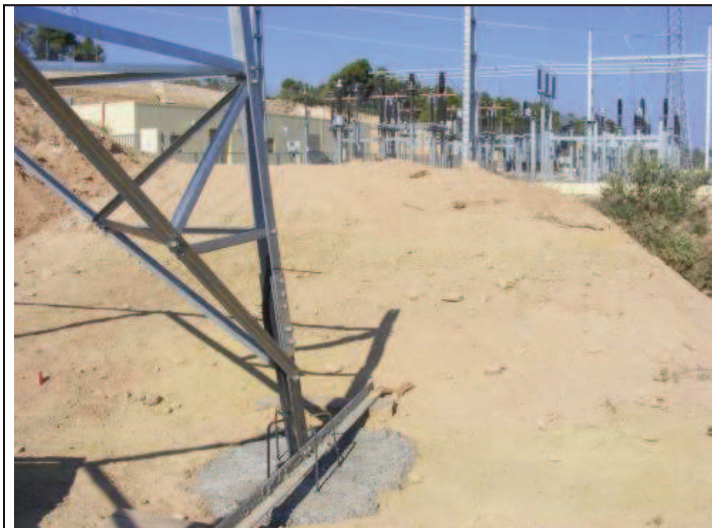
Foto 31: Suport 16 (SET Monclues-SET Sant Antoni), Suport 15 (SET Sant Antoni-Set Auliver), rebaixos per la confecció de la plataforma.
