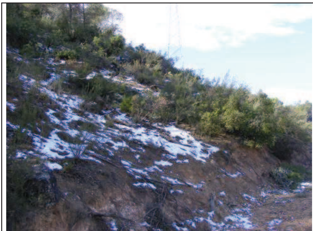
Foto 52: Zona talada entre el suport 7 i el suport 6.
