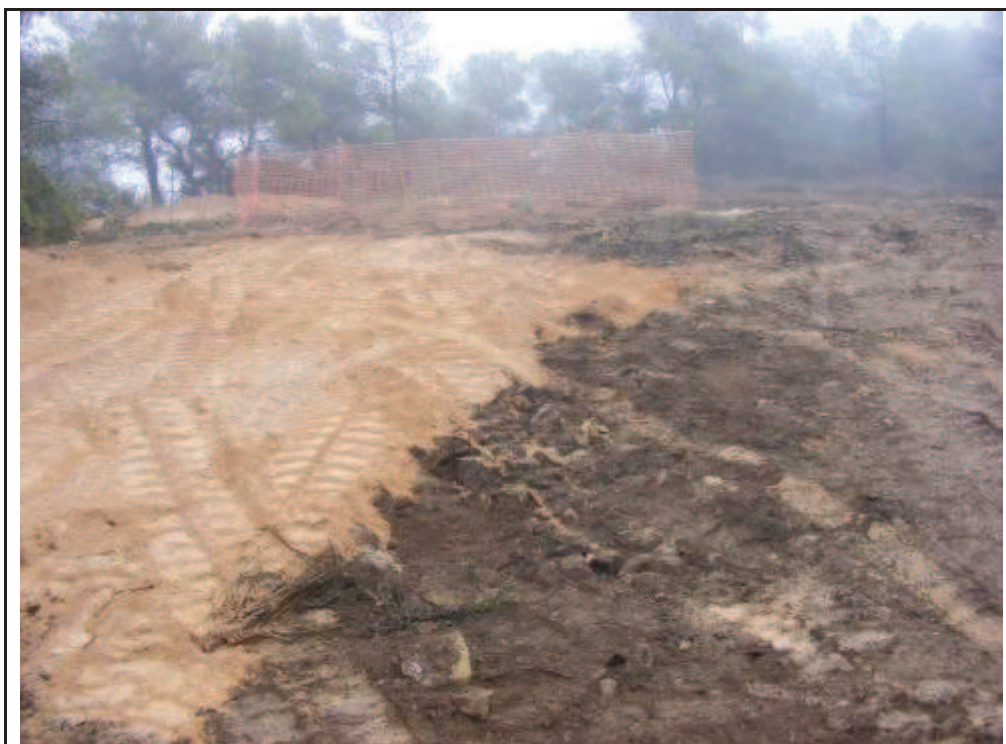
Foto 46: Suport 9, zona talada i desbrossada per la confecció de la plataforma.
