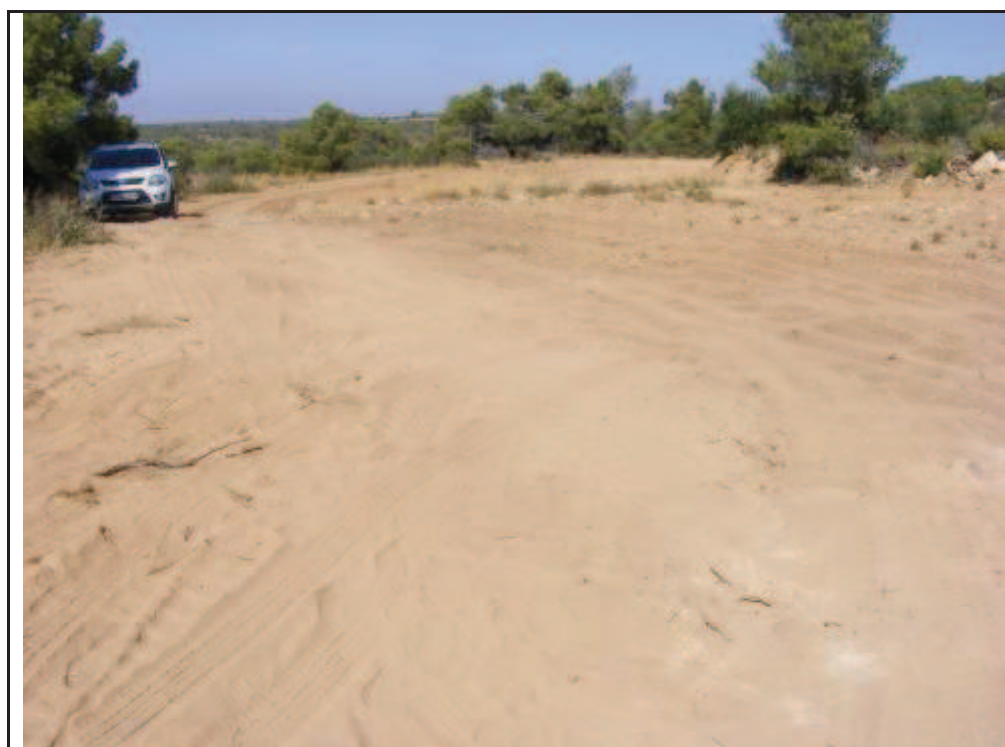
Foto 41: Suport 12, zona desbrossada per la confecció de l'accés a la plataforma.
