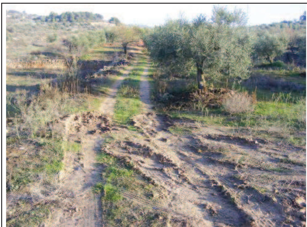
Foto 140: Suport 2, s'ha aprofitat el camí que mena a les terrasses agrícoles per efectuar l'accés a la plataforma.
