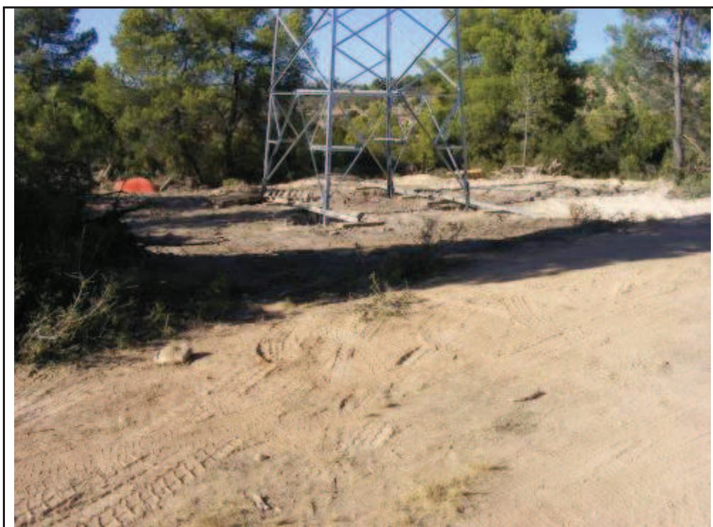
Foto 72: Suport 29, zona talada per la confecció de la plataforma.
