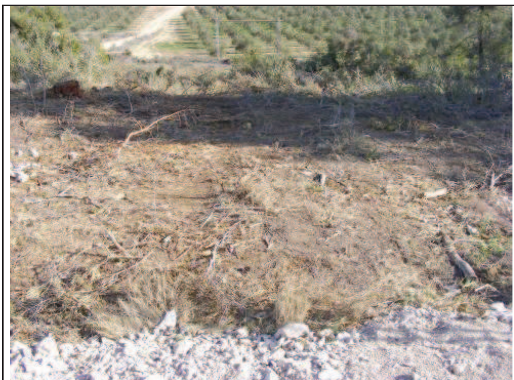
Foto 21: Traçat de la LE Entre els suports 10 i 11, s'ha talat una zona de bosc i matolls.
