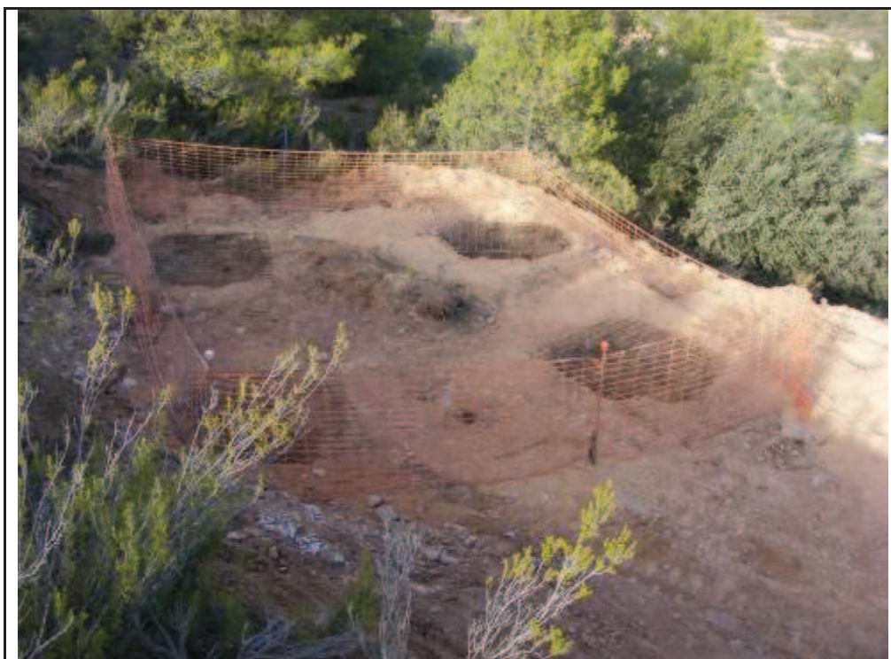
Foto 135: Suport 4, zona talada amb terraplens i rebaixos per la confecció dels quatre pilars.
