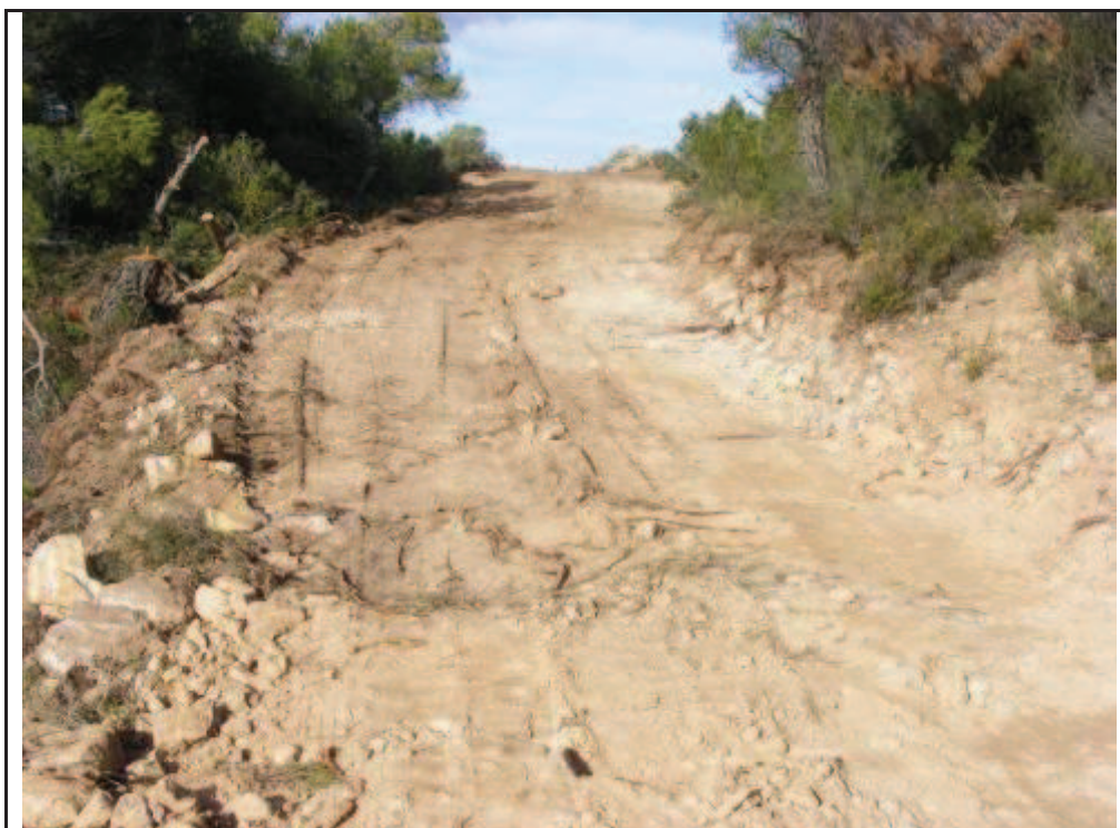
Foto 125: Suport 9, zona talada i desbrossada amb rebaixos per la confecció del camí d'accés a la plataforma.
