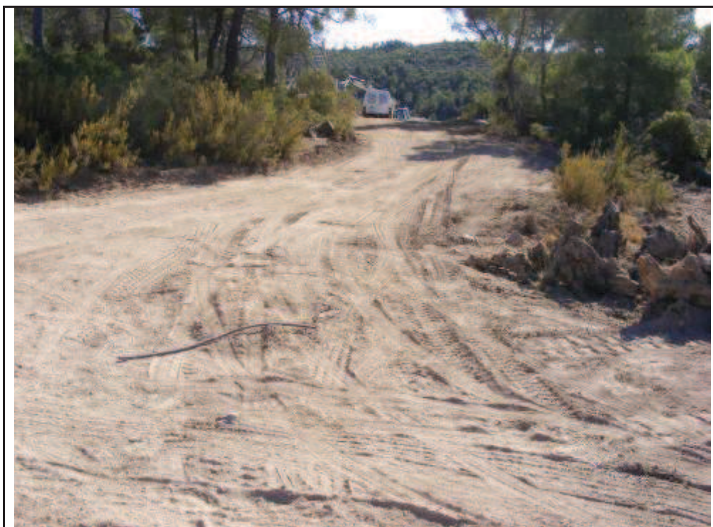
Foto 66: Suport 1 (SET Sant Antoni-SET l'Auliver), suport 31 (SET l'Auliver - SET les Rotes), zona rebaixada per la confecció de l'accés a la plataforma.
