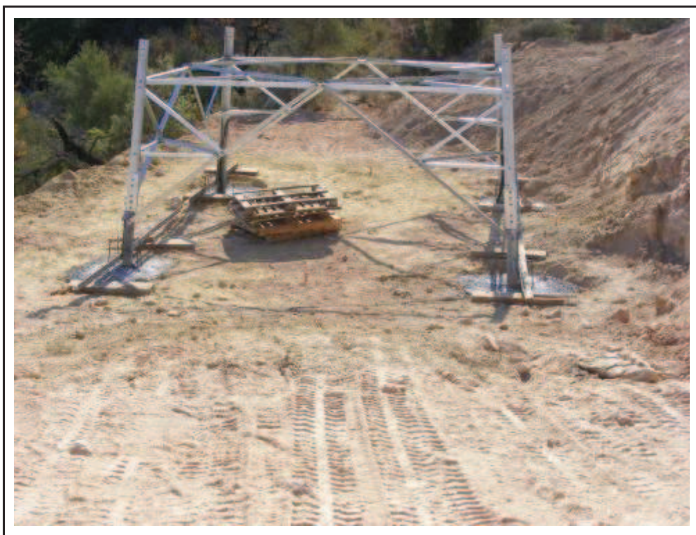
Foto 32: Suport 15 (SET Sant Antoni-Set Auliver), Suport 16 (SET Monclues-SET Sant Antoni), rebaixos per la confecció de la plataforma.
