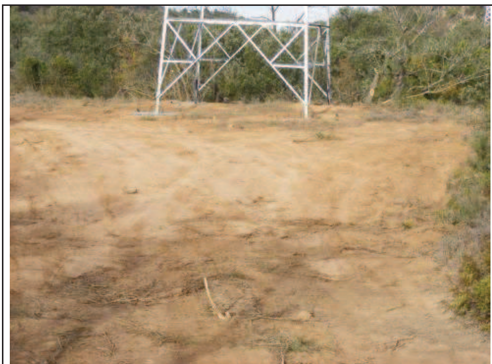
Foto 80: Suport 25, zona talada i desbrossada per la confecció de la plataforma.
