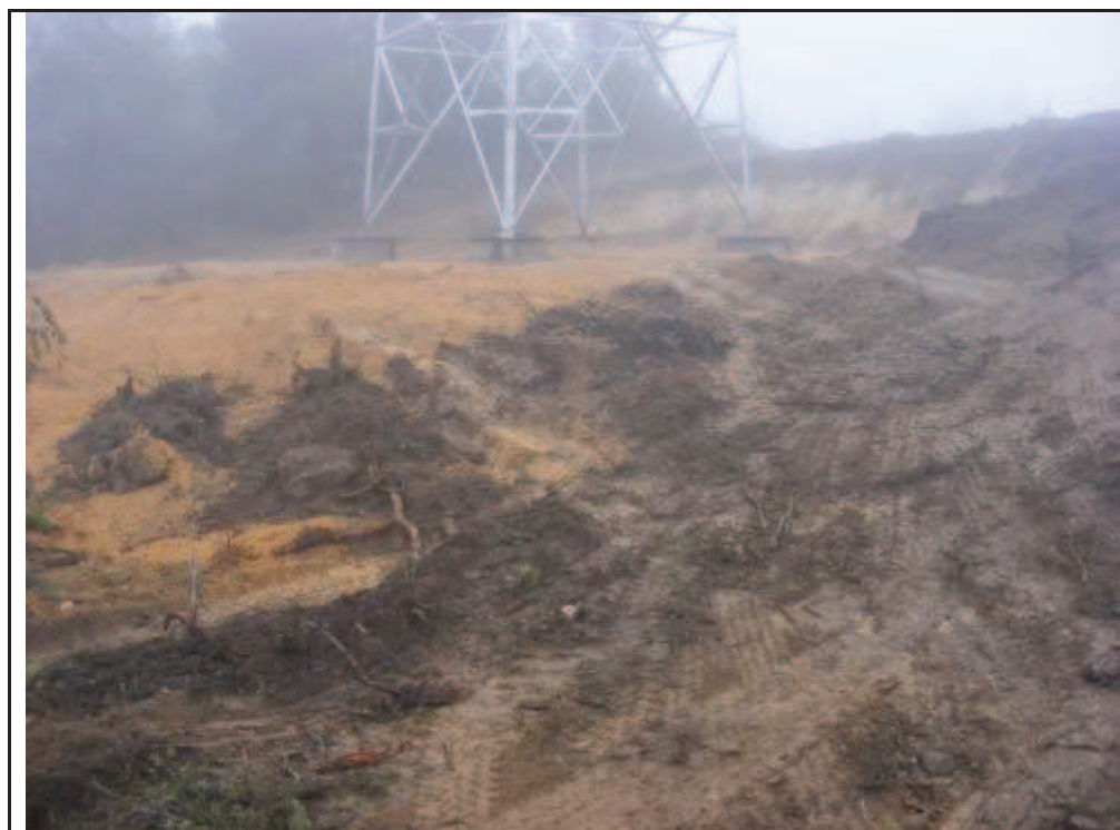
Foto 27: Suport 13, rebaixos per la confecció de la plataforma.
