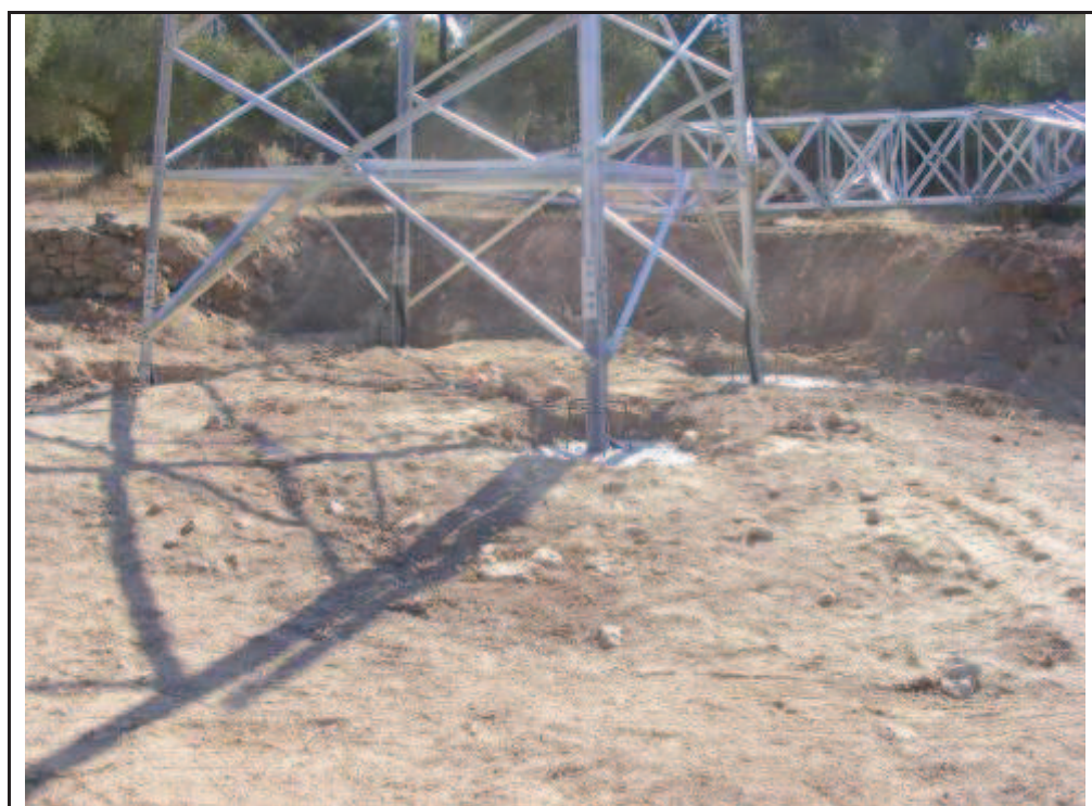
Foto 29: Suport 15, rebaixos per la confecció de la plataforma.
