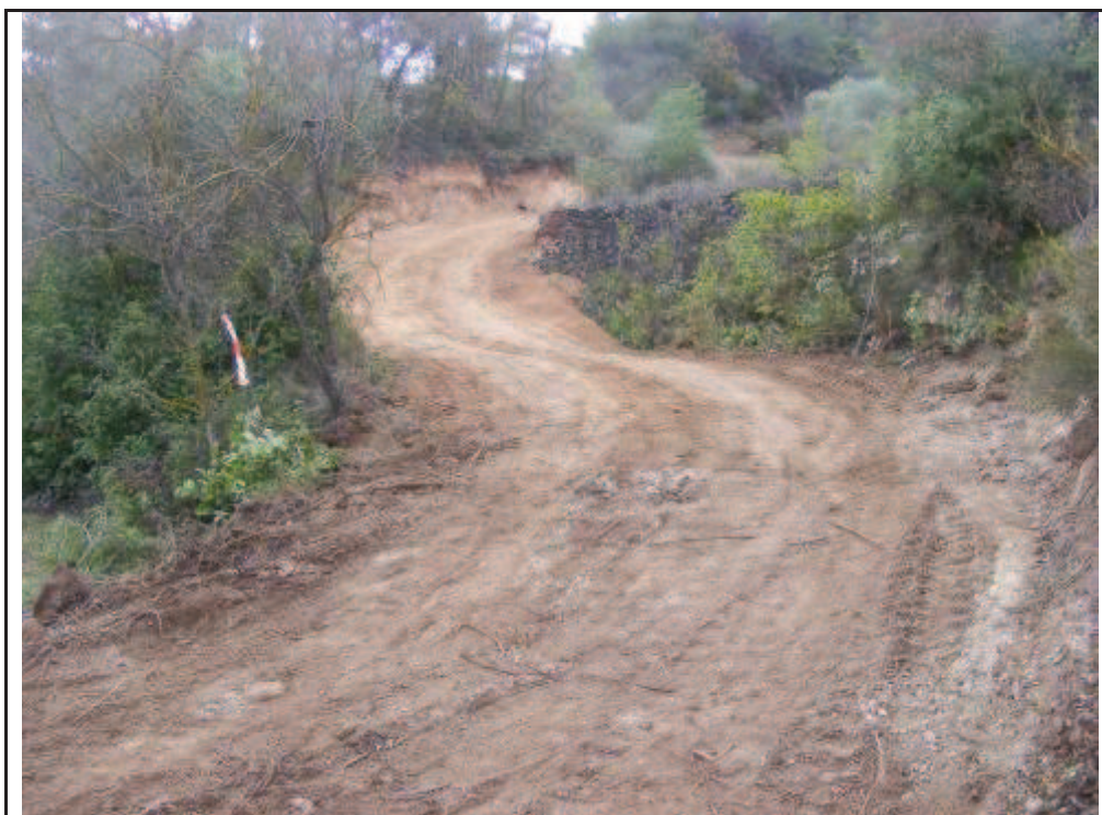
Foto 91: Suport 22, zona talada, desbrossada i amb rebaixos per la confecció del camí d'accés a la plataforma.
