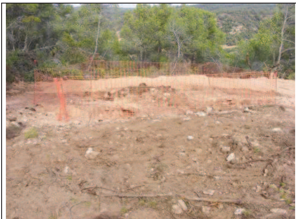
Foto 98: Suport 19, zona talada i terraplenada per la confecció de la plataforma.
