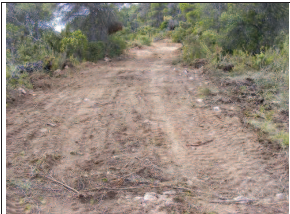
Foto 99: Suport 19, zona talada i desbrossada per la confecció del camí d'accés a la plataforma.
