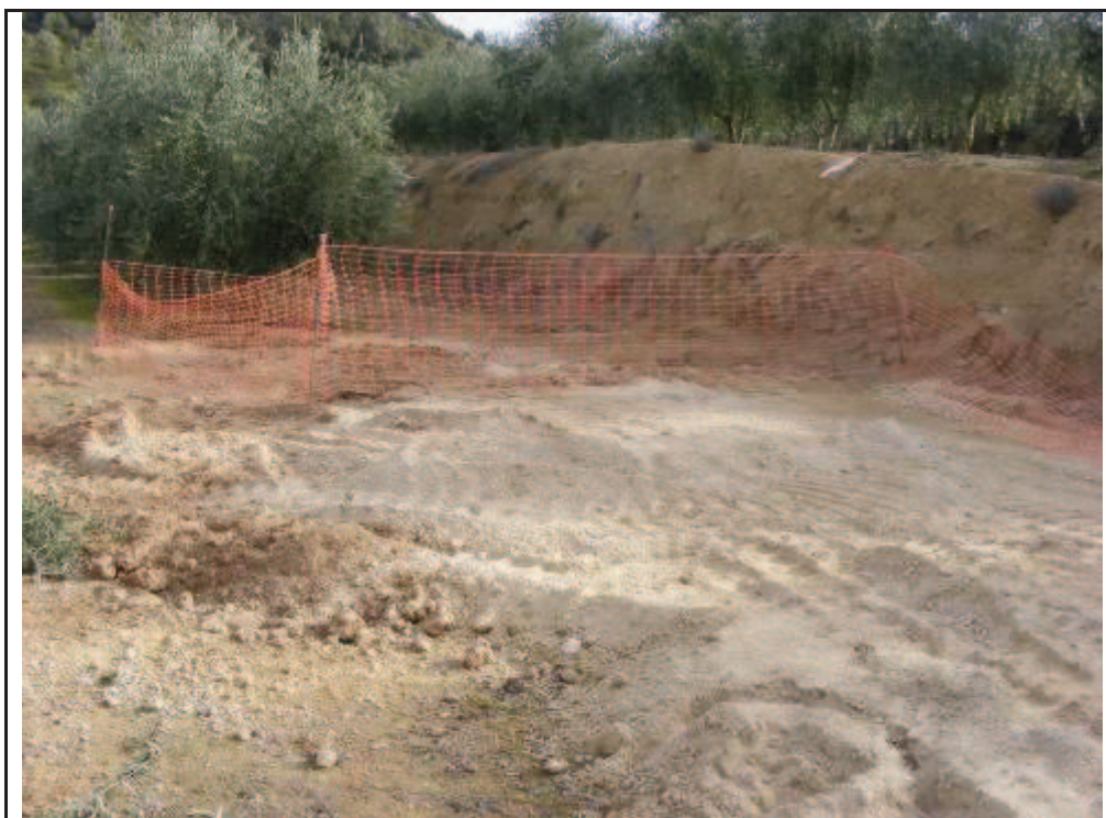
Foto 119: Suport 11, zona talada i aplanada amb l'excavació dels quatre pilars.
