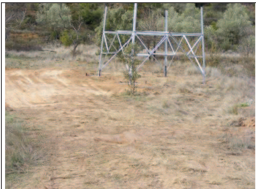
Foto 84: Suport 24, zona talada per la confecció de la plataforma.
