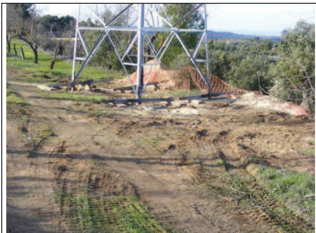
Foto 130: Suport 7, zona talada i aplanada per la confecció dels quatre pilars.
