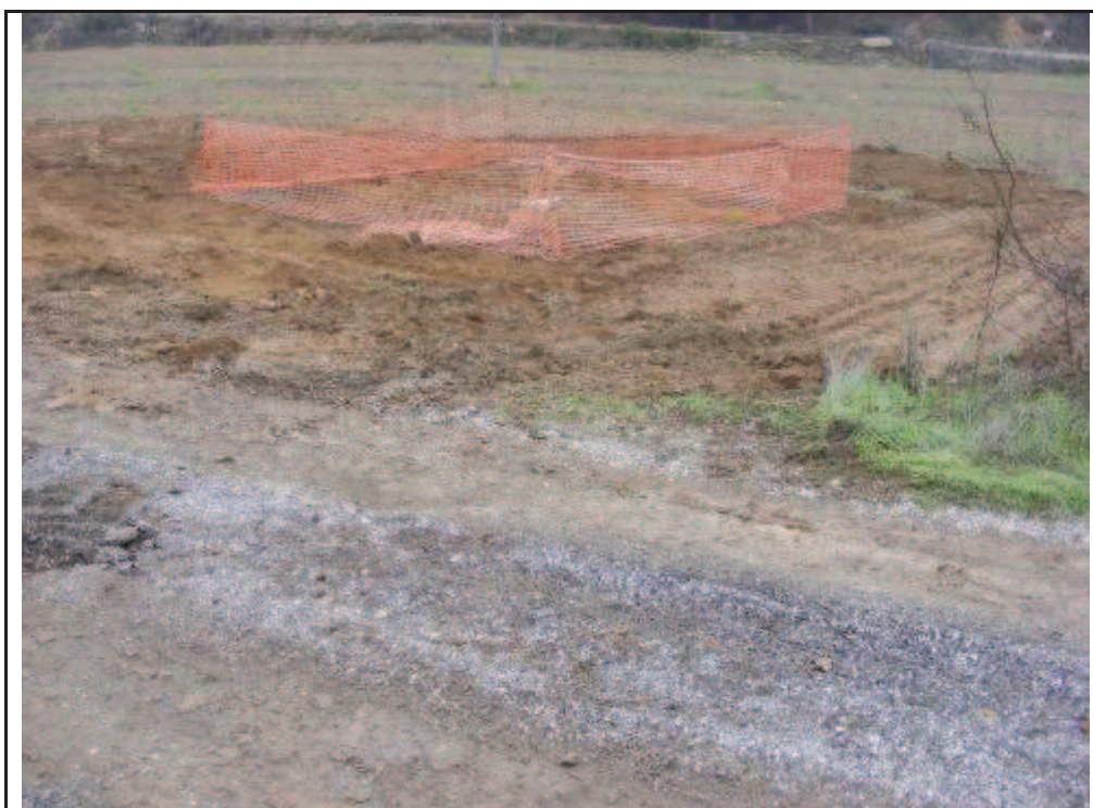
Foto 49: Suport 8, zona desbrossada per la confecció de la plataforma.
