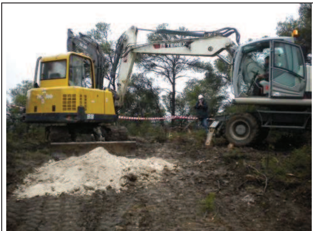
Foto 16: suport 8, excavació dels pilars.
