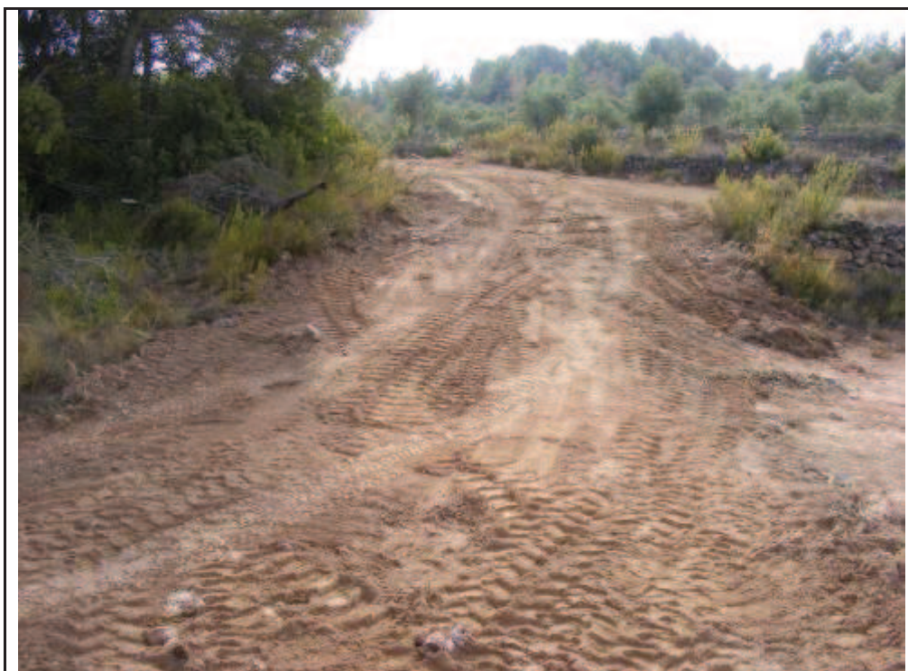
Foto 103: Suport 18, zona talada i desbrossada per la confecció del camí d'accés a la plataforma.
