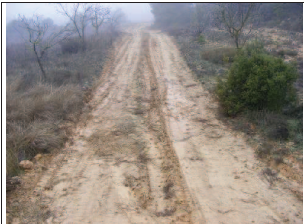
Foto 12: adequació del camí per accedir al suport 7, anivellant-l'ho.
