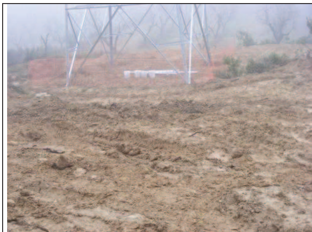
Foto 37: Suport 13, rebaixos per la confecció de la plataforma.
