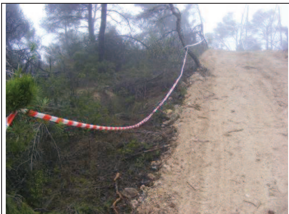
Foto 17: suport 8, terraplenament de l'accés. La trinxera queda separada amb cinta a l'esquerra de la imatge.
