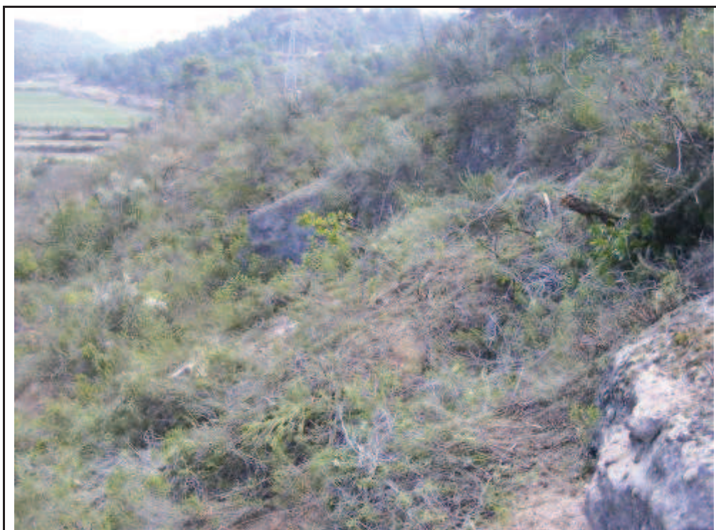
Foto 89: Zona talada entre el suport 23 i el suport 22.
