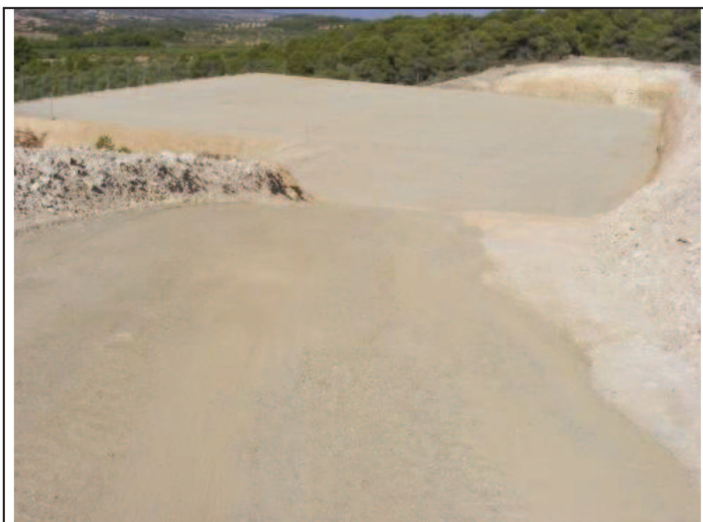
Foto 1: Zona SET Monclues, zona ja construïda.
