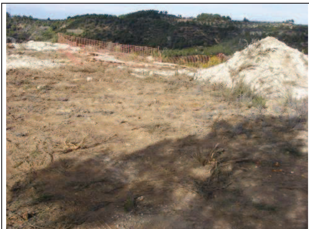
Foto 124: Suport 9, zona talada i desbrossada per la confecció dels quatre pilars. Afloraments de roca.
