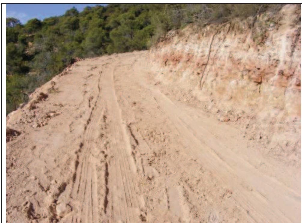
Foto 76: Suport 27, zona amb rebaixos i terraplens per la confecció del camí d'accés a la plataforma.
