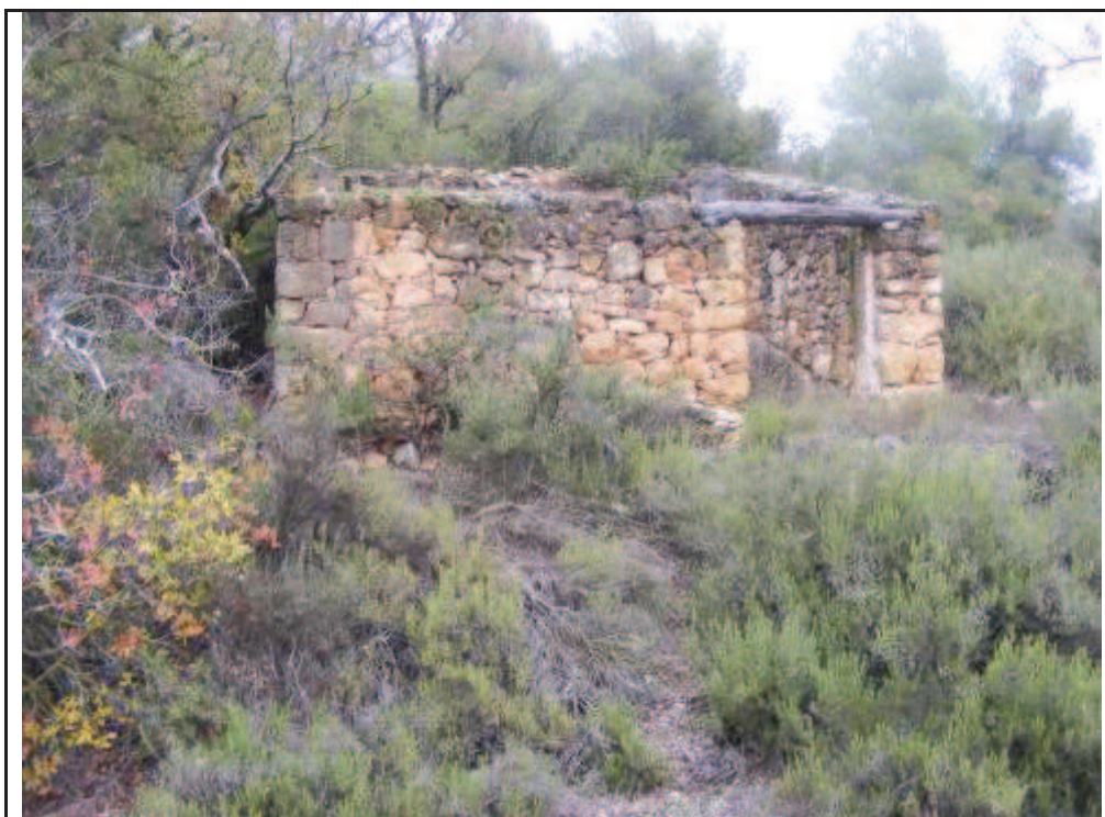
Foto 83:ED, cobert situat als marges dels accessos al suport 25
