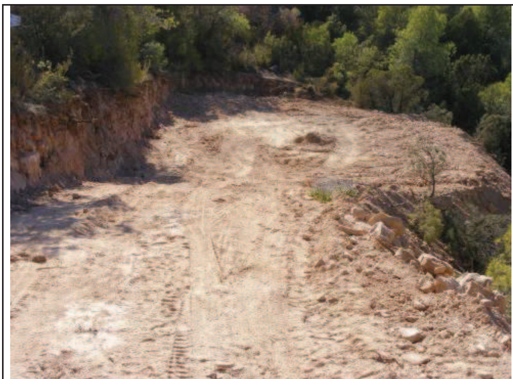
Foto 68: Suport 30, zona amb rebaixos i terraplens per la confecció de la plataforma.
