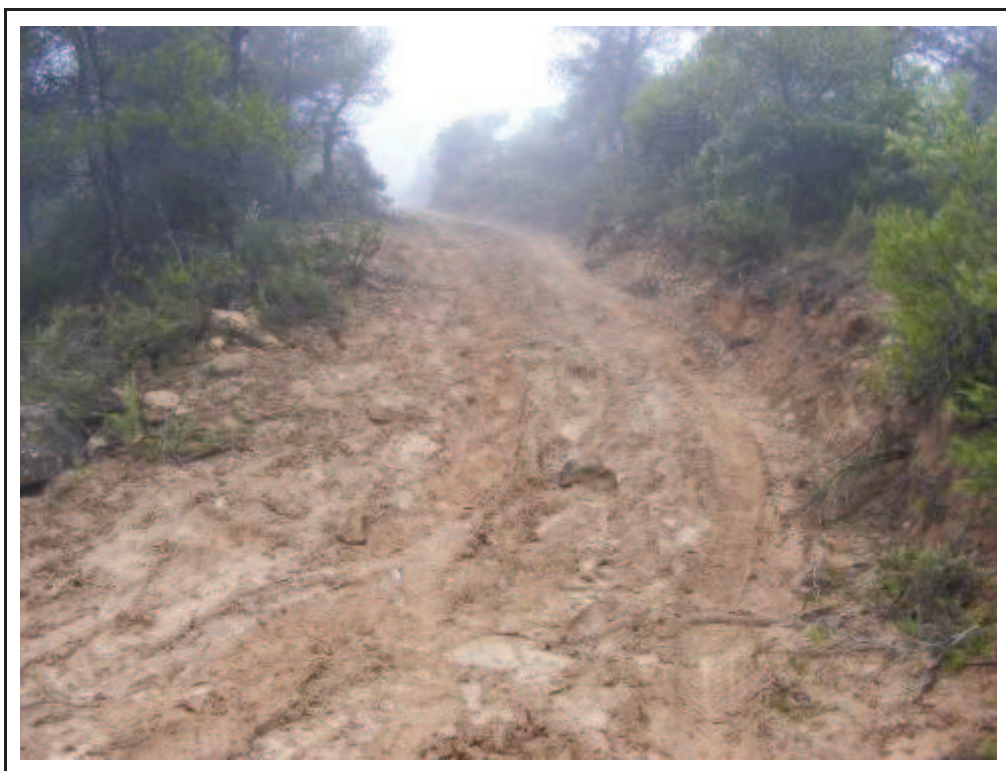
Foto 38: Suport 13, rebaixos per la confecció de l'accés a la plataforma.
