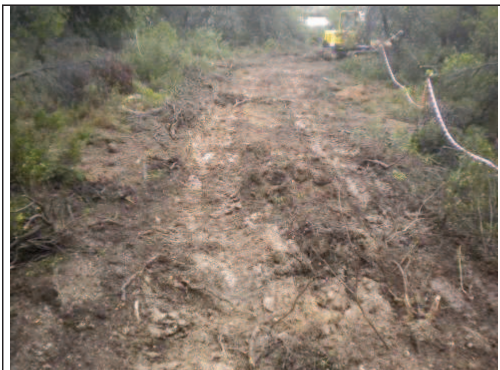
Foto 15: suport 8, desbrossament de l'accés.
