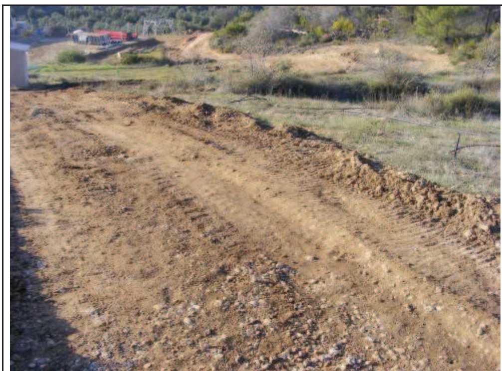
Foto 142: Suport 1, zona desbrossada amb rebaixos i terraplens per la confecció del camí d'accés a la plataforma.
