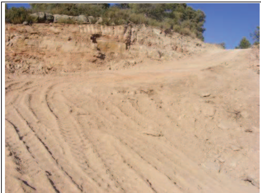
Foto 60: Suport 3, zona rebaixada per la confecció de l'accés a la plataforma.
