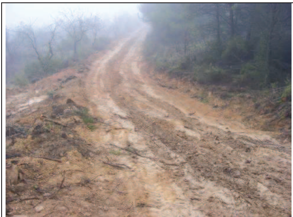
Foto 10: adequació del camí per accedir al suport 6, anivellant-l'ho.
