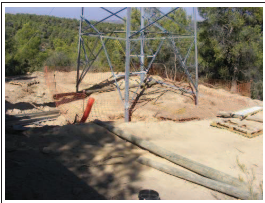
Foto 34: Suport 14, rebaixos per la confecció de la plataforma.
