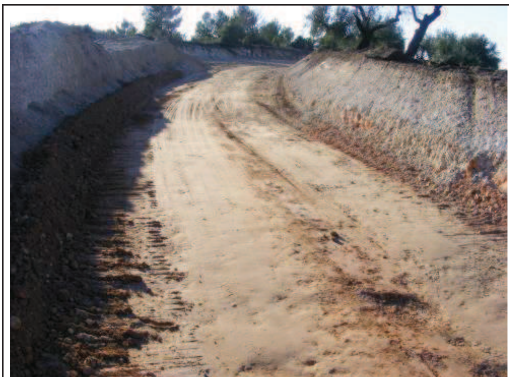
Foto 115: Suport 13, accés al aerogenerador 3 del PE de les Rotes des del camí de les Bàssies.
