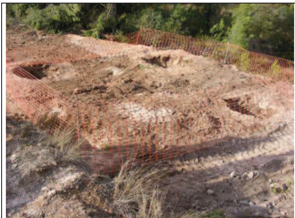
Foto 108: Suport 16, zona talada i terraplenada per la confecció de la plataforma.
