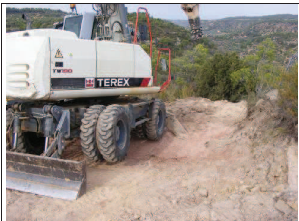
Foto 94: Suport 21, zona desbrossada per la confecció de la plataforma.
