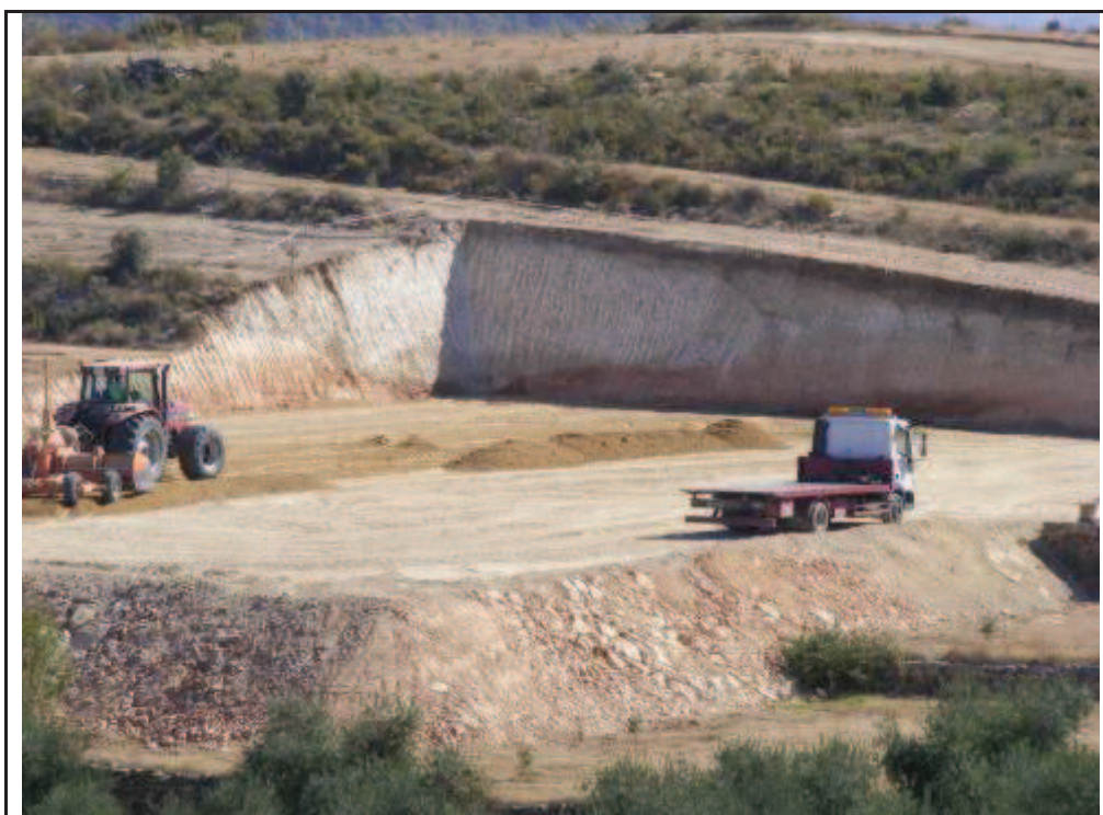
Foto 144: SET de les Rotes, terraplenament i compactació. S'han revisat totes les seccions producte dels rebaixos.
