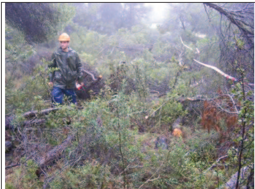
Foto 14: suport 8, delimitació de la zona amb cinta identificativa i tala de l'accés.
