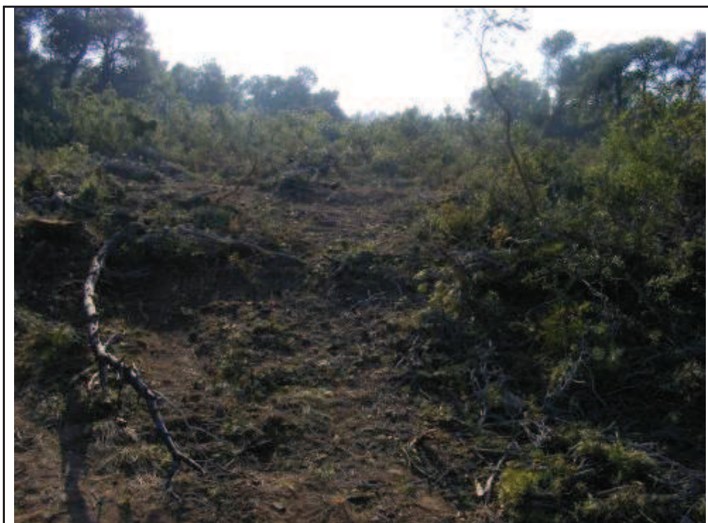
Foto 4: Traçat de la LE Entre els suports 3 i 4, s'ha talat una zona de bosc i matolls.
