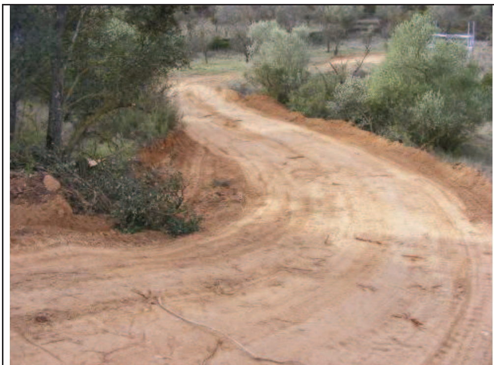
Foto 85: Suport 24, zona talada, desbrossada i terraplenada per l'ampliació i confecció del camí d'accés a la plataforma.
