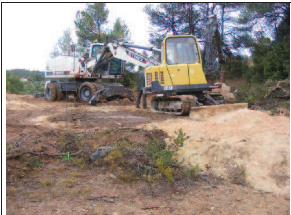
Foto 111: Suport 15, excavació dels quatre pilars.
