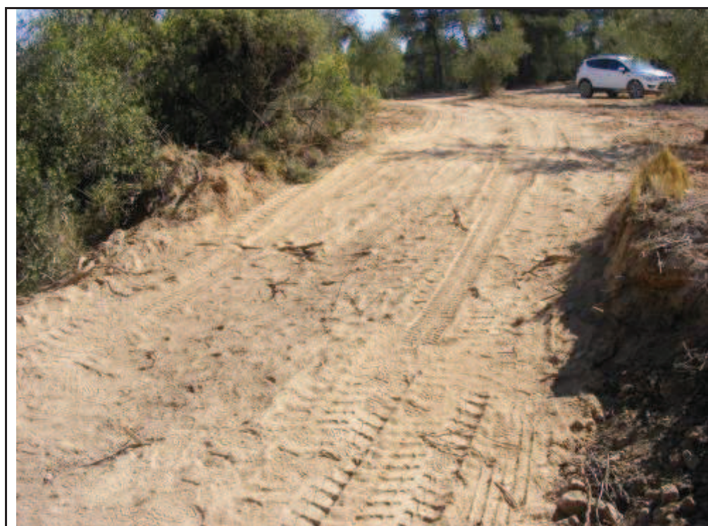
Foto 35: Suport 14, rebaixos per la confecció de l'accés a la plataforma.
