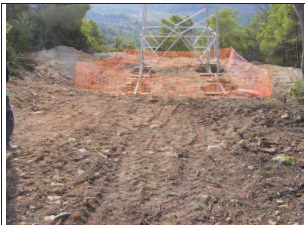
Foto 114: Suport 13, zona talada i terraplanada per la confecció de la plataforma.
