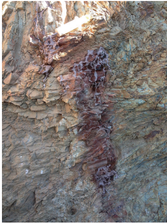
Injecció de morters líquids a les fissures de la roca mare.
