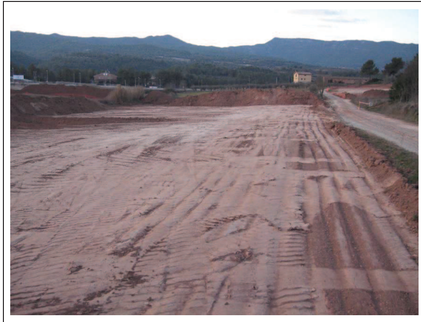
Foto núm.3 , vista cap al sud del camp, després de realitzar-se els rebaixos de la capa vegetal.
