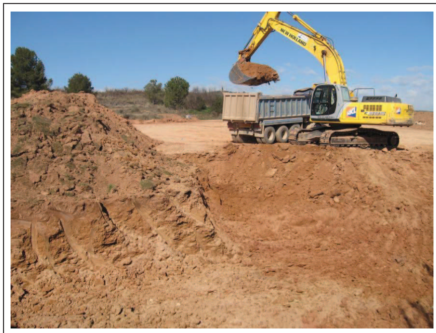
Foto núm.6 , treballs d'excavació de terres.
