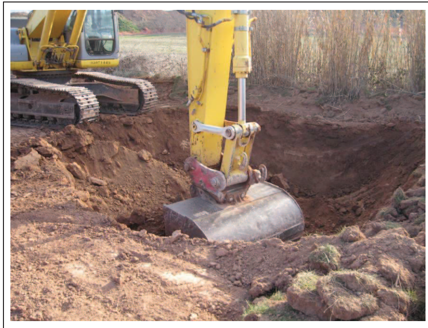
Foto núm.5 , inici dels treballs d'extracció de terres.
