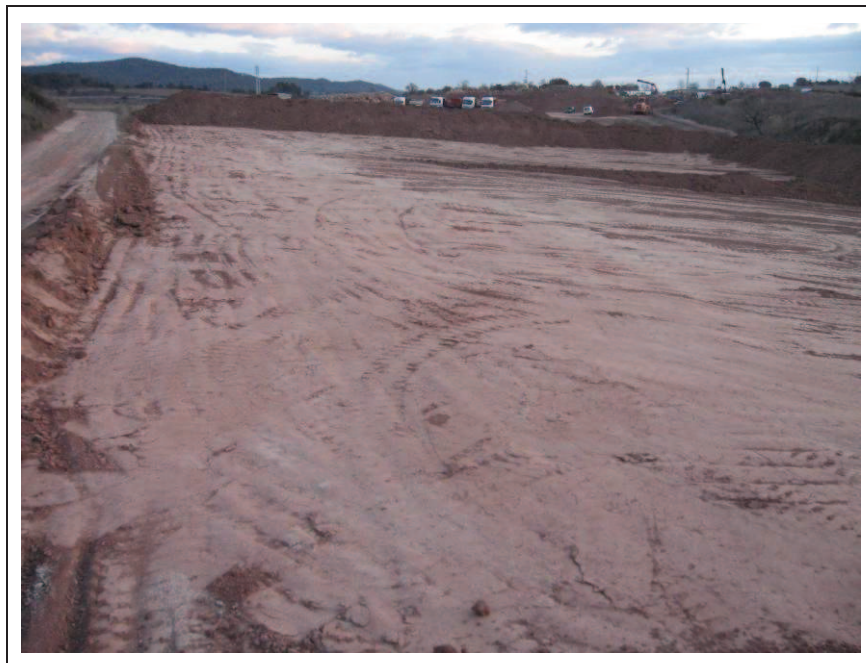
Foto núm.2, vista general cap al norddest del camp després de realitzar-se els rebaixos de la capa vegetal.
