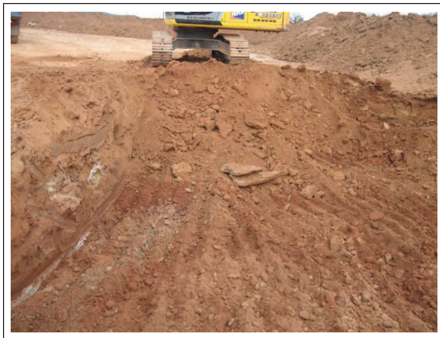
Foto núm.8, treballs d'excavació e les terres on apareixen les capes de carbonatacions.
