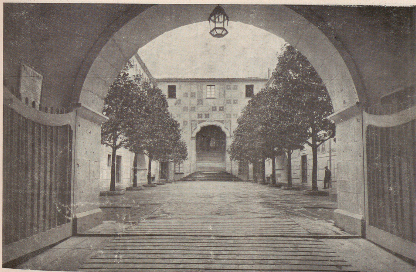
Pórtico y patio central del Hospital provincial
