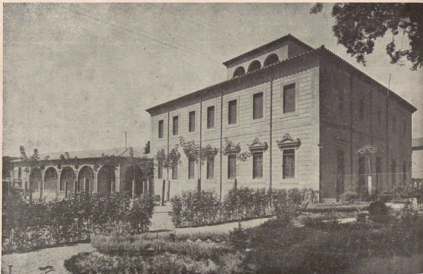
Diputación provincial.— Vista parcial, patio y jardines del Asilo de Ancianos
