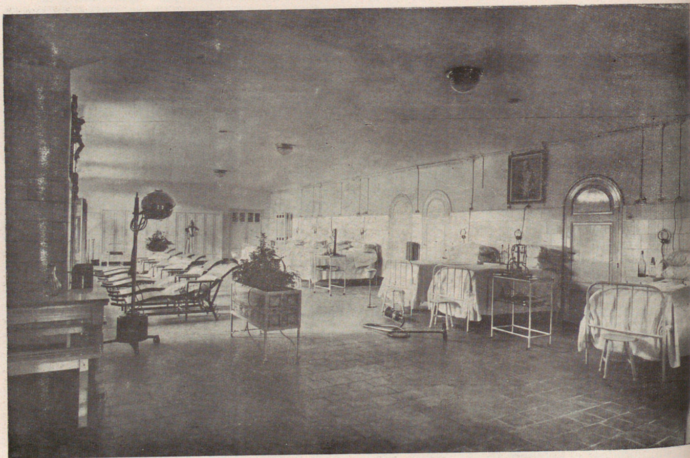
Hospital provincial. — Enfermerías Victoria Eugenia: Dormitorio de hombres
