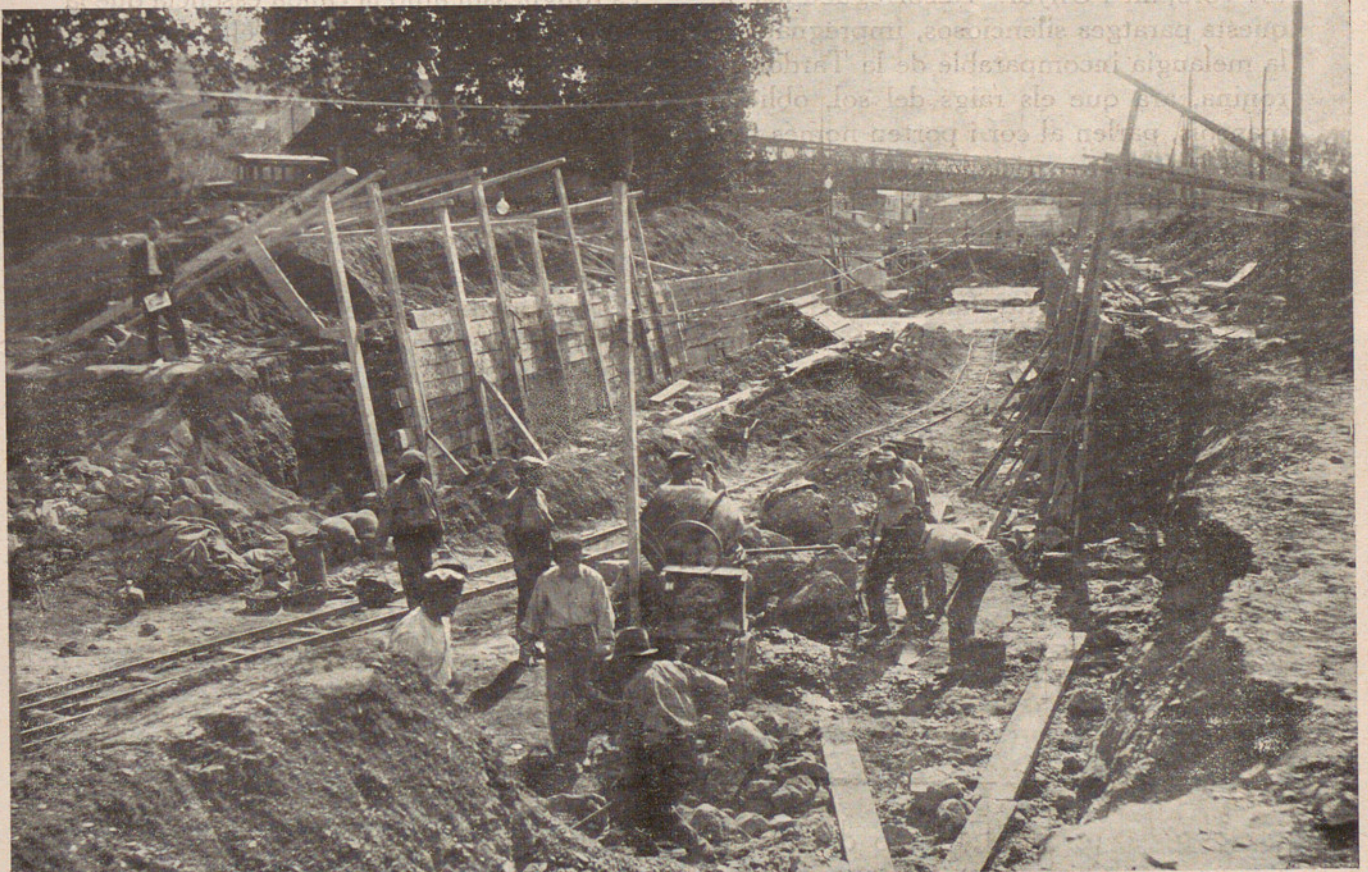
Aspecto actual de las obras del canal de la nueva Central Eléctrica que para ampliación del servicio de alumbrado público construye el Ayuntamiento de esta ciudad.
