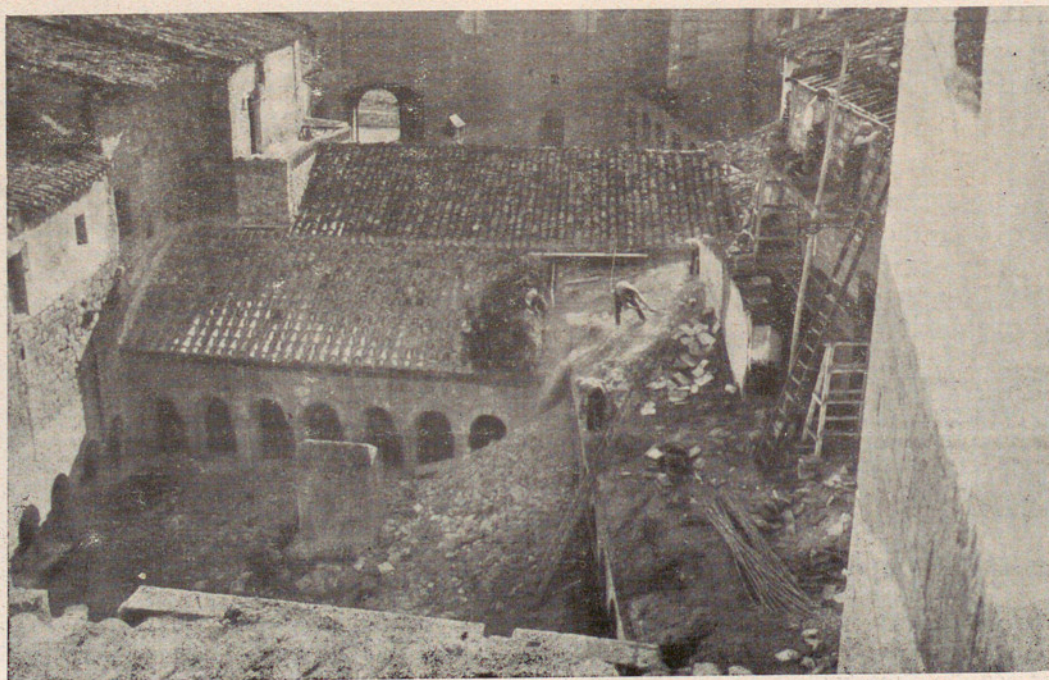
Vilabertrán. — Conjunto del claustro después del derribo de la casa «parásita» de dos pisos construída sobre el claustro.
