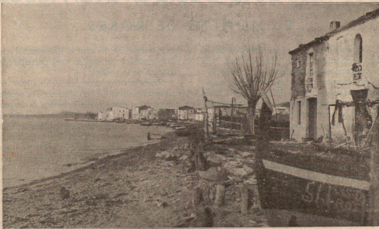
VISTA PARCIAL DE ROSES
