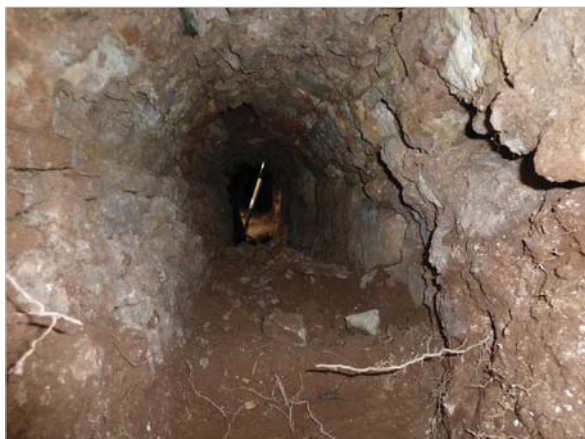
Figura 6. Vista de l'interior de la canalització documentada sota la llotgeta de la plaça de l'església.
