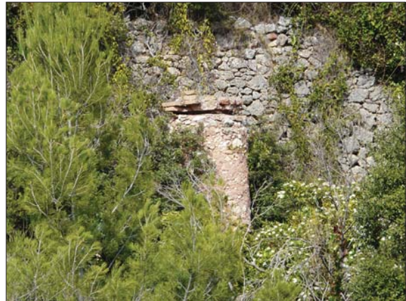
Figura 11. Vista del vaporador.
