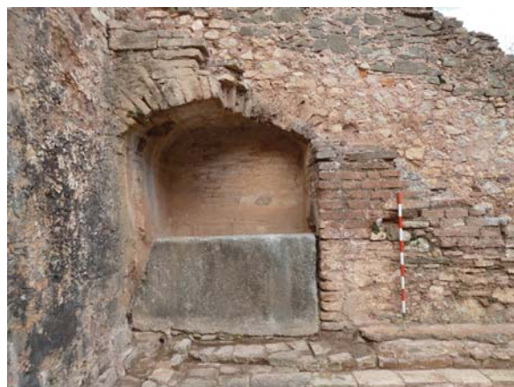
Figura 14. Vista de la cisterna de la terrassa intermèdia.
