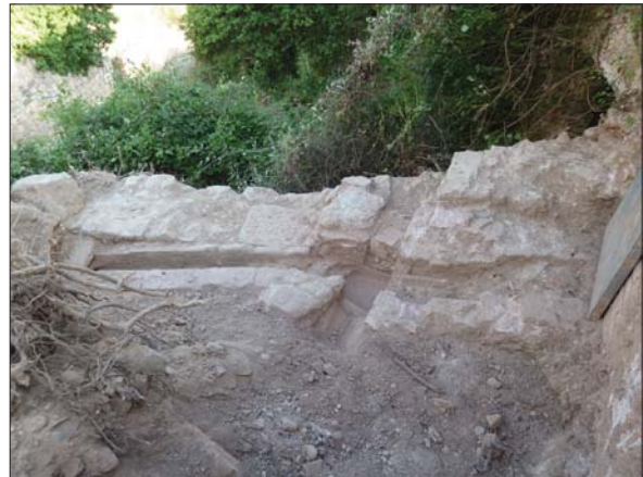
Figura 5. Vista del pas de la conducció antiga de l'aigua cap a l'interior de la cartoixa a través del mur de tancament actual.
