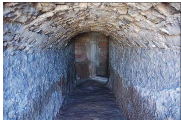
Figura 36. Imatge del túnel 1 amb la porta realitzada amb carreus tallats de roca sorrenca que dona accés a les escales que pugen fins a l'interior de l'àmbit A del castell (E. Píriz).
