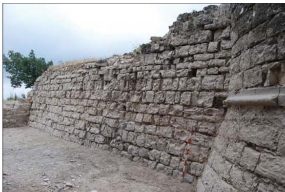
Figura 19. Reforç de la cara nord-est del recinte central del castell realitzat mitjançant un folre atalussat format per grans carreus (E. Píriz).
