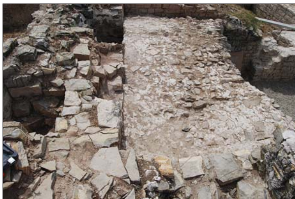
Figura 24. Part conservada de la volta de pedra que cobria la totalitat de l'àmbit interior B, sobre la qual es recolzava el paviment de la planta primera (E. Píriz).
