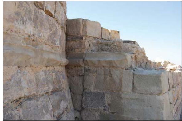
Figura 30. Detall del punt de trobada entre el mur de tancament de la cara nord-occidental de l'àmbit interior A, la torre Nord i el reforç exterior del mur. La motllura de la torre es repeteix al folre (E. Píriz).
