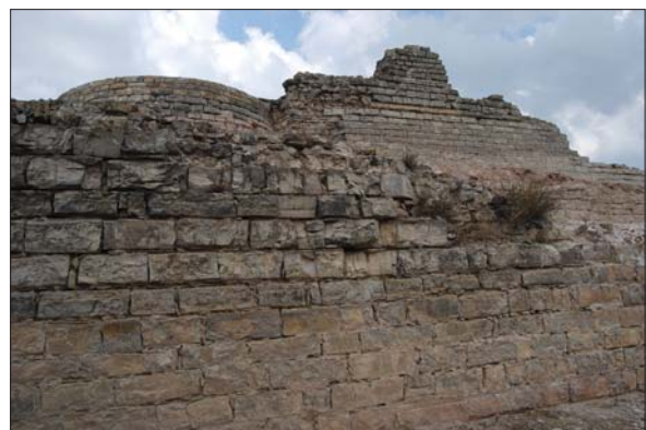
Figura 17. Parament exterior de la muralla exterior construïda al segle XVI amb carreuada de grans dimensions que tanca el conjunt del castell al sud-oest (E. Píriz).
