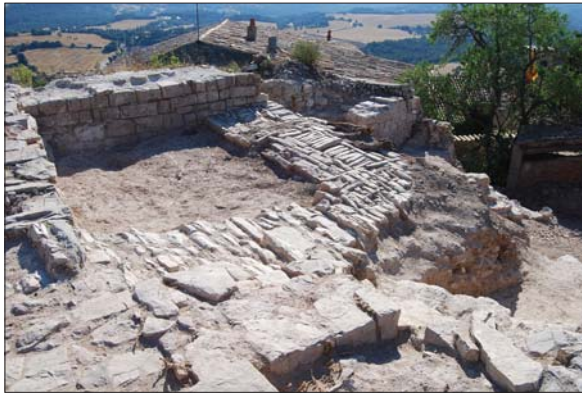
Figura 20. Imatge de l'interior de la torre Est on es poden apreciar les restes del paviment de pedra i l'estat d'espoli de les estructures que la conformaven (E. Píriz).
