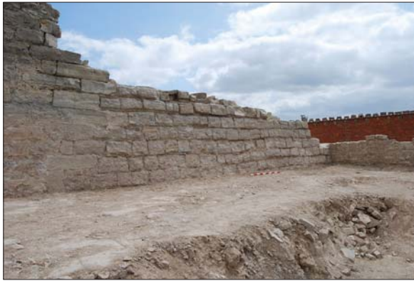
Figura 7. Fotografia de la cara exterior de la torre Sud al seu costat sud-oest. Es pot apreciar la seva factura a base de filades regulars de carreus de roca calcària. A l'extrem esquerre, es pot diferenciar la cantonada original de la torre, que estava formada per carreus de roca sorrenca (E. Píriz).
