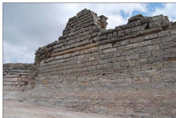
Figura 15. Parament exterior del mur del segle XVI que tanca el recinte central a la seva cara sud-oest. Es pot apreciar la gran dimensió dels carreus i la motllura horitzontal de roca sorrenca (E. Píriz).
