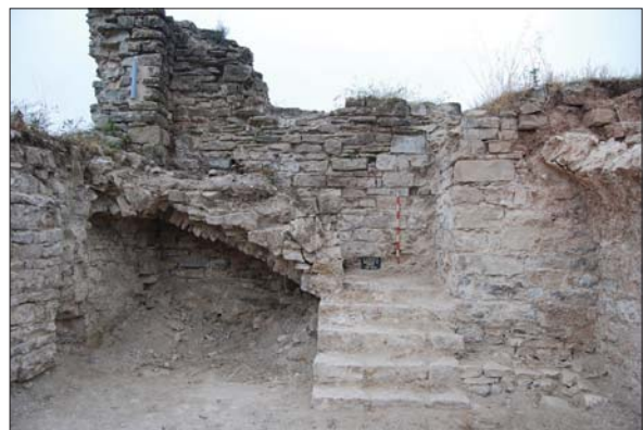
Figura 23. Escala de pedra que comunica la planta baixa de l'àmbit interior B amb la planta primera de l'àmbit interior C3 (E. Píriz).
