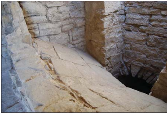
Figura 26. Imatge de l'àmbit interior A1 amb l'estructura en forma de rampa que emboca cap al túnel 2 (E. Píriz).
