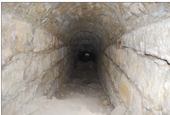
Figura 27. Fotografia del interior del túnel 2 (E. Píriz).
