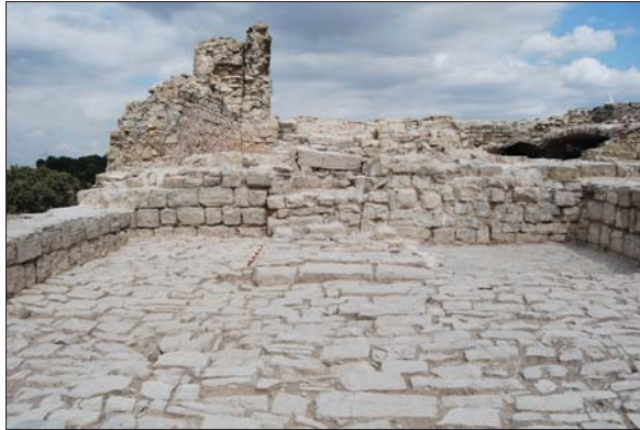
Figura 10. Fotografia de l'interior de la torre Sud. A la imatge veiem clarament les tres estructures diferenciades que componen el mur nord-occidental de la torre. Es pot veure com a la part central trobem el mur perpendicular que després és aprofitat per la rampa per donar accés a la planta superior (E. Píriz).
