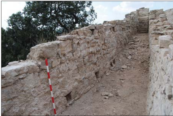
Figura 18. Espai entre la muralla exterior construïda al segle XVI i la muralla anterior datada al segle XV. La cara interior de la muralla exterior està construïda amb carreus de dimensions menors als de la cara exterior i disposa dels forats dels caps de les bigues que lligarien les dues muralles i aconseguirien un element defensiu amb més inèrcia (E. Píriz).
