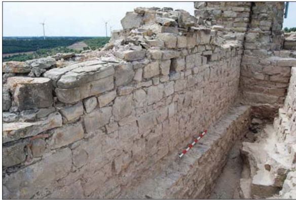
Figura 16. Cara interior del mur del segle XVI que tanca el recinte central a la seva cara sud-oest. Es poden veure els forats al mur pels caps de les bigues que el lligaven amb el mur preexistent (E. Píriz).
