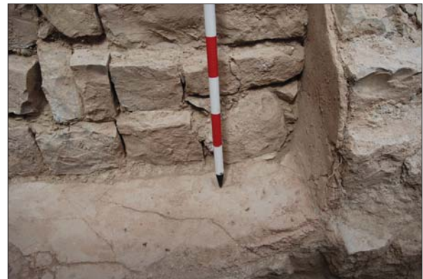
Figura 5. Detall del revestiment de morter impermeable de la cisterna altmedieval, amb la muralla posterior que s'hi recolza directament (E. Píriz).
