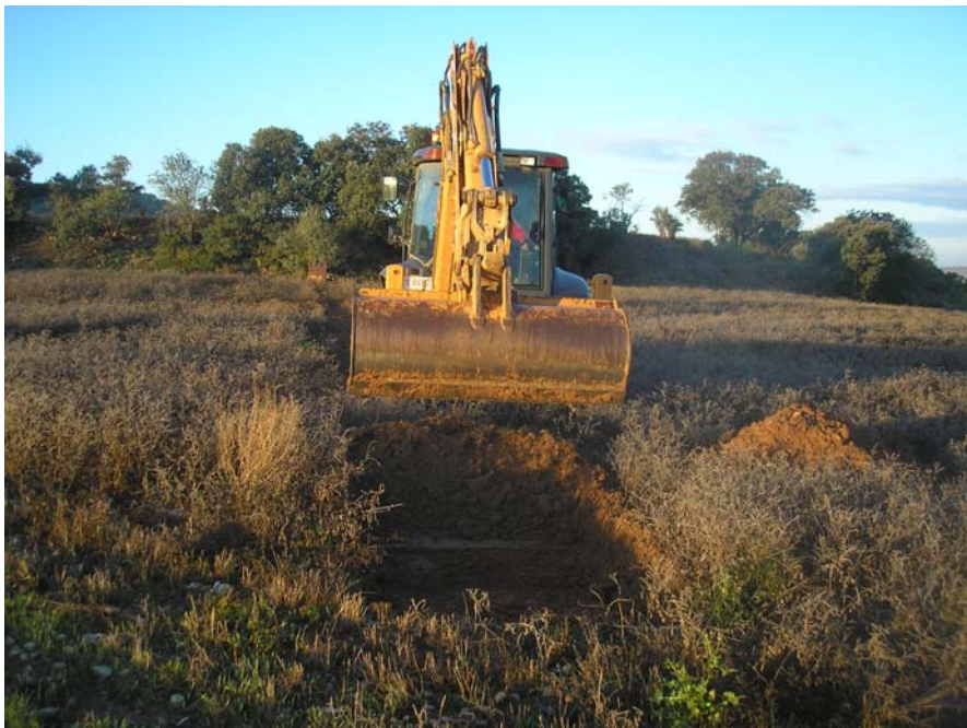
Inici dels treballs d'obertura del sondeig 01
