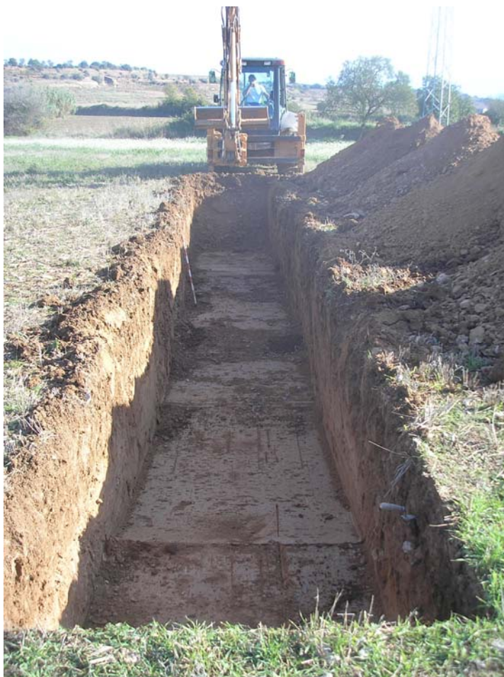
Finalització dels treballs a la rasa 10.
