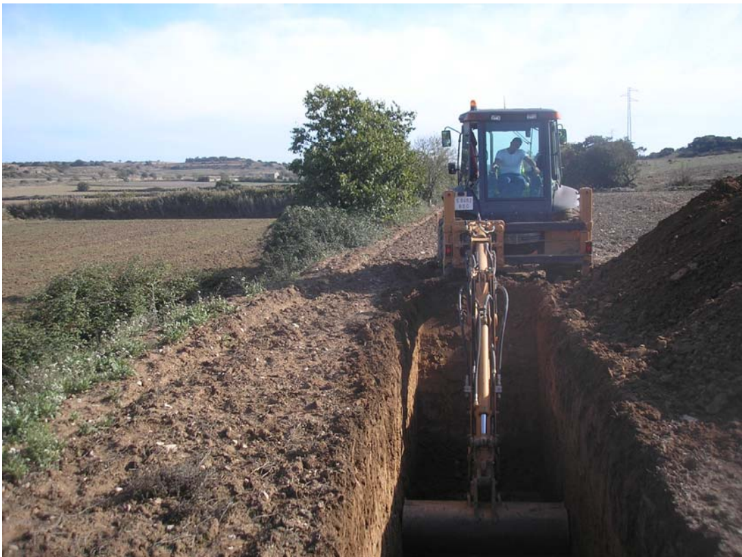
Obertura del sondeig 11. A l'esquerra de la imatge s'observa el desnivell entre ambdós camps.
