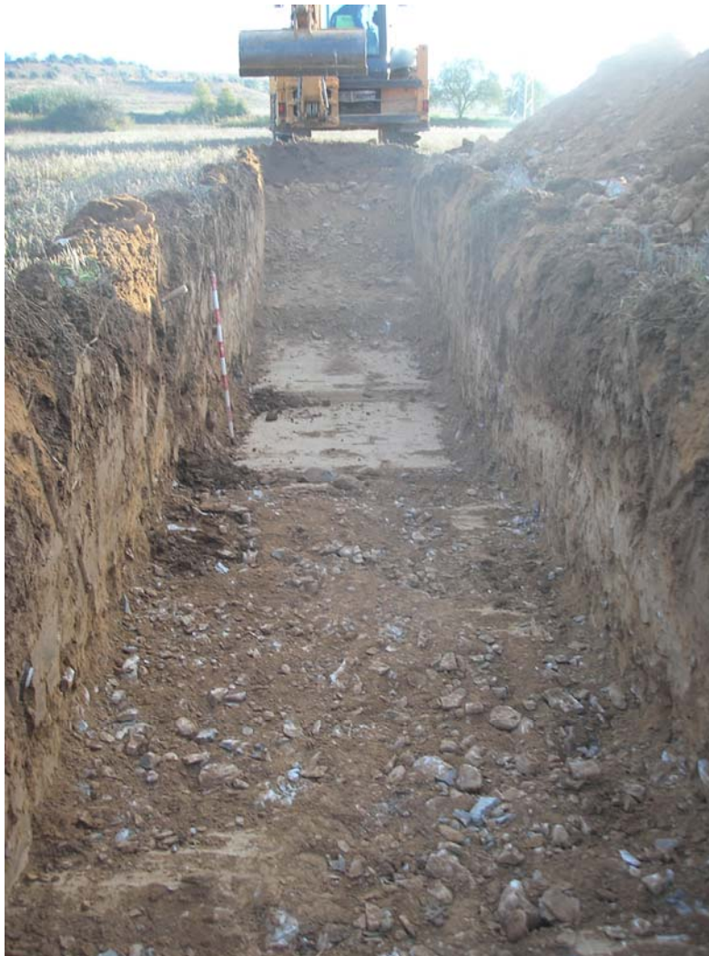
Pla general de la rasa 09 durant els treballs d'obertura.
