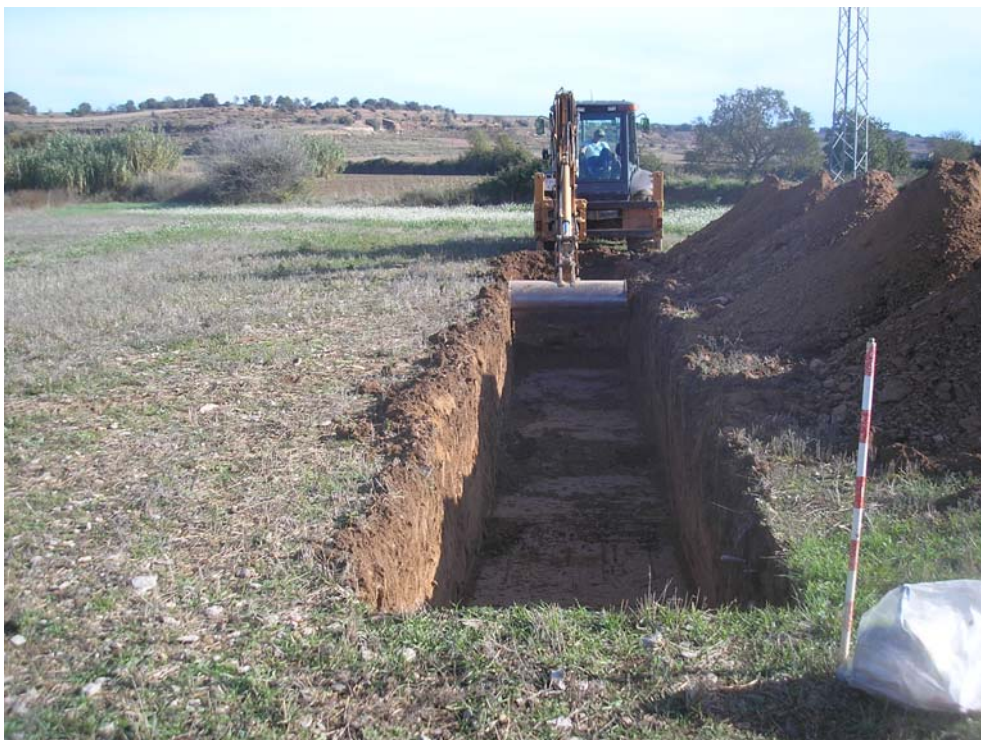
Detall dels treballs realitzats durant l'obertura de la rasa 10
