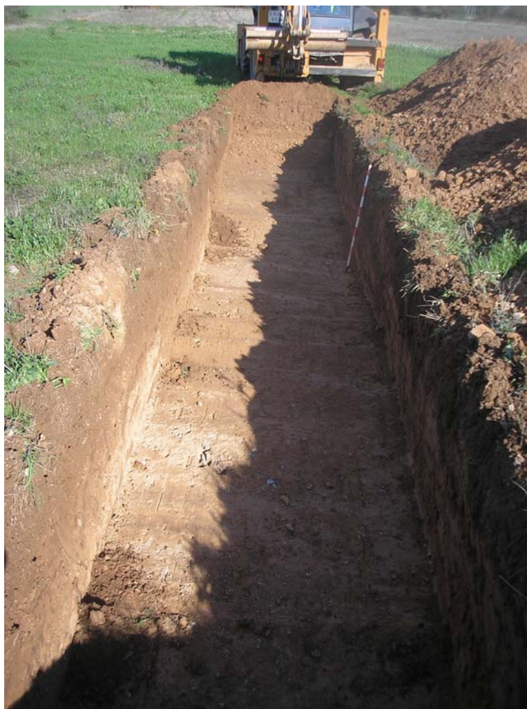
Inici dels treballs d'obertura del sondeig 07.
