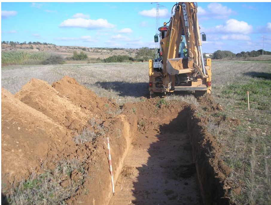
Obertura del sondeig 08. Com s'observa a la imatge, les terres eren acumulades al lateral de la rasa per, posteriorment, tapar de nou la rasa.
