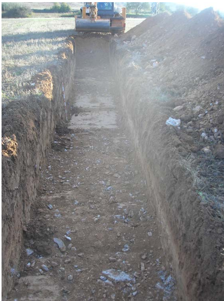
Imatge de la rasa 09 un cop finalitzada la seva excavació.
