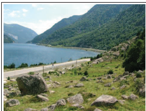
Foto 56: A.P. 17, vista general de la carretera. Zona con túneles.
