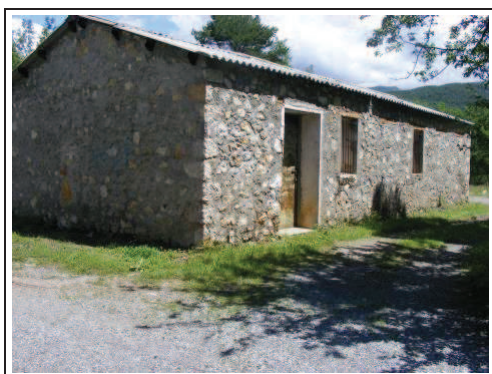
Foto 76: E.D. 8, Borda de planta rectangular construida en piedra y mortero de cal, reformada.
