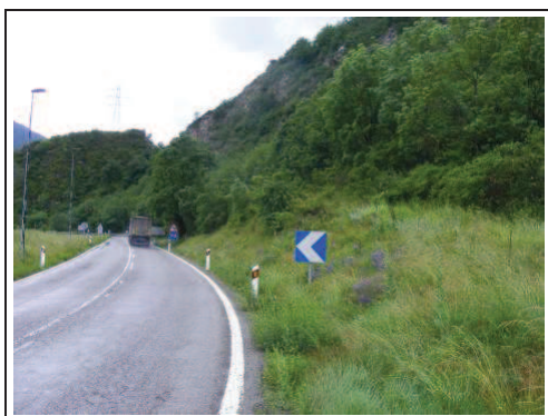
Foto 19: A.P. 4, zona de bosque y matorros, accesos al Pont de Suer.
