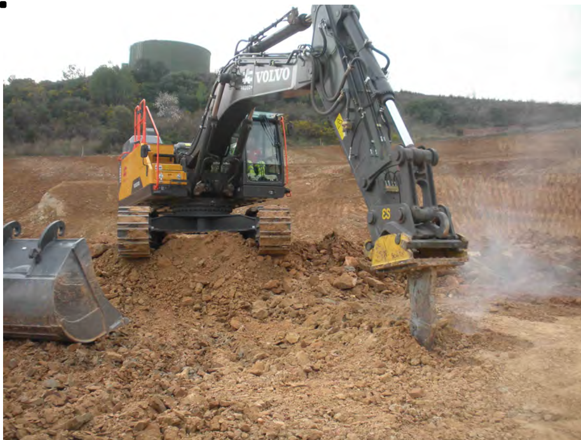
Figura B.12. Imatge de la giratòria Volvo EC380E excavant sediment miocens a la part central del sector PCM amb el riper adaptat el 16/02/18.
