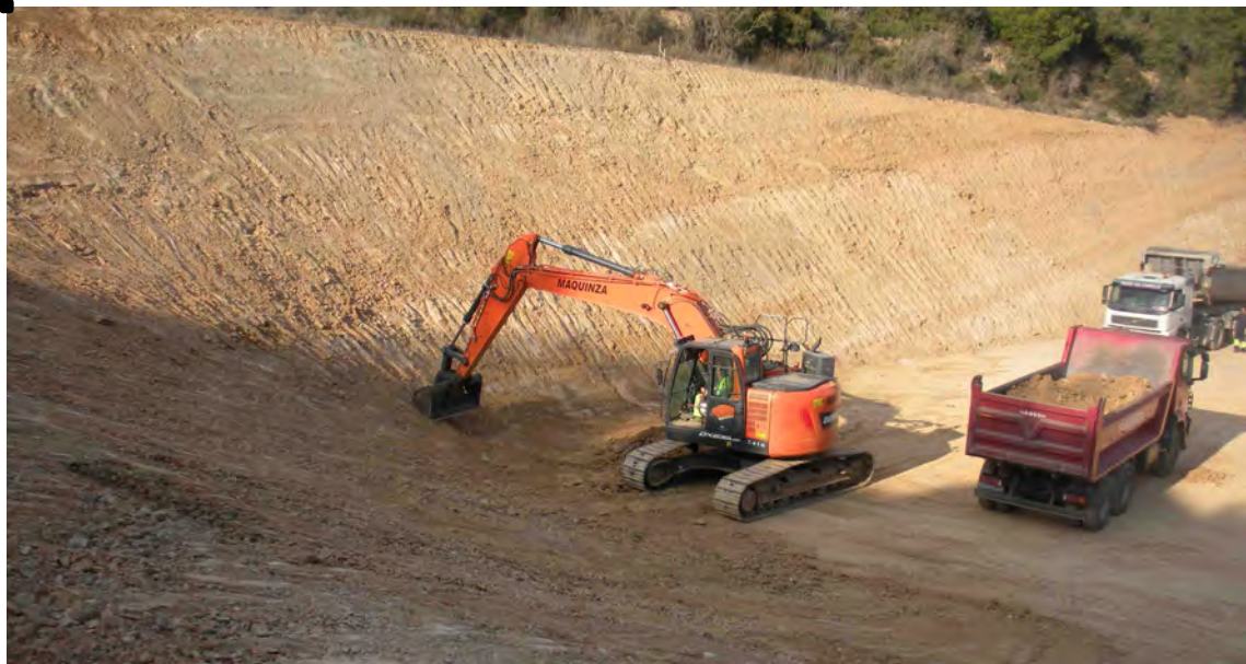
Figura B.16. Imatge de la giratòria Doosan Dx235 perfilant el talús N del sector PCM el 22/01/18.
