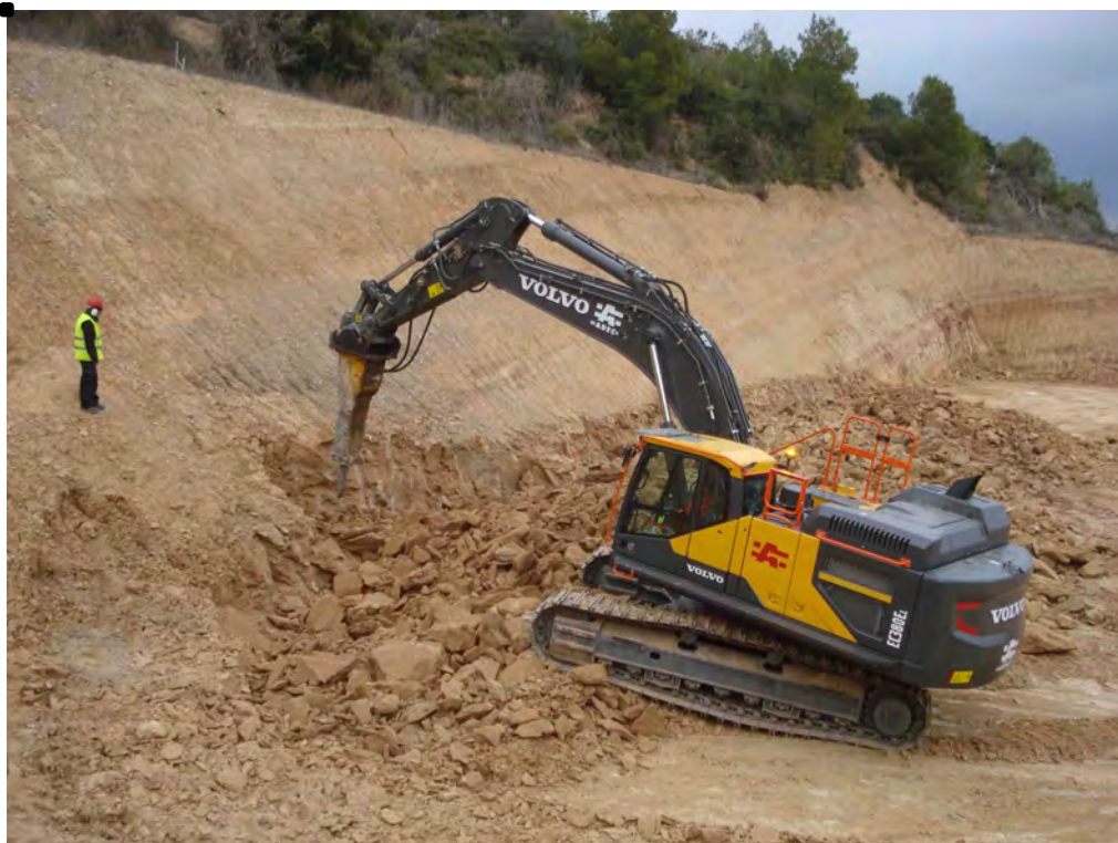
Figura B.14. Imatge de la giratòria Volvo EC380E amb martell adaptat amb el corresponent seguiment paleontològic a la part més al N del sector PCM el 19/02/18.
