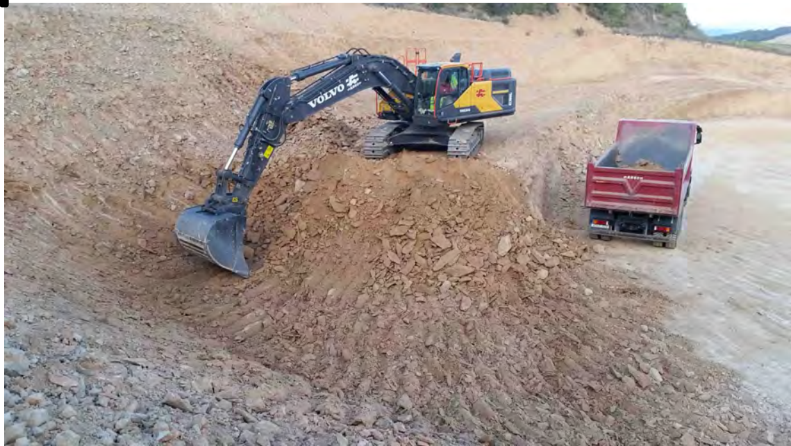
Figura B.8. Imatge de la giratòria Volvo EC380E excavant sediments miocens a la part més al N del sector PCM el 22/01/18.
