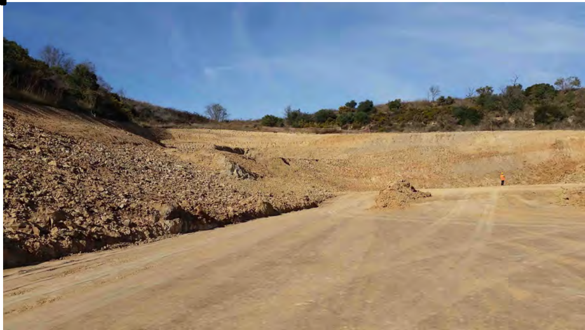
Figura C.8. Panoràmica del talús N del sector PCM el 24/01/18.
