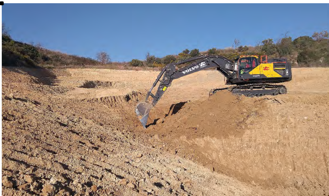
Figura B.1. Imatge de la giratòria principal Volvo EC380E recollint acopis a prop del talús NO del sector PCM, previ a l'excavació de miocè el 21/12/17.
