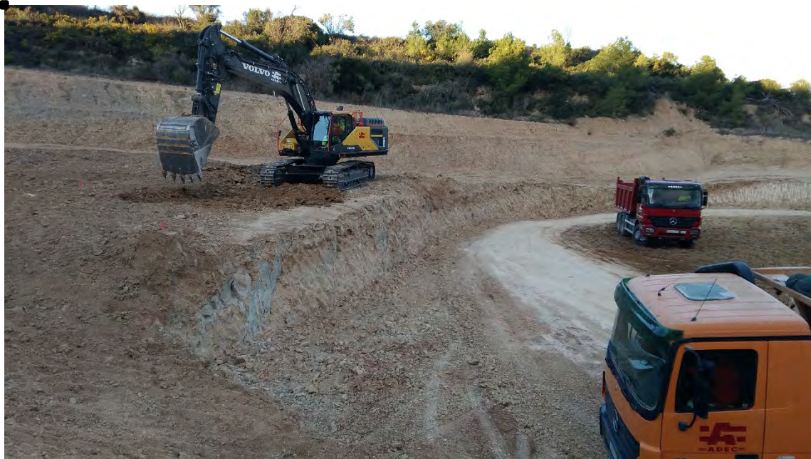
Figura B.2. Imatge de la giratòria principal Volvo EC380E iniciant excavació miocena a la part N del sector PCM el 27/12/18.
