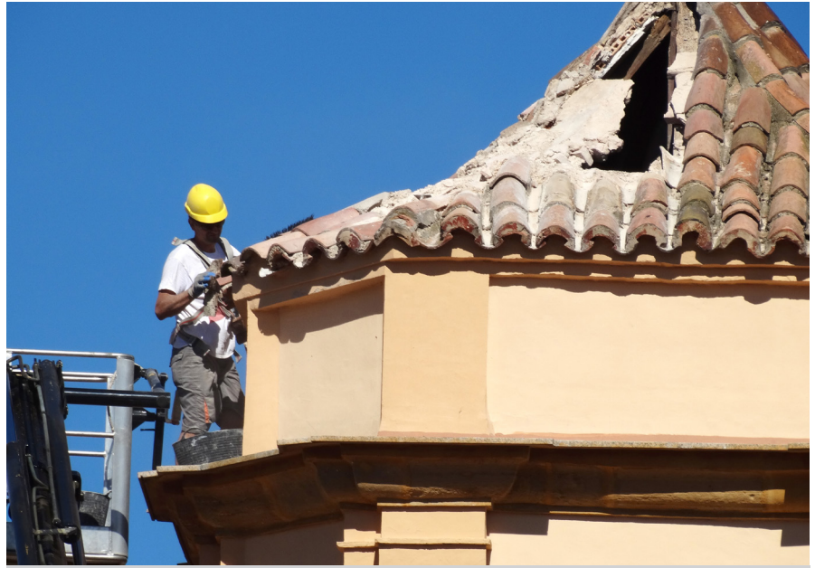
L'Estefano arreglant els desperfectes del campanar, al costat de la grua que va permetre accedir-hi amb facilitat.
