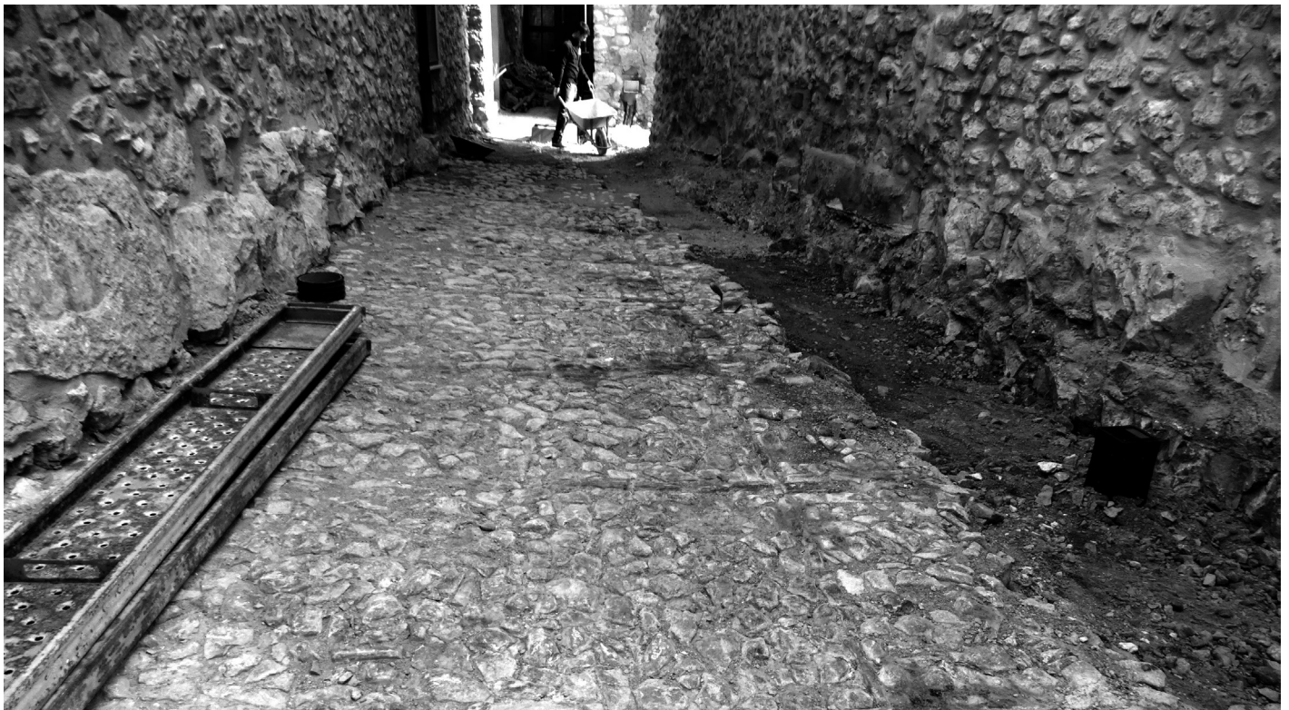
Les obres al c. del Forn permeten recuperar part de l'antic empedrat.
