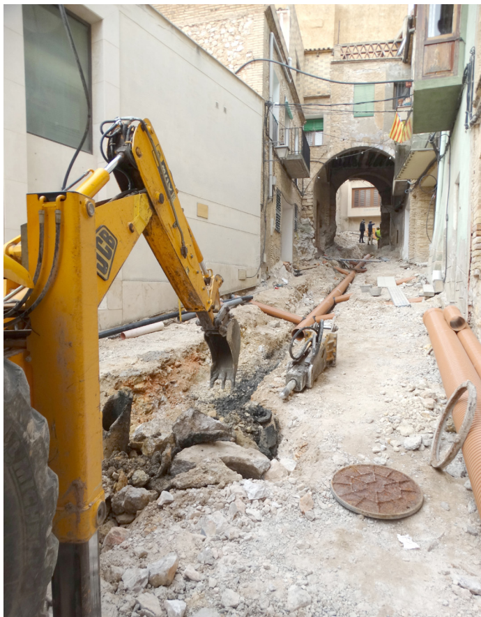
Instal·lació de les canonades de les clavegueres al carrer de les Barreres.
