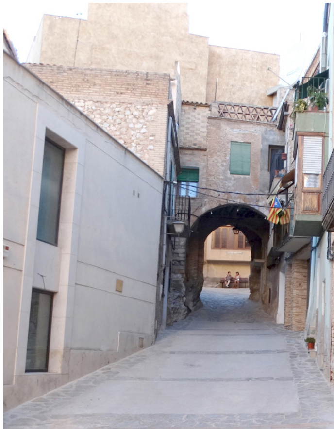
El carrer de les Barreres després de finalitzades les obres.
