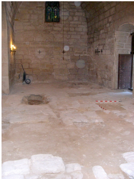
Enllosat a la nau
