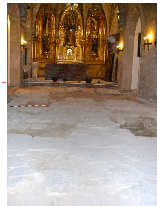
Enllosat a la nau
