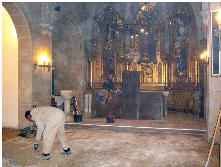
Làmina 09. Procés d'aixecament del paviment modern a la nau.
