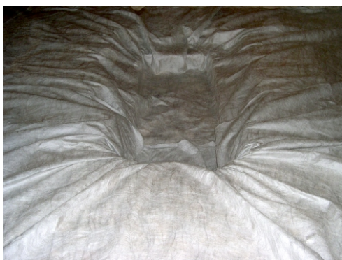
Làmina 23. Cobriment de l'enllosat i dels elements interiors amb geotextil
