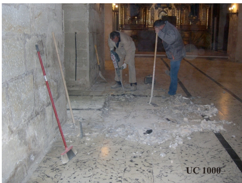
Làmina 07. Rasa de control prèvia a l'aixecament del paviment modern.
