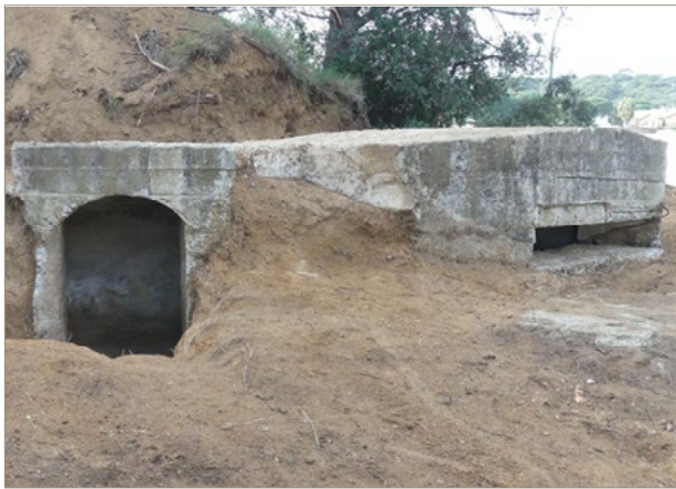
Figura 1. El niu de metralladores després de la neteja exterior.
