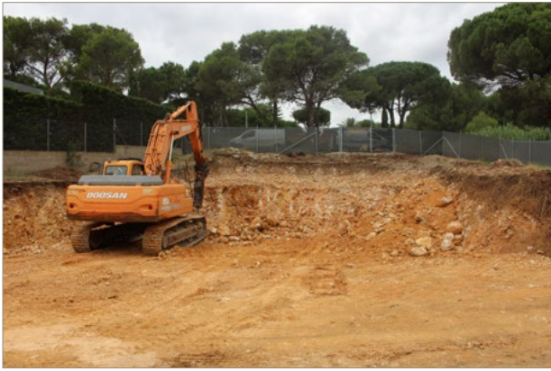
Figura 1. Procés de rebaix de la roca del subsol de la meitat oest de la parcel·la.
