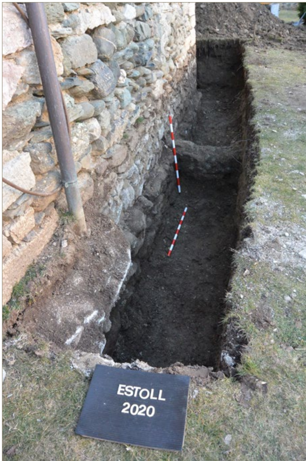
Figura 1. Rasa amb banqueta de fonamentació.
