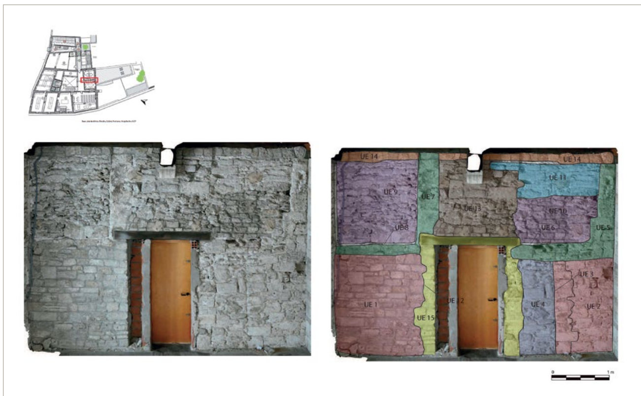
Figura 1. Ortofotogrametria de la paret oest del cos, amb indicació de les diverses fases i reformes identificades.
