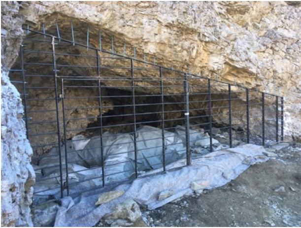
Figura 2. Imatge de la construcció del nou reixat i porta d'accés a la Cova 338 amb l'objectiu de garantir la preservació dels dipòsits sedimentaris i la continuació dels treballs arqueològics en els propers anys (autor: Ramon Busquets).
