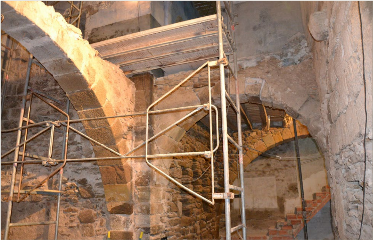
Figura 2. Interior de l'edifici una vegada desmuntat el terra del primer pis.
