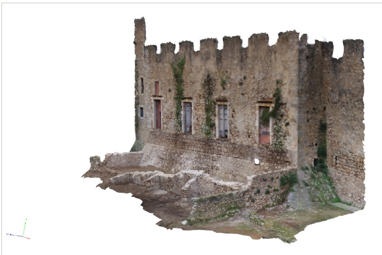
Figura 2. Model 3D de la terrassa i de l'edifici al qual estava adossada, un cop finalitzats els treballs d'excavació (Pau Castillo, https://sketchfab.com/3d-models/palau-abat-palacio-abad-abbe-palace-7627de4d3a064abd9850582945f236c8 ).
