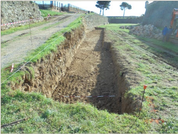
Figura 2. Imatge general de la rasa un cop finalitzada l'excavació.
