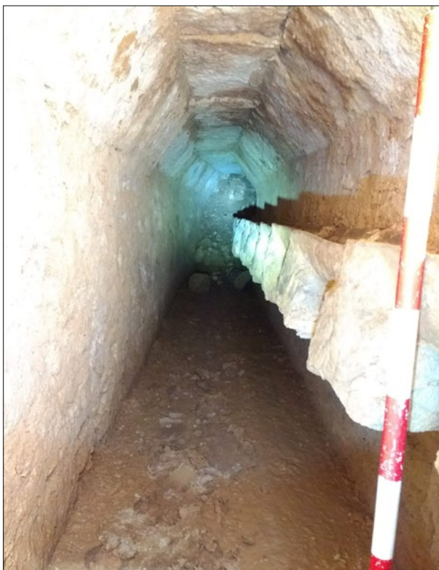
Figura 2. Interior de la Mina d'aigua de Banyoles.
