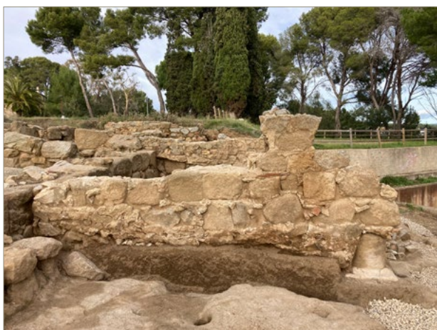
Figura 2. Vista general del mur 1822, després de la intervenció.
