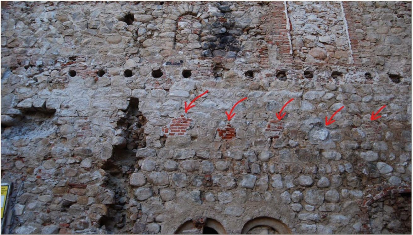
Figura 2. Imatge de l'espai entre la finestra geminada de la planta baixa de la façana interior de l'ala est i la finestra esqueixada, on es pot veure, amb fletxes vermelles, la ubicació d'uns retalls al mur que es poden correspondre amb els caps de les bigues que formarien la teulada de la galeria del claustre del segle XII-XIII. 30/JUL/2021 (E. Piriz).
