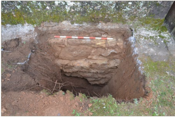
Figura 2. Detall de la cala feta ran del mur nord, amb les successives banquetes de fonamentació de l'ampliació barroca del temple.
