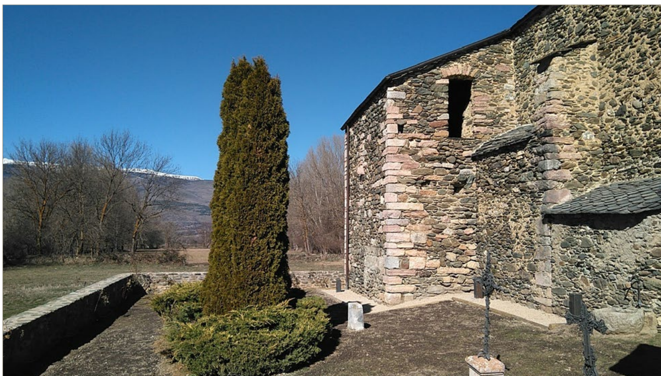
Figura 1. Vista general de la localització de l'actuació amb la rasa un cop coberta.
