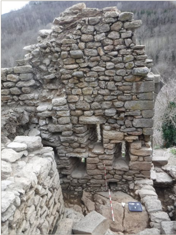
Figura 1. Vista general de la intervenció de 2021 al portal sud, des de l'interior del recinte.
