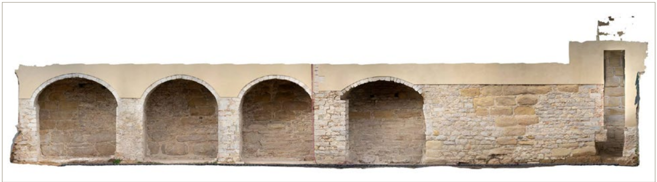
Figura 1. Vista general del tram de muralla exterior, després de la intervenció.
