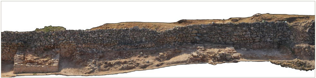
Figura 1. Zona desbrossada durant la campanya del 2021. Entre la torre 7 i la torre 8 l'estrat d'enderroc de la muralla serveix per fonamentar la reconstrucció moderna. No s'ha enretirat per no posar en perill la seva estabilitat.
