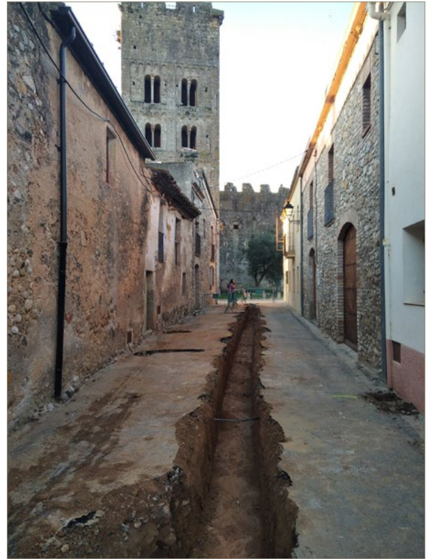
Figura 2. Aixecament del paviment antic del carrer Major i rasa central de serveis.
