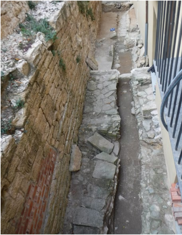
Figura 2. Vista general dels sectors 2 a 5 al final de la intervenció des del sud.
