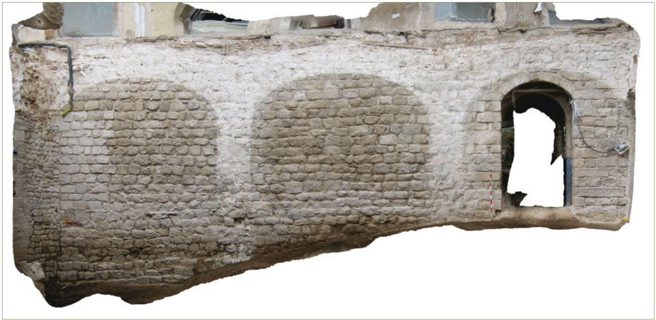
Figura 2. Fotogrametria del tram de muralla baix medieval que es troba a la sala oest (sector 2) de la Casa Pastors.
