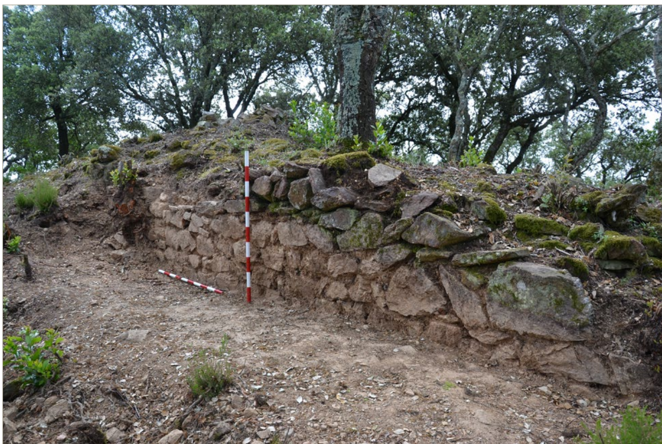
Figura 2. Estructura exterior. Mur de tancament nord.
