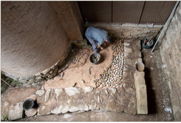
Figura 1. Imatge durant el procés de treball de reproducció del paviment.
