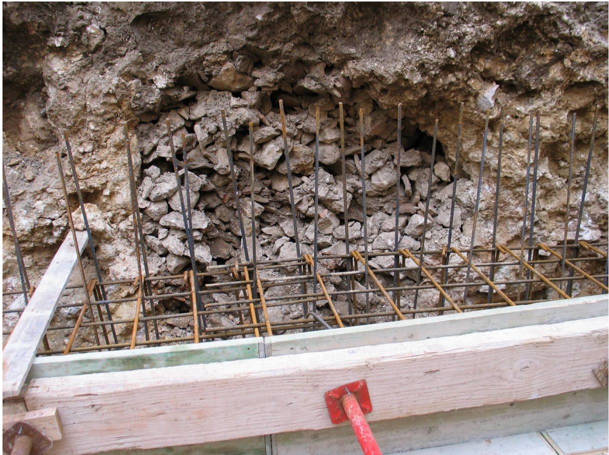
Fig. 7: Detall de la secció est del carreró de l'Església tal com va aparèixer a les obres de l'any 2006, en la que es veu un retall a la roca reblert amb runa petita (foto AM Puig)
