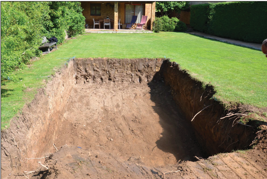
10 i 11. Dues vistes generals del rebaix una vegada acabat.
