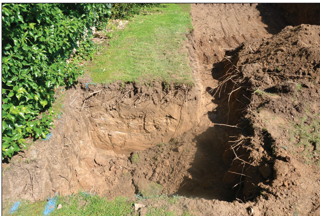
14. Vista general del rebaix per a la instal·lació auxiliar i la rasa que la comunica amb la piscina.
