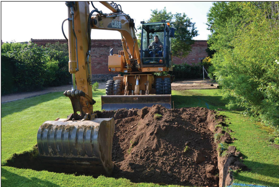
6 i 7. Dues imatges del treball de la màquina excavadora.
