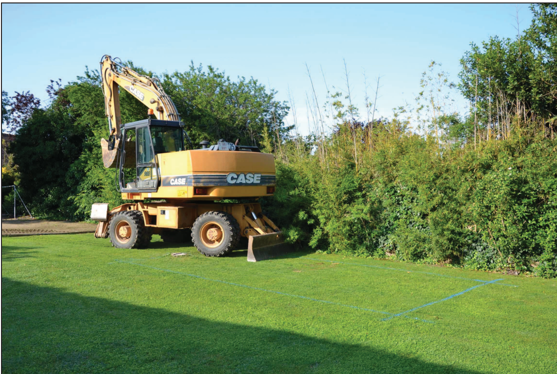
5. Vista general de la zona on s'ha obert el forat per a la piscina, darrera la màquina excavadora.
