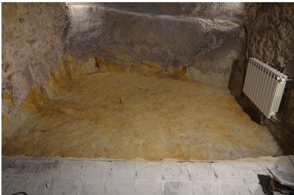
Fig. 6: Vista general de l'espai excavat, amb els murs perimetrals parcialment guanyats a la roca, i la mateixa roca anivellada per a rebre el paviment
