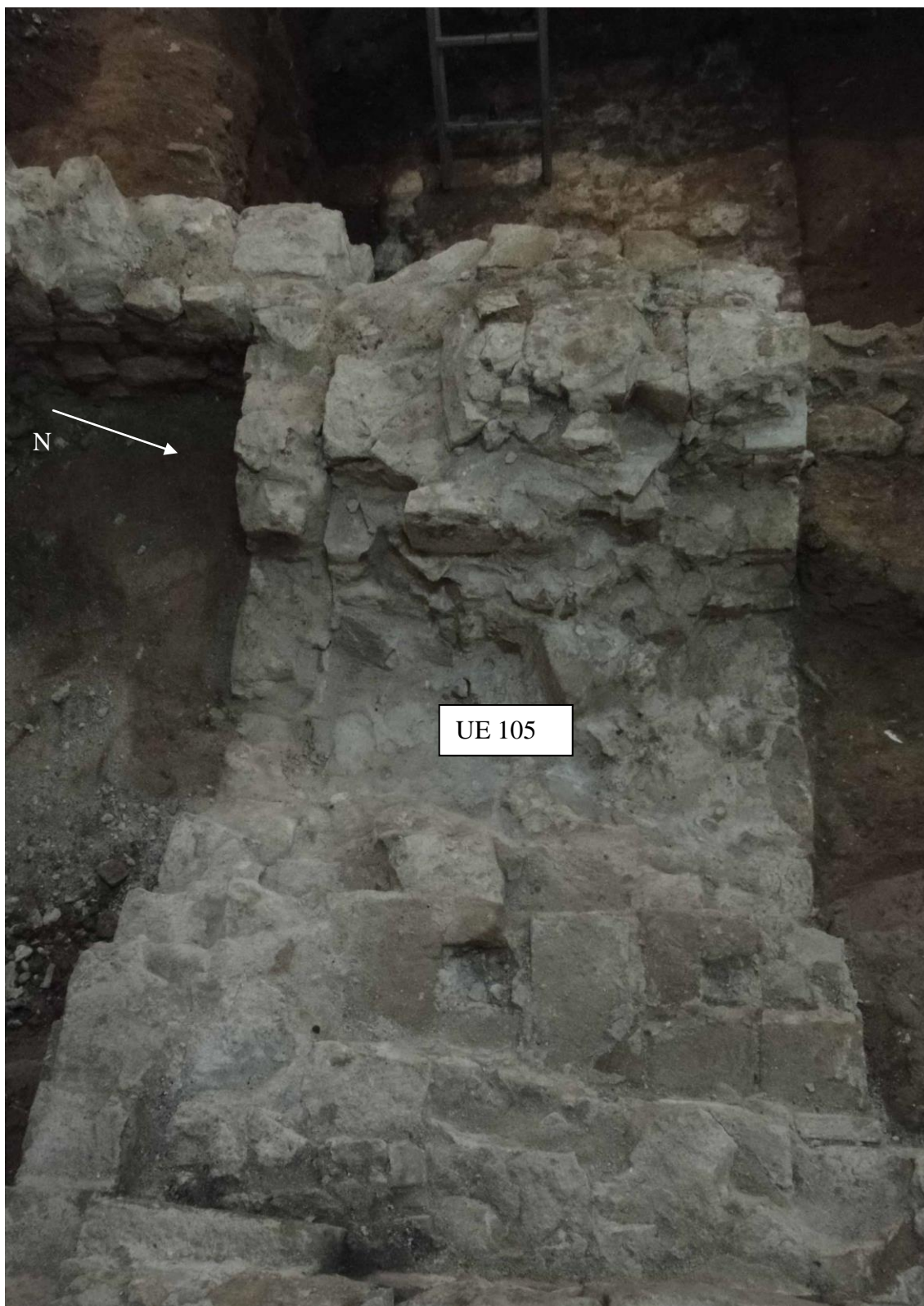
Vista des de l'oest de l'estructura 105.
