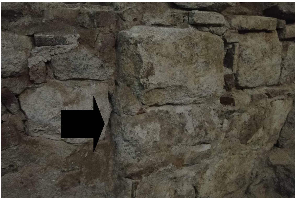
Detall de la relació de murs entre 103 i 101. La rasa 104 es reblerta pel mur 103 el qual s'entrega a 101.
