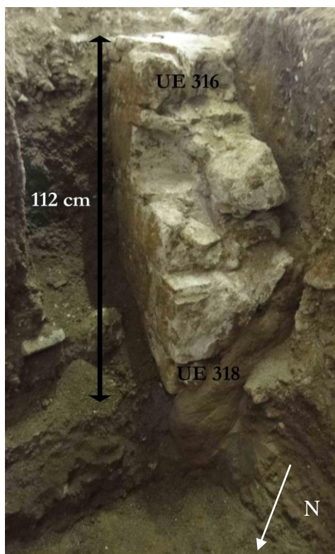
Imatge de detall del mur 316 i la rasa 318 per la seva construcció.
