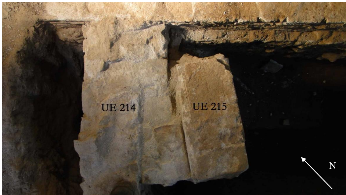
tge del procés de desmuntatge de la UE 215.
