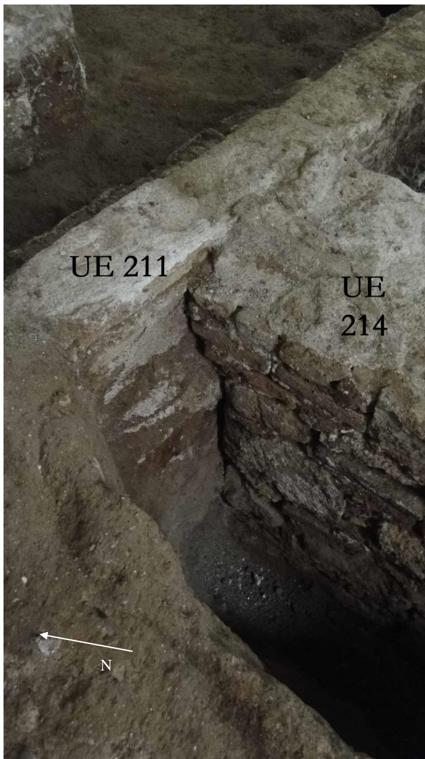
Imatge de detall del mur 214 i la rasa 216. Veiem com el mur 214 s'adossa al mur 211.
