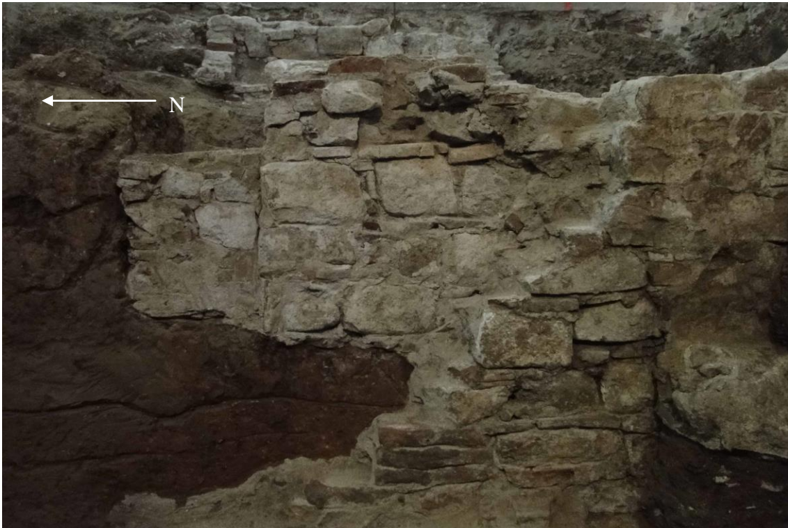
Imatge de detall de les relacions muraries de les UES 103-104, 101-102, 105; i també dels estrats naturals que són retallats i nivells d'ús antròpics.
