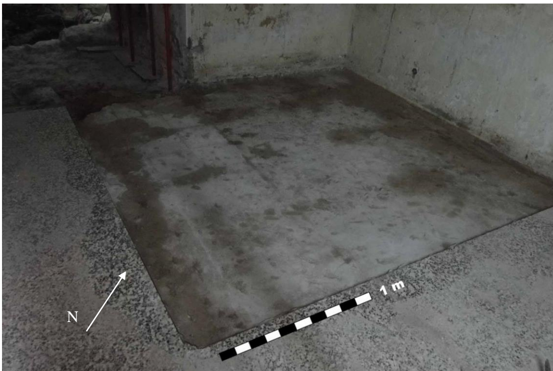
UE 201. Ciment que lligava el paviment de rajoles.
