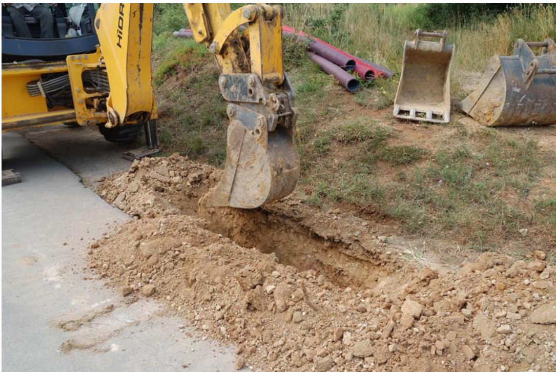
Fig. 10. Detall d'un dels sondeigs realitzats al marge dret del carrer.
