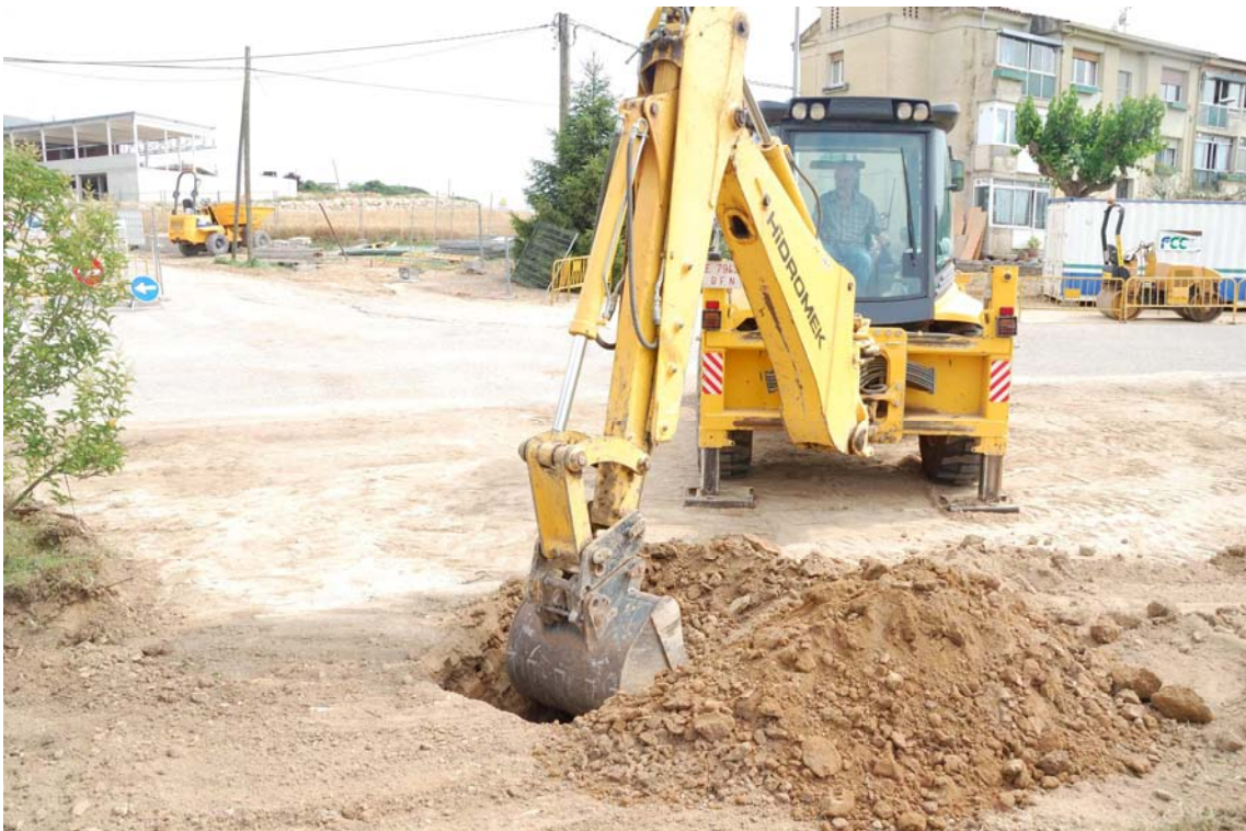
Fig. 13. Sondeig realitzat en la zona verda on posteriorment s'ha de construir la rotonda.
