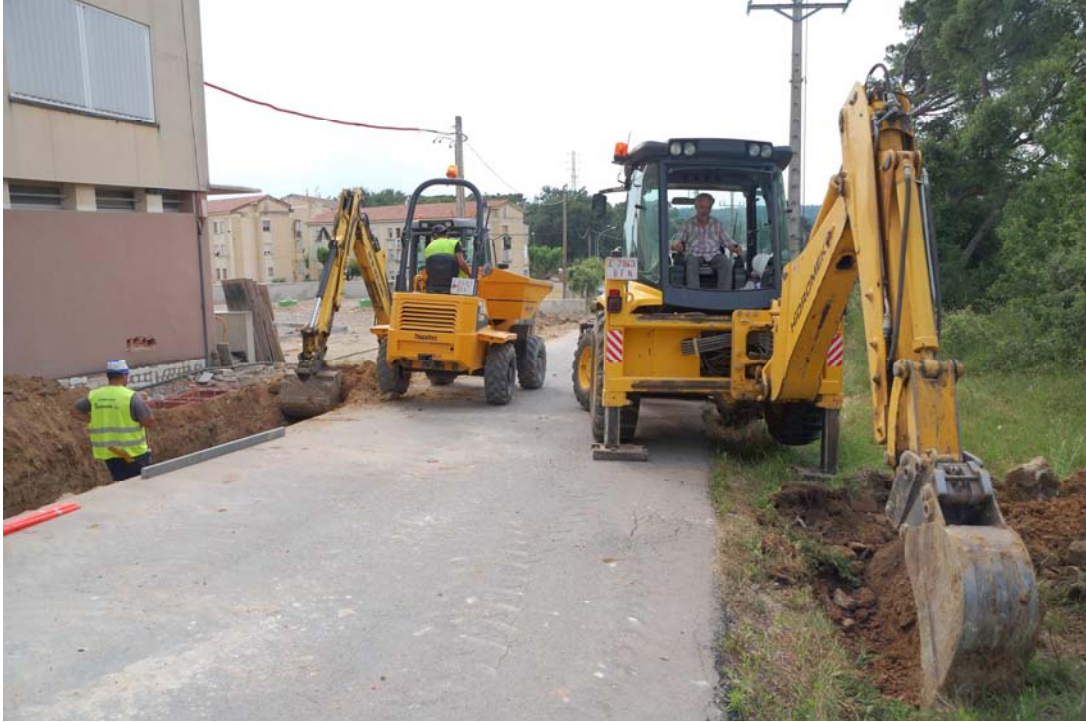
Fig. 9. Realització de sondeigs al marge dret del carrer (màquina situada a la dreta de la imatge)
