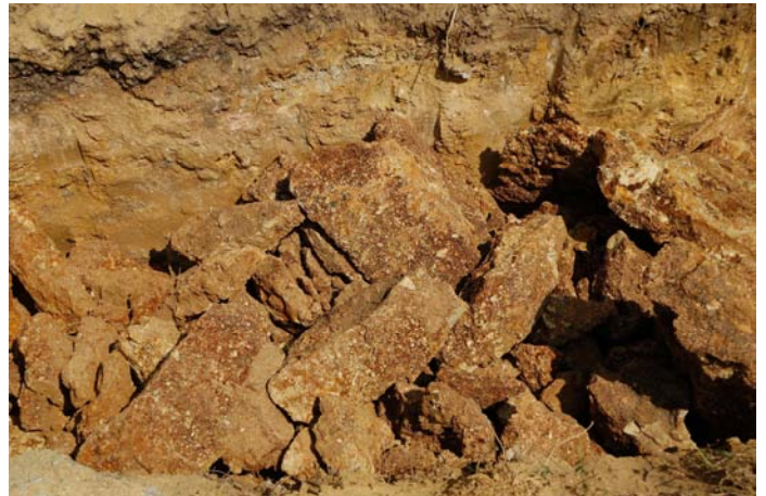
Fig. 11. a) Moment de trencament del piroclaste. Degut a la seva duresa va caldre el martell de la retroexcavadora. b) Detall del piroclast un cop trencat.
