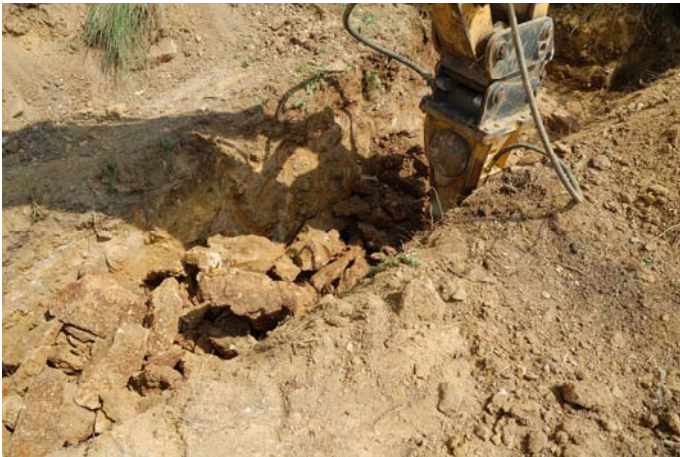
Fig. 11. a) Moment de trencament del piroclaste. Degut a la seva duresa va caldre el martell de la retroexcavadora. b) Detall del piroclast un cop trencat.
