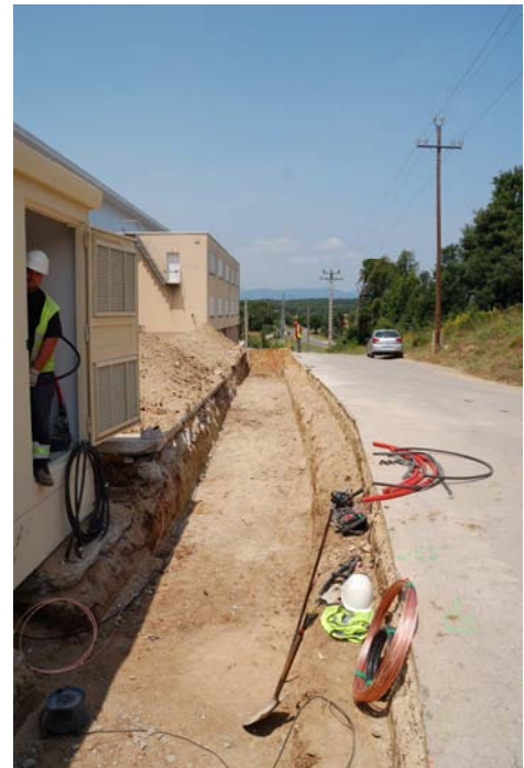
Fig. 7. Trinxera paral·lela al carrer. a) inici de les obres i b) vista a la meitat de la seva obertura.
