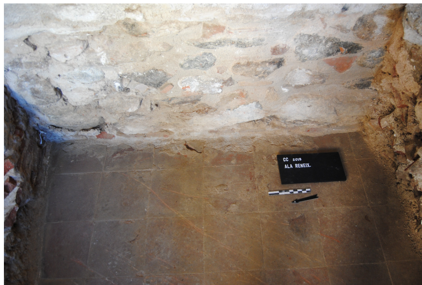
Figura 7. Detall del paviment relacionat amb la cisterna
