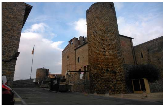
Fig. 13. La torre sud-oest a primer terme
