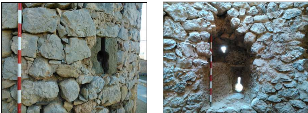
Fig. 6. Vista exterior i interior de l'espitllera U.E. 110
