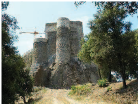
261 - Torre Nord de Montsoriu, construïda amb els carreus de l'enderroc de l'adarb.
