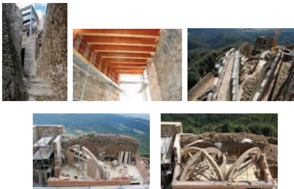
159 - Obres de restauració del cos de Guàrdia i Recinte Sobirà l'any 2010. MEMGA
