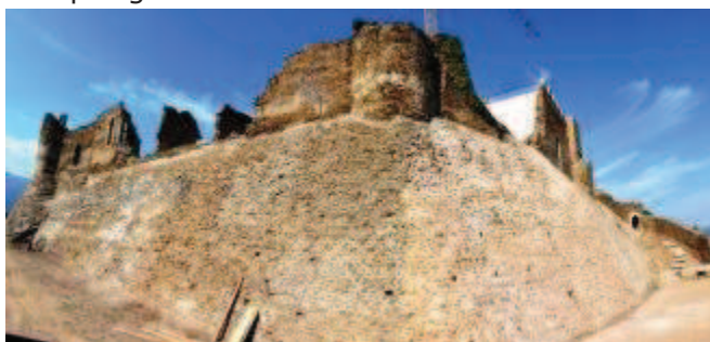
167 - Restauració del mur Sud l'any 2015
