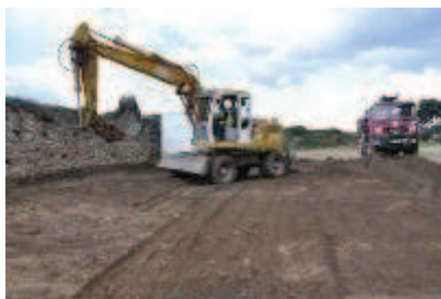
133- neteja superficial del Recinte Jussà amb mitjans mecànics
