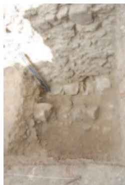
112- Nivell constructiu de sabata de fonamentació del mur (UE 30313).
