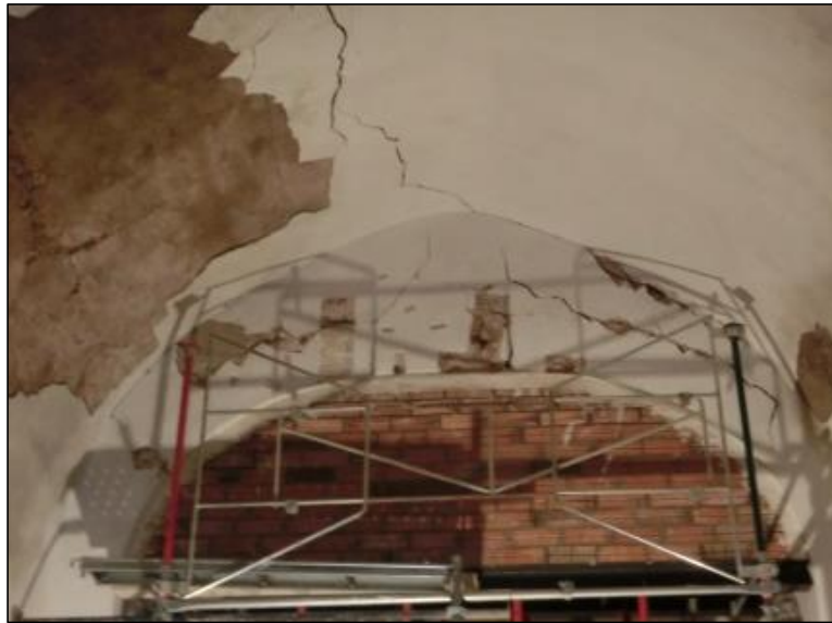
Figura 11: Localització de les cales del mur est de la nau.
