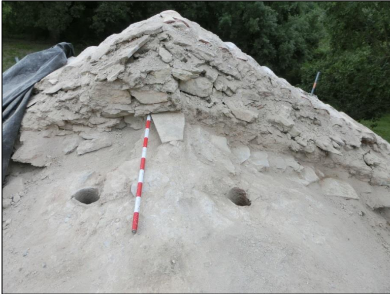
Figura 24: extrem de llevant de la coberta de la nau, un cop retirades les restes de cobertes fins la volta.
