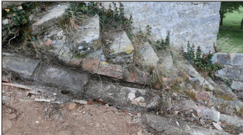
Figura 16: aspecte de l'accés esglaonat a l'espadanya en el vessant nord de la coberta.
