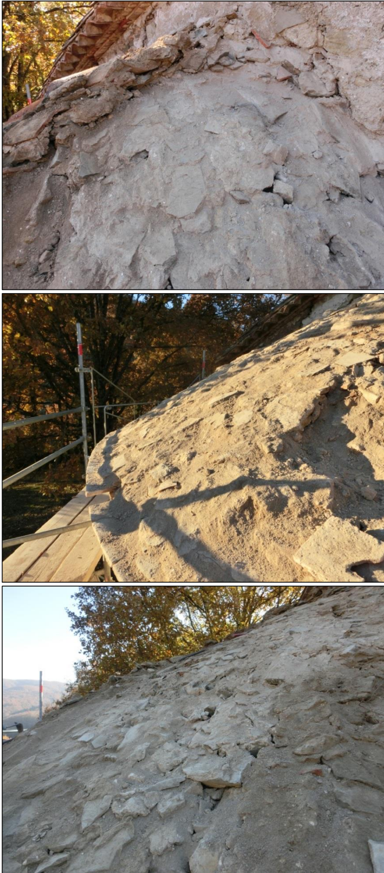
Figura 4: diferents vistes de la preparació per a la col·locació de teules
