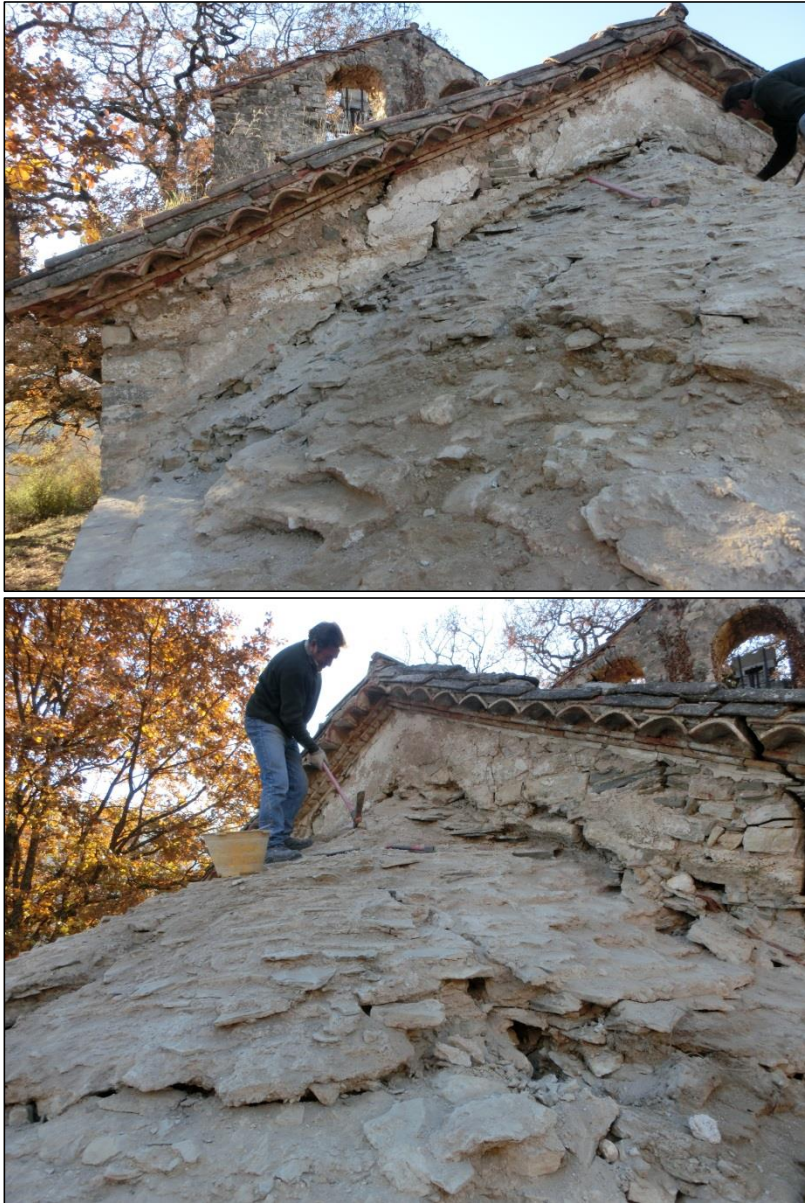
Figura 6: Absis enllosat. En aquestes imatges es pot observar el canvi important de pendent de la nova coberta d'enllosat.
