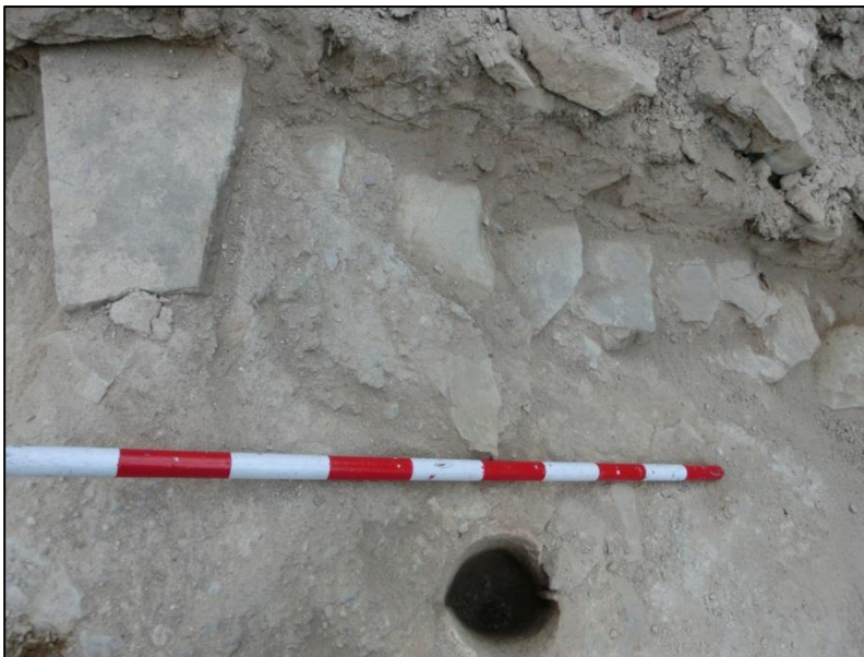
Figura 25: les esquerdes de la coberta deixen visible els elements de la volta.
