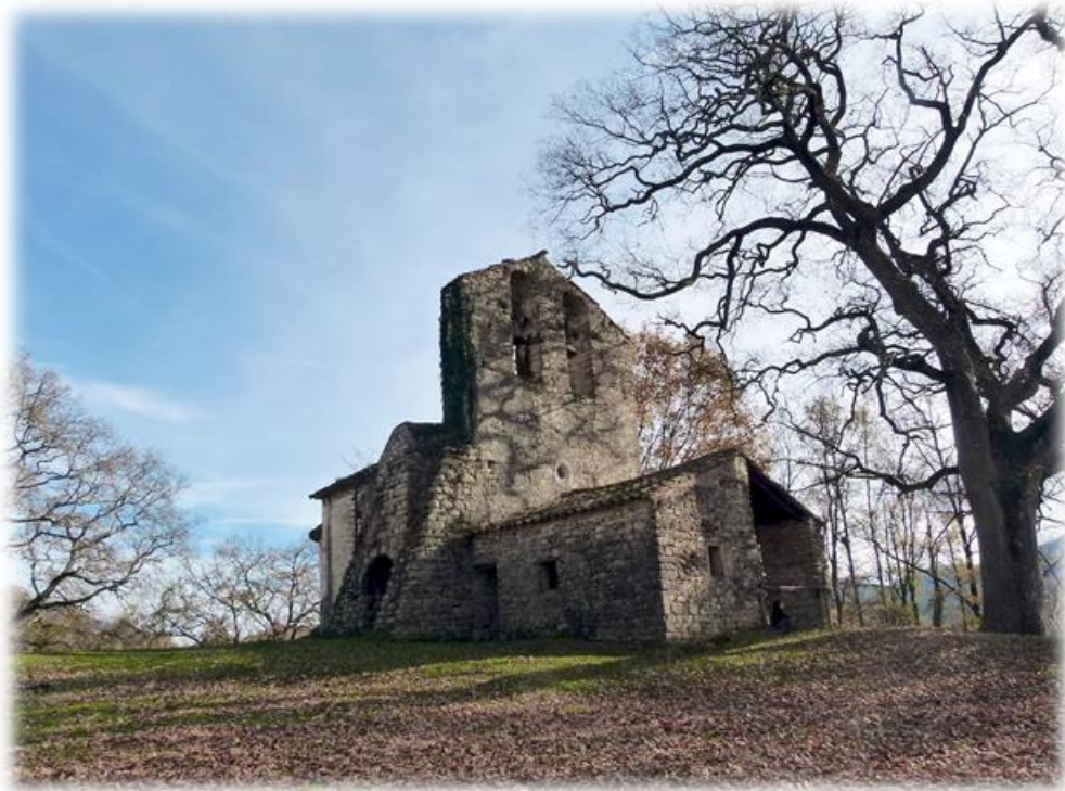
Figura 3: Vista de la construcció des de l'angle nord-oest, que permet observar el porxo de ponent, l'espadanya amb l'accés lateral i el contrafort (imatge d'arxiu)
