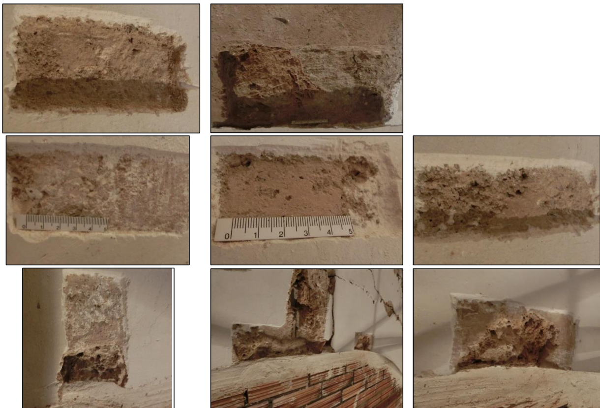
Figura 12: Cales en els murs de la capçalera de la nau
