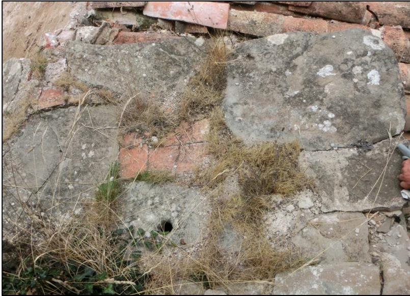
Figura 15: Vista zenital de l'enllosat de la plataforma de l'espadanya, amb un dels orificis per a la corda de la campana.
