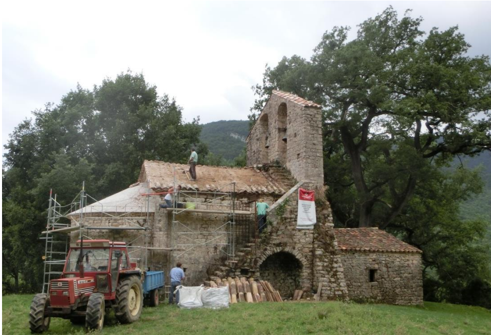
Figura 13: Inici de l'obra estiu de 2014. Vista de la cara nord.
