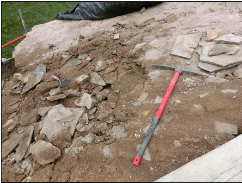
Figura 22: En el vessant nord, per sota de la coberta de teules, aparegué un nivell molt deteriorat format per restes de lloses.
