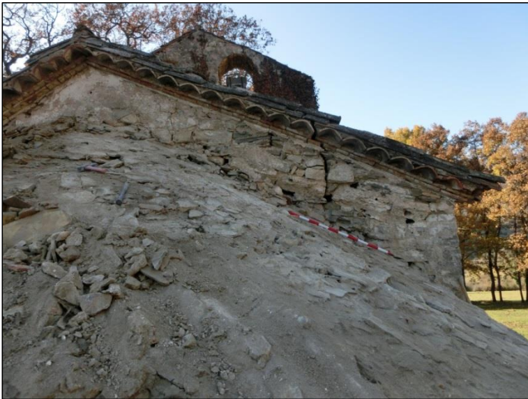
Figura 5: aspecte general del nivell base de preparació del teulat.
