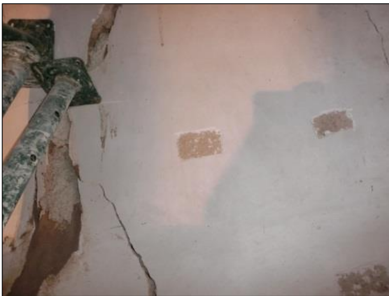
Figura 10. Localització de les cales del mur interior de l'absis, a l'àrea del pantocràtor.
