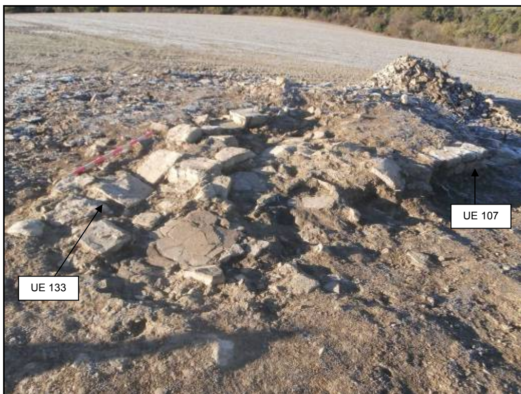
Fotografia 48: Vista general del mur UE 133 amb petit tram del mur UE 107, sector NO del jaciment.
