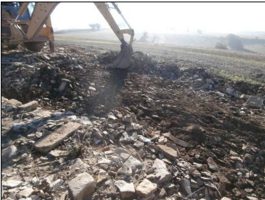
Fotografia 6: Neteja superficial del jaciment amb màquina retroexcavadora.
