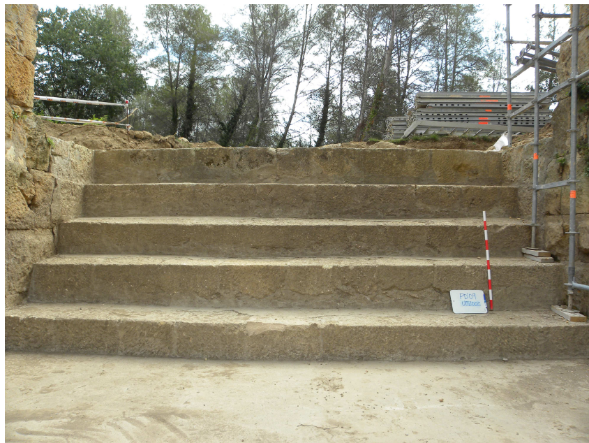
foto 1 una vista de l'estructura 14002 abans del su cobriment
