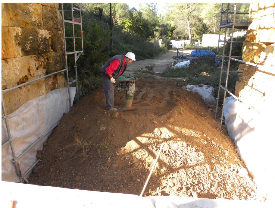
foto 10 detall dels treballs de compactat de les terres abocades
