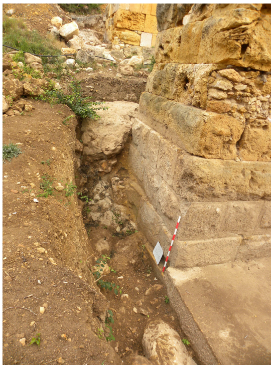
foto 2 vista del costat oest del pilar 15 abans de ser cobert
