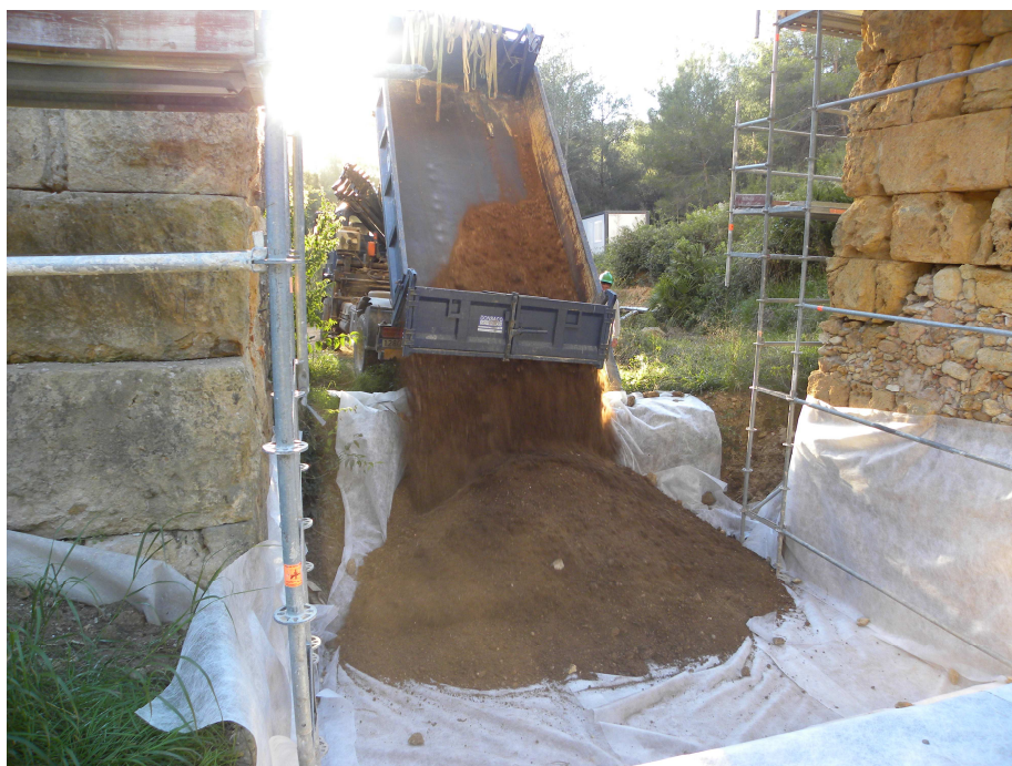
foto 9 vista de les feines de reompliment amb terra vegetal
