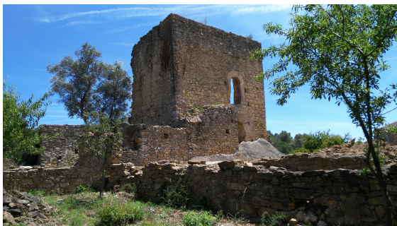
21. Vista de la torre mestra des del nord-oest. Als seus peus el petit mas adossat. En primer terme el mur de tanca del pati davant del mas central i, darrere seu, els murs UE 2002 i 2003, on s'ha efectuat la rasa 8.
