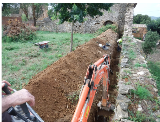
7. Excavació de la rasa 1.
