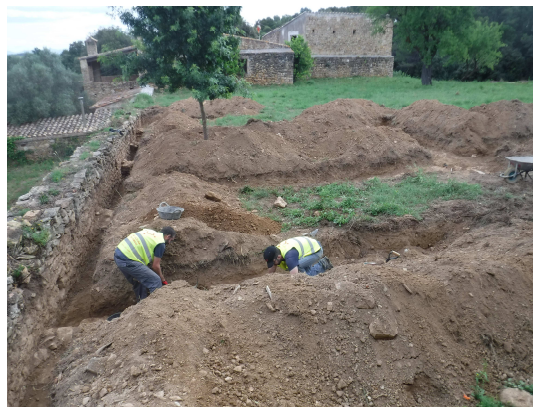
10. Vista general de les rases 1 a 5 durant l'excavació, des del sud.
