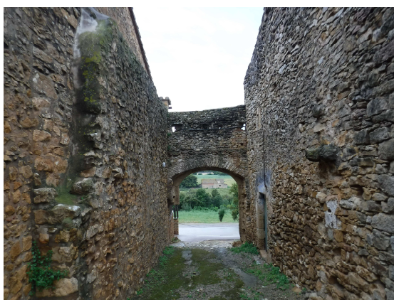
3. El portal oest, des de l'interior del recinte. Els dos masos que flanquegen l'accés són moderns, però el de l'esquerra (sud), sembla aprofitar part de les estructures del castell.
