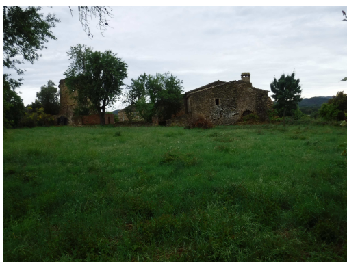
5. Sector 1 abans de la intervenció, des del nord. Al fons es veuen les edificacions de la torre mestra (esquerra) i el mas central (dreta).
