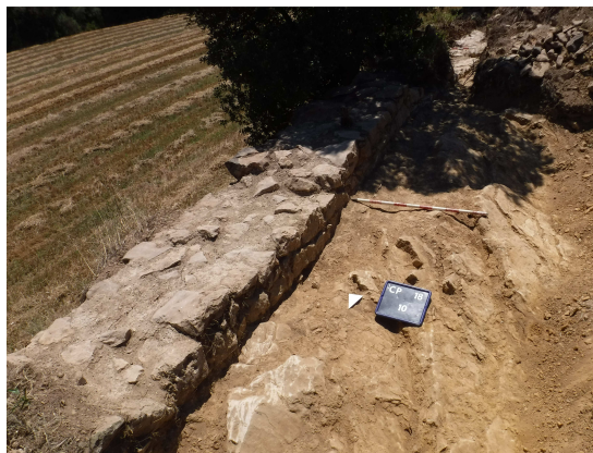
20. Rasa 7 des del nord. S'aprecien els dos trams de muralla est (UE 1014 en primer terme i 1015 al fons) i la roca mare.
