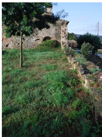
6. Muralla oest (UE 1001) abans de la intervenció, des del nord i des de l'interior del recinte. Al fons, el mas central.
