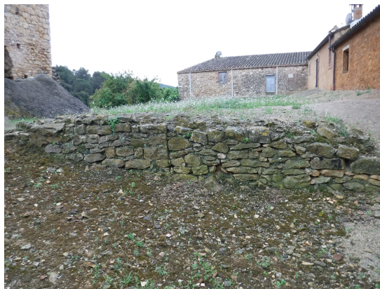
22. Sector 2 des del nord, abans de la intervenció. A l'extrem superior esquerre apareix la torre mestra i, en primer terme, la part visible dels murs UE 2002 i 2003.
