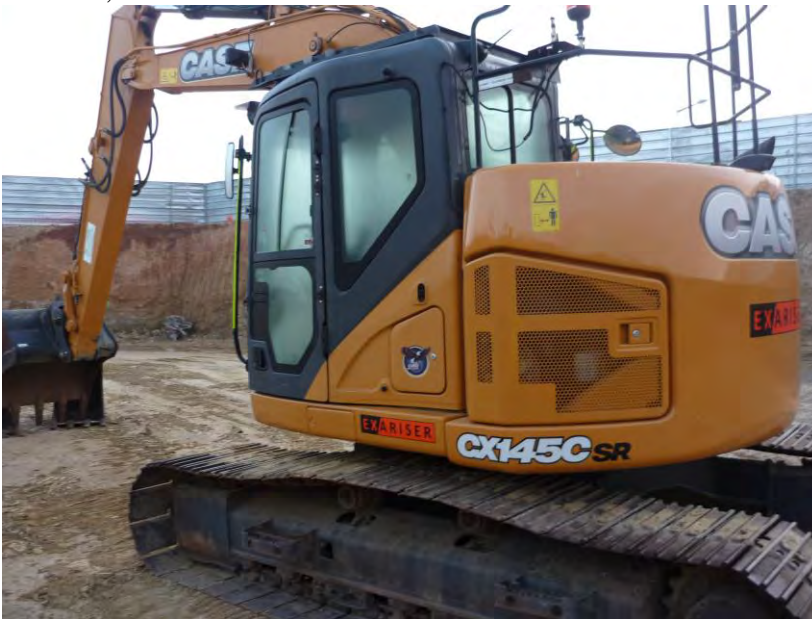
Figura 9. Arribada de l'excavadora giratòria CASE model CX145C_SR amb cadenes, amb pales intercanviables de 1'50 m, 60 i 40 cm d'amplada, en substitució de la màquina anterior el dia 17/02/2020.
