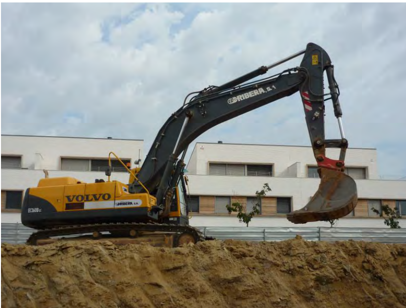
Figura 6. Excavadora giratòria Volvo EC360BLC amb 2 metres cúbics de pala, es va emprar per a l'excavació del terreny.
