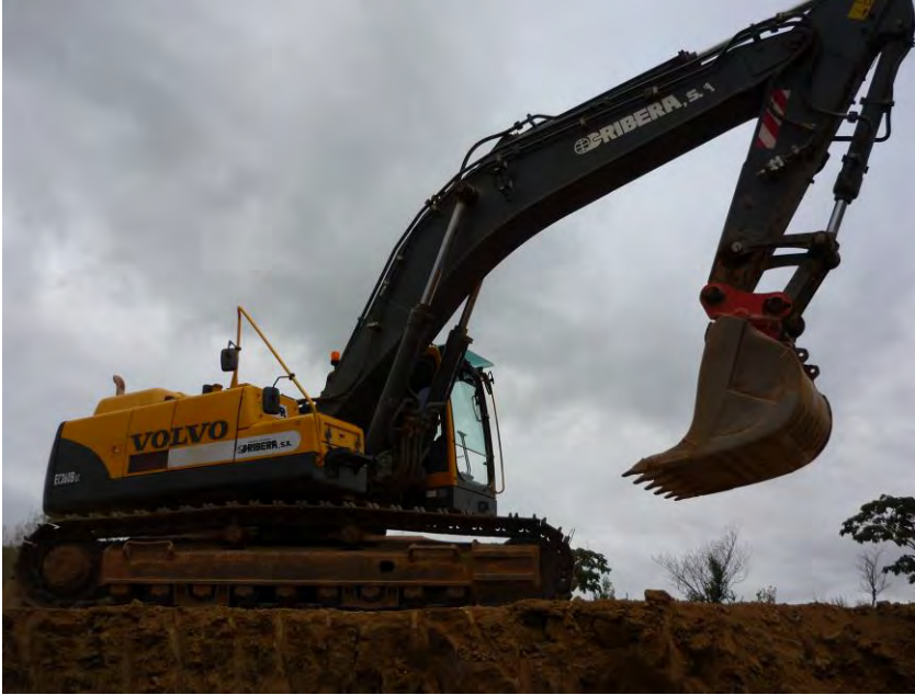
Figura 5. Excavadora giratòria Libherr 914 litronic (Type A914B) amb matrícula E1646BCV, amb cadenes, es va emprar per realitzar l'excavació del terreny.
